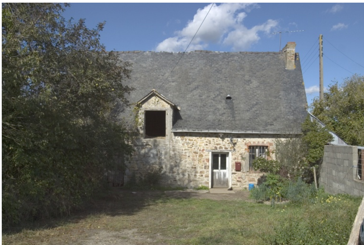
Le bâtiment ouest.
