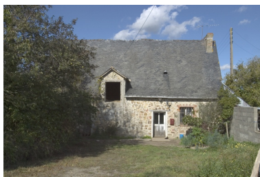
Le bâtiment ouest. Phot. François Lasa IVR52_20045303049NUCA
