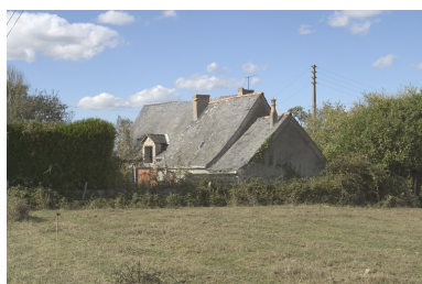
Le bâtiment est vu depuis le sud-est. Phot. François Lasa IVR52_20045303051NUCA
