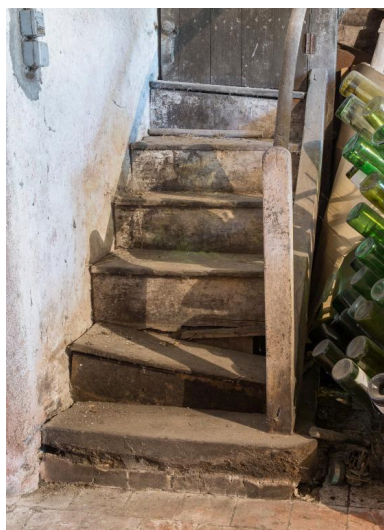
Escalier d'habitation en charpente tournant avec contremarche (détail). Cadastre 2018, B 01-710. Phot. Pierre-Bernard Fourny IVR52_20184400213NUCA
