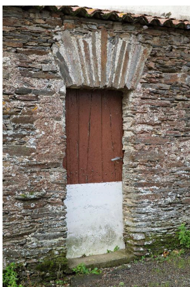
Porte à linteau en plate-bande de schiste, B01-615, cadastre 2018. Phot. Denis Pillet
