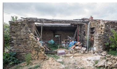
Habitation en rez-de-chaussée à une pièce sous charpente. Cadastré 2018, B 01-278. Phot. Pierre-Bernard Fourny IVR52_20184400256NUCA
