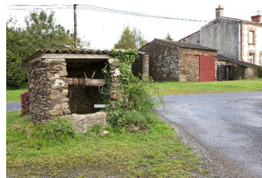
Puits commun, B01-773, cadastre 2018. Phot. Denis Pillet IVR52_20154400468NUCA
