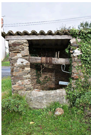
Puits commun, B01-773, cadastre 2018. Phot. Denis Pillet IVR52_20154400466NUCA
