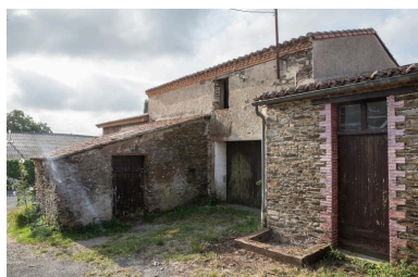
Habitation flanquée d'une dépendance en appentis (cellier ?). Cadastré 2018, B 01-810. Phot. Pierre-Bernard Fourny
