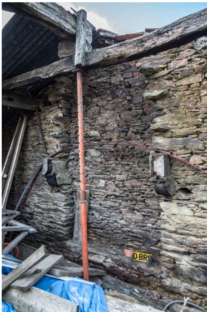
Foyer de cheminée présentant un décroché d'environ 30 cm de profondeur. Cadastre 2018, B 01-278.
