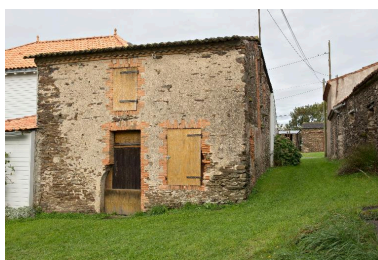
Maison remaniée au XIXe siècle (transformée en cave) en bordure du commun de la Brégeoonnaière, B01-300, cadastre 2018. Phot. Denis Pillet IVR52_20154400464NUCA
