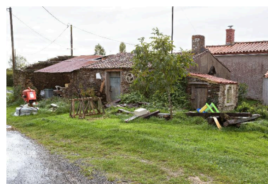
Maisons aux abords du commun de la Brégeonnaière, B01-278-279, cadastre 2018. Phot. Denis Pillet IVR52_20154400457NUCA
