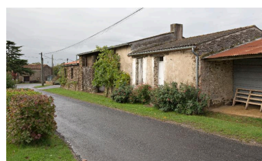
Maisons et grange à piles rondes, B01-702 à 705, cadastre 2018. Phot. Denis Pillet IVR52_20154400471NUCA
