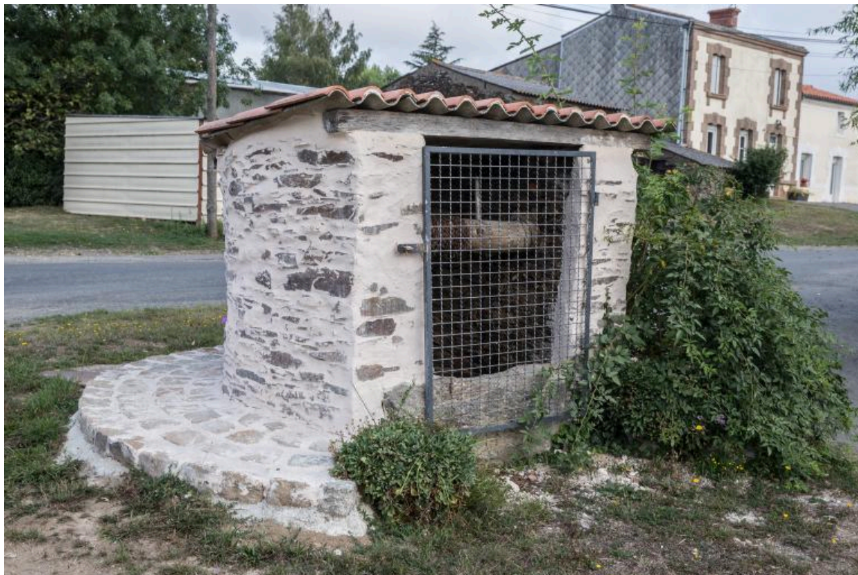
Le puits commun après sa restauration par l'association "les voyettes des bergeons" en 2018.
