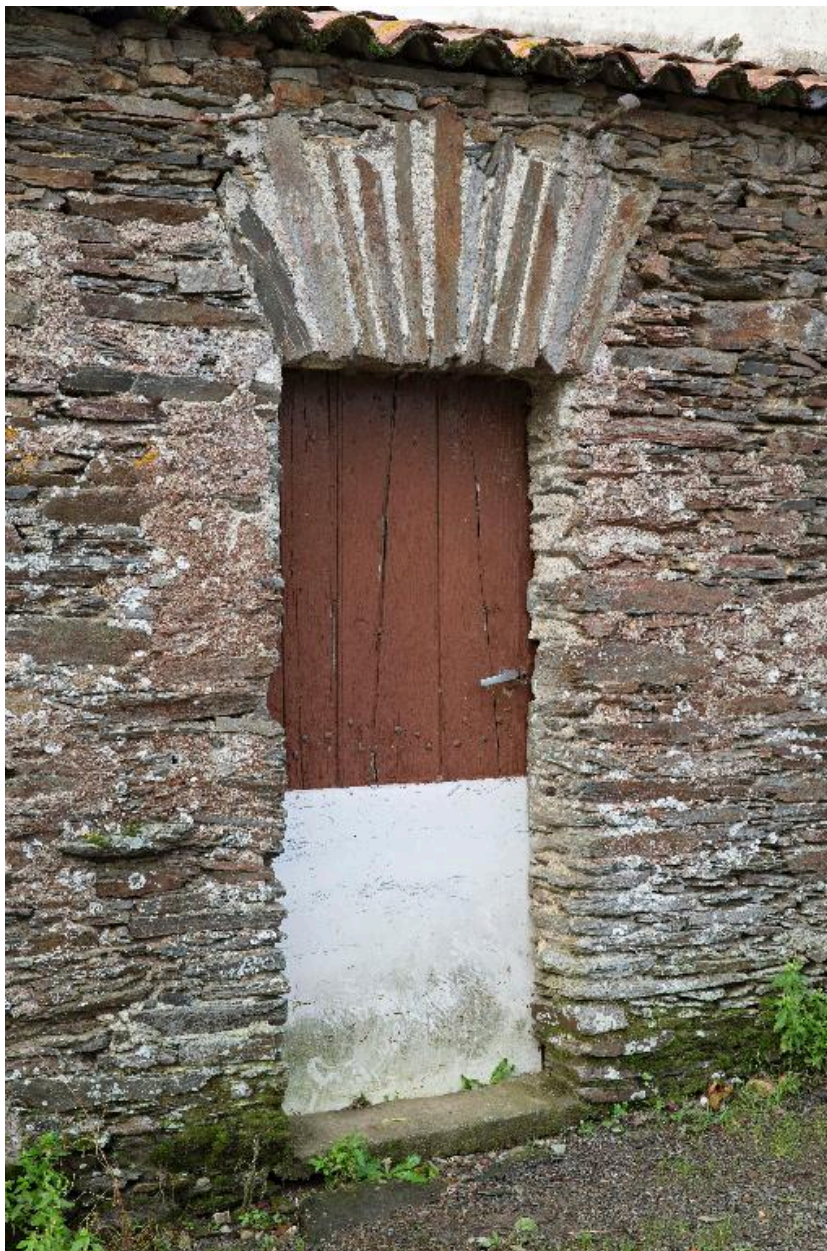
Porte à linteau en plate-bande de schiste, B01-615, cadastre 2018.
