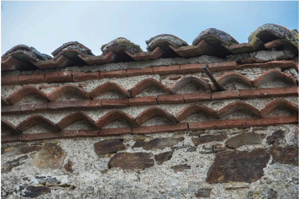
Reprise de toit avec instauration d'une génoise. Cadastre 2018, B 01-710.
