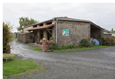
Grange à piles rondes, B01-283, cadastre 2018. Phot. Denis Pillet IVR52_20154400460NUCA
