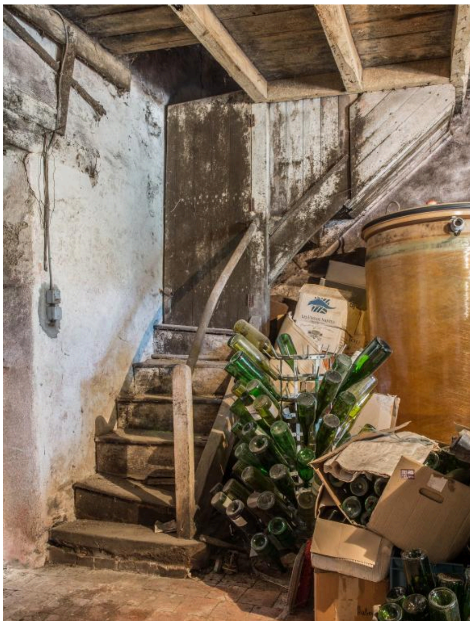
Escalier d'habitation en charpente tournant avec contremarche, fermé par un panneau de bois amovible. Cadastre 2018, B 01-710.
