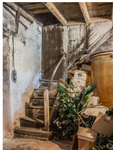
Escalier d'habitation en charpente tournant avec contremarche, fermé par un panneau de bois amovible. Cadastre 2018, B 01-710. Phot. Pierre-Bernard Fourny IVR52_20184400212NUCA
