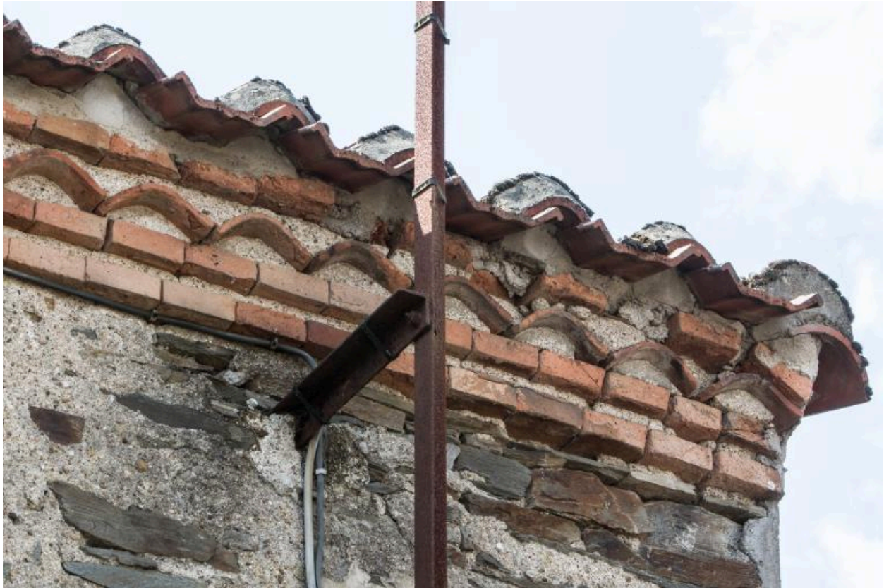
Reprise de toit avec instauration d'une génoise en tuiles et briques. Cadastre 2018, B 01-810
