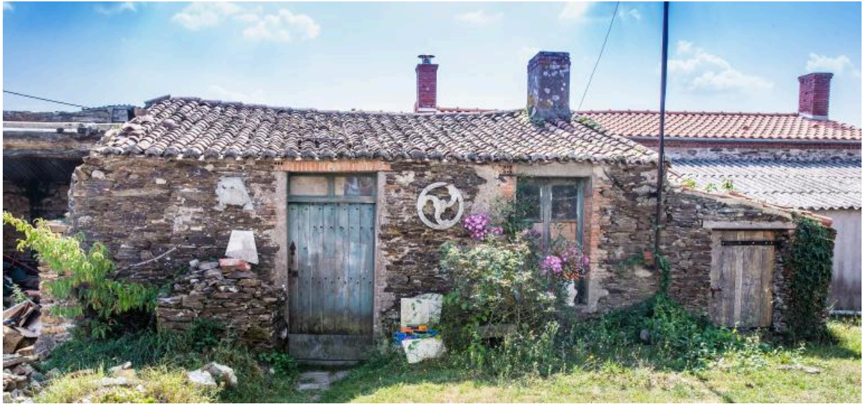
Habitation en rez-de-chaussée à pièce unique sous charpente remaniée au XIXe siècle. Cadastre 2018, B 01-279.
