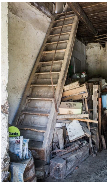
Escalier d'habitation en charpente droit avec contremarche
