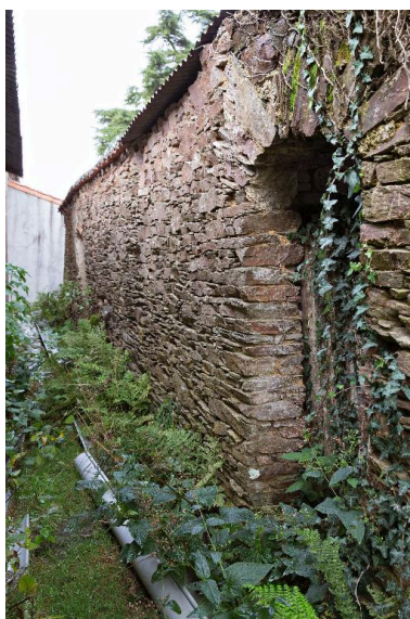
Portes à arc de schiste sur mur gouttereau postérieur de l'habitation, B01-278, cadastre 2018. Phot. Denis Pillet IVR52_20154400459NUCA
