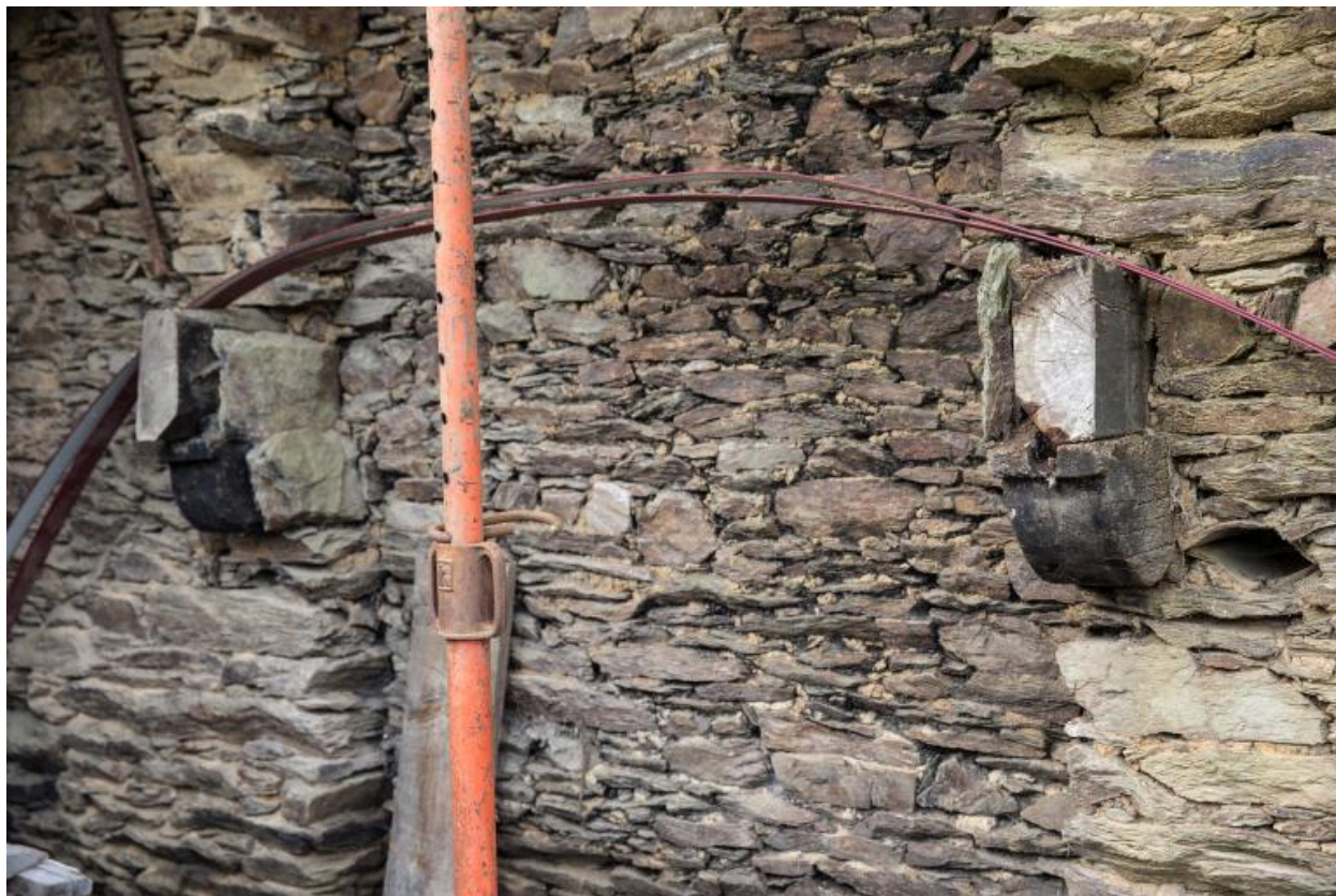
Vestiges des corbeaux de cheminée sculptés en quart-de-rond. A droite, une cavité pour stocker le suif formée par deux tuiles. Cadastre 2018, B 01-278.
