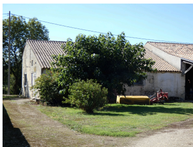
Les dépendances en appentis à l'arrière du logis, vues depuis l'est. Phot. Yannis Suire IVR52_20228500474NUCA
