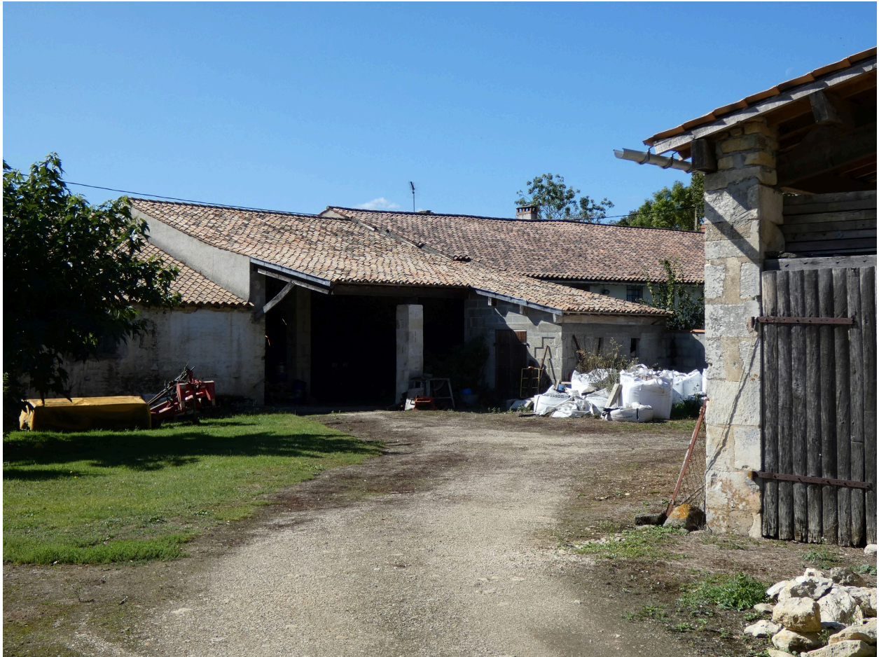
Le hangar côté cour, au nord, vu depuis l'est.
