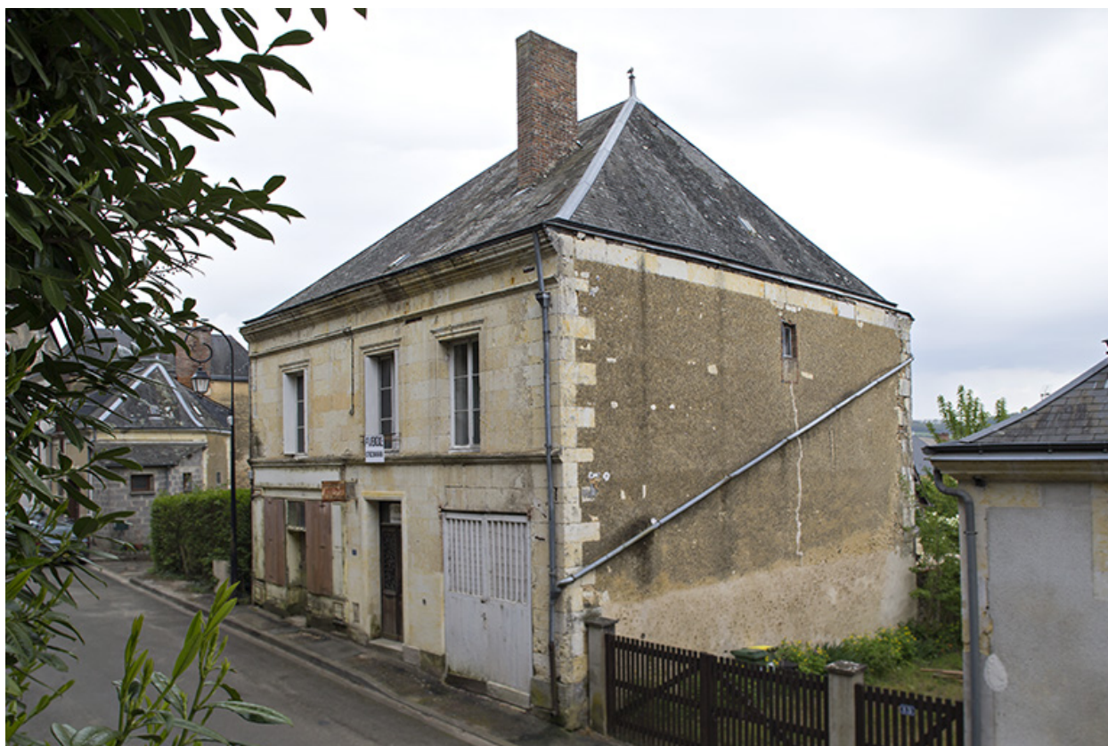
Vue de volume depuis la rue.
