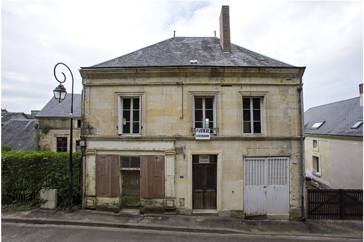
Maison vue de la façade sur rue.
