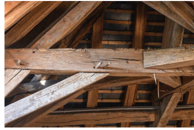
Détail de l'entrait de la fermette, comble du presbytère. Phot. Armelle Maugin IVR52_20244900938NUCA
