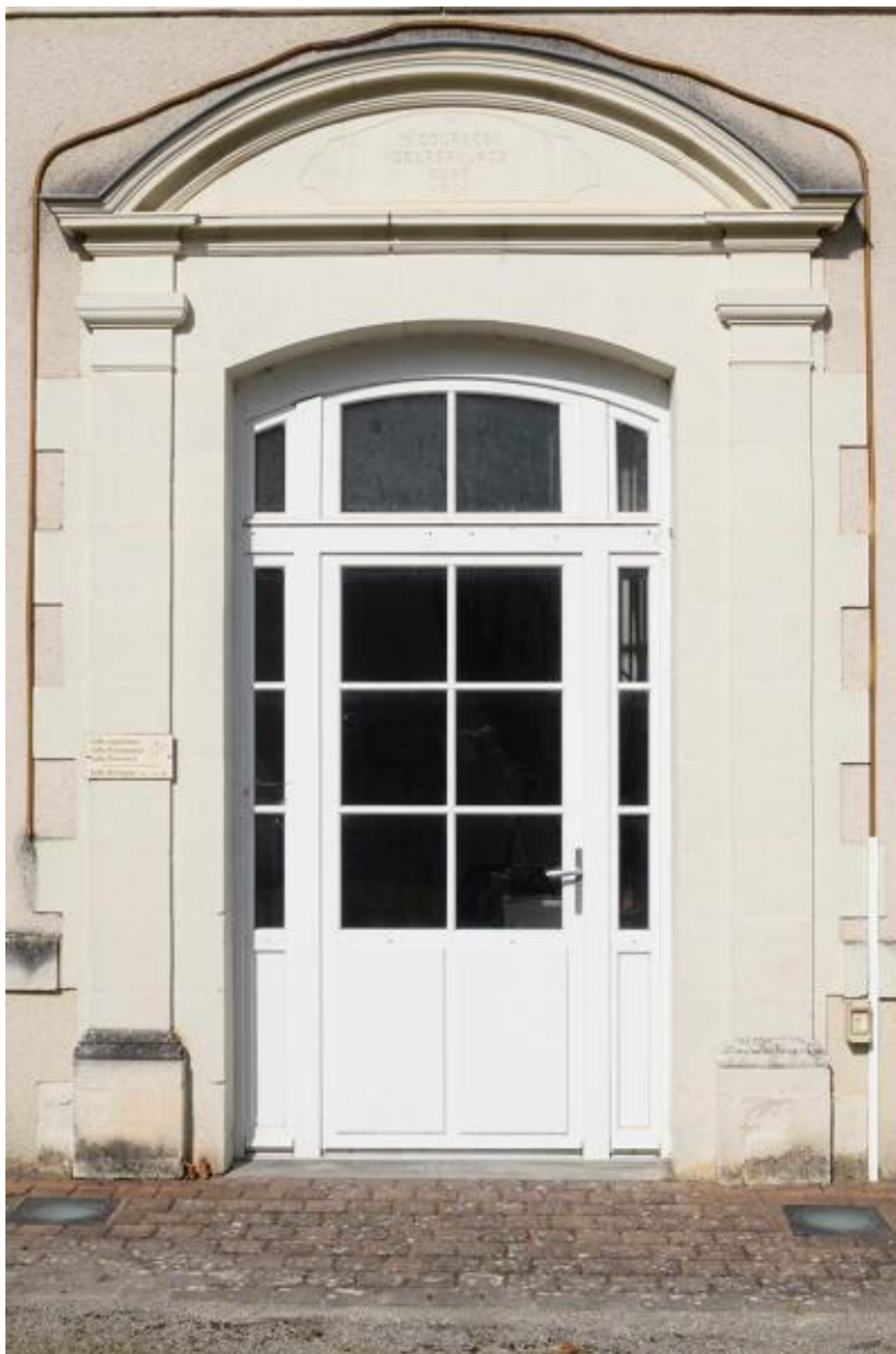
Détail de la porte d'entrée du presbytère, façade est.
