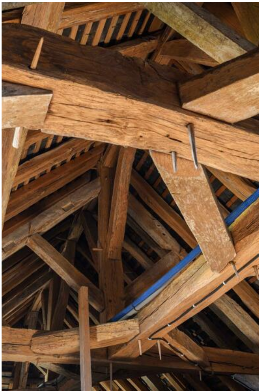
Détail d'une ferme de charpente, comble du presbytère.
