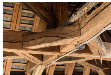
Détail d'une ferme de charpente, comble du presbytère. Phot. Armelle Maugin IVR52_20244900936NUCA
