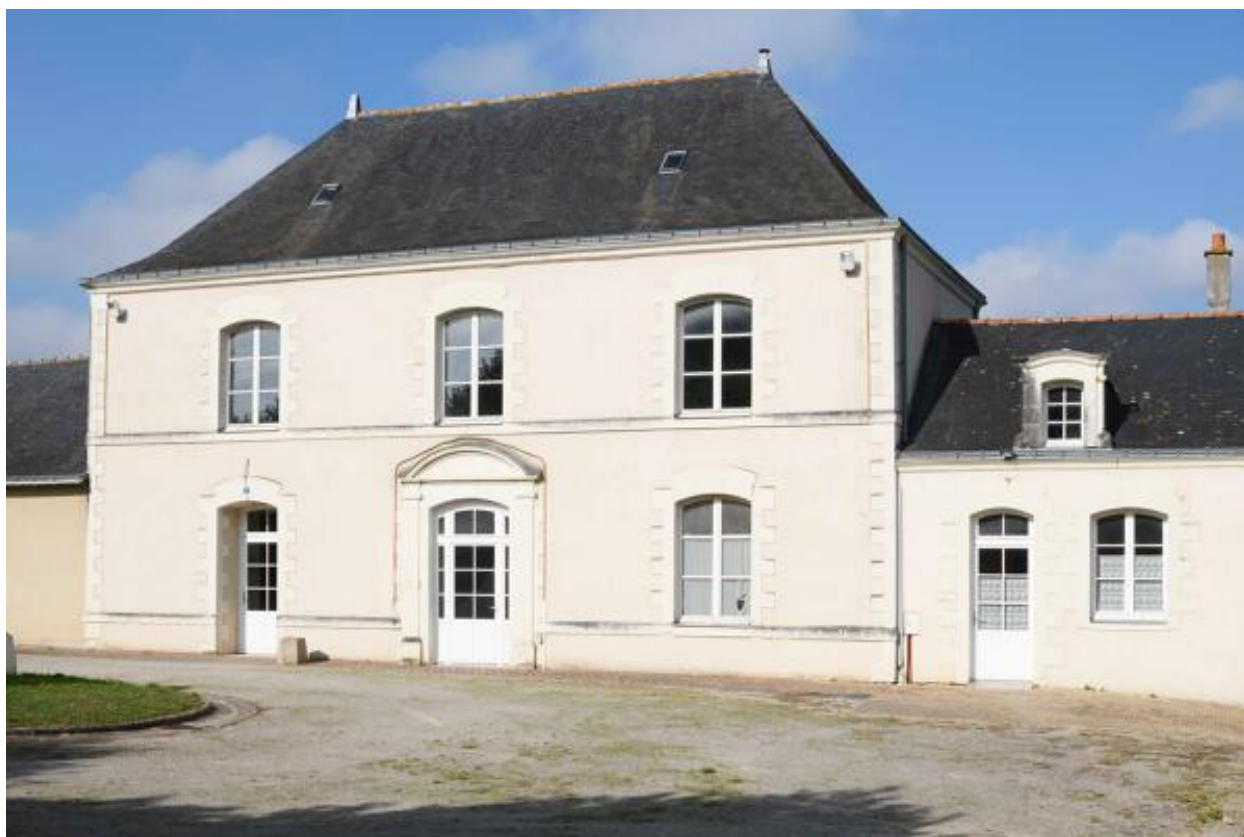
Vue de la façade est du presbytère.
