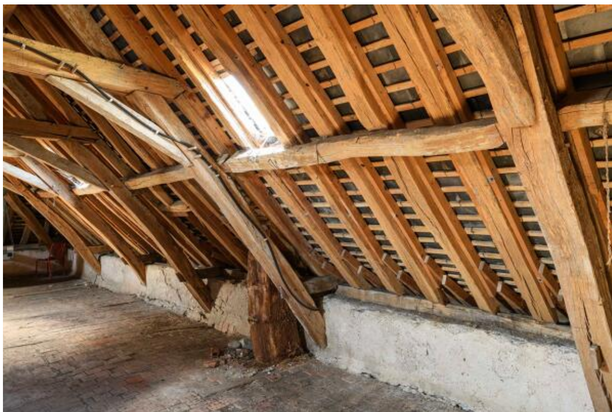
Détail des jambes-de-force, partie est du comble du presbytère.
