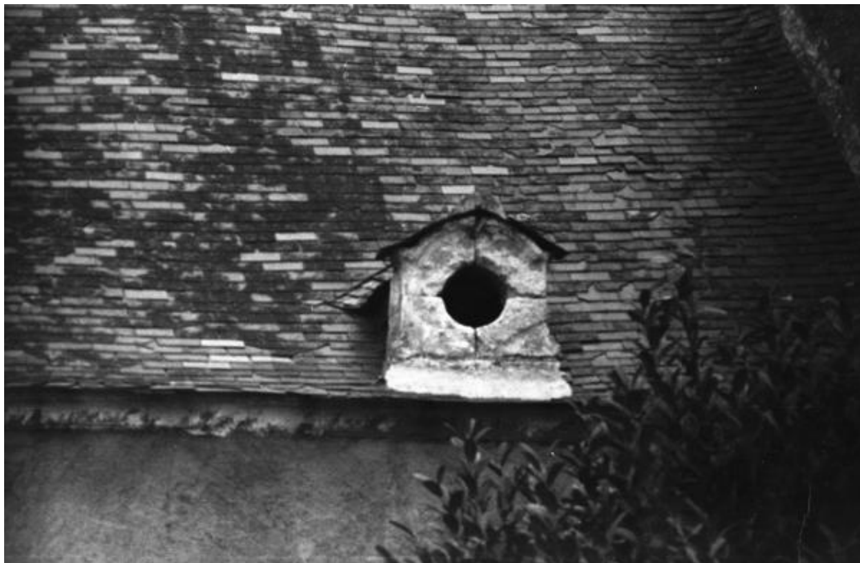
Détail d'un œil-de-bœuf, extension partie nord du presbytère.
