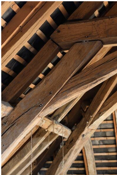
Détail d'un arbalétrier et d'un aisselier, comble du presbytère. Phot. Armelle Maugin IVR52_20244900937NUCA
