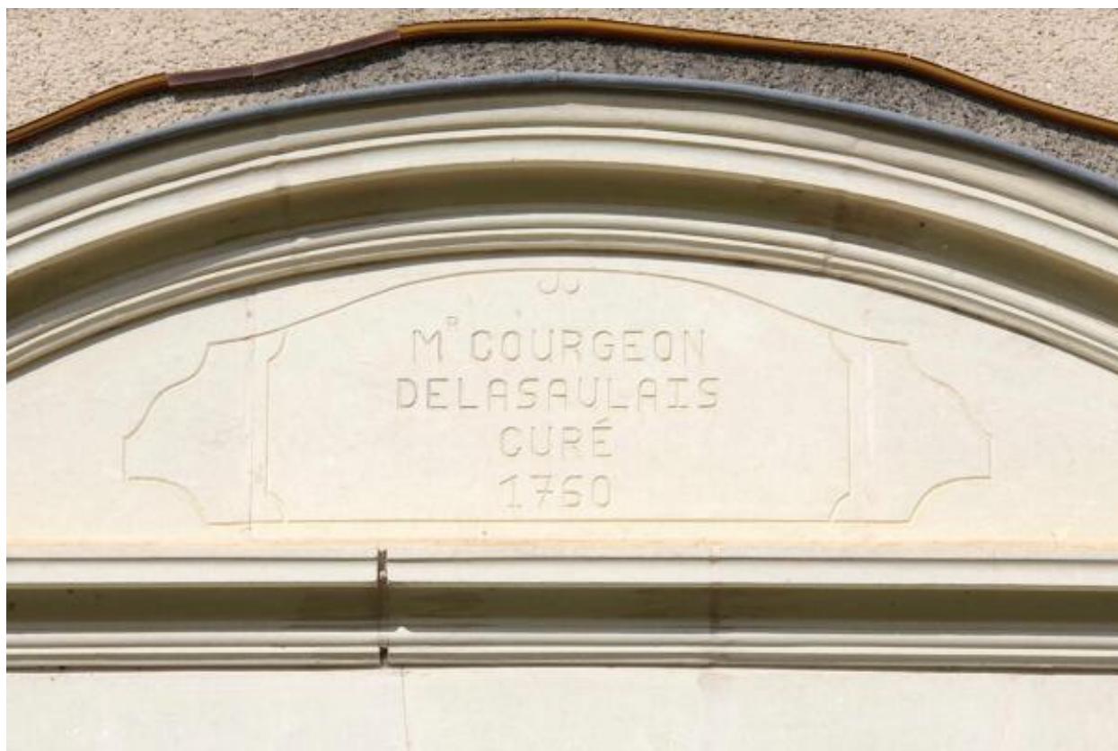
Détail du fronton avec date portée de 1760 de la porte d'entrée du presbytère, façade est.
