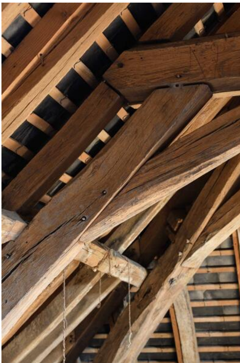
Détail d'un arbalétrier et d'un aisselier, comble du presbytère.
