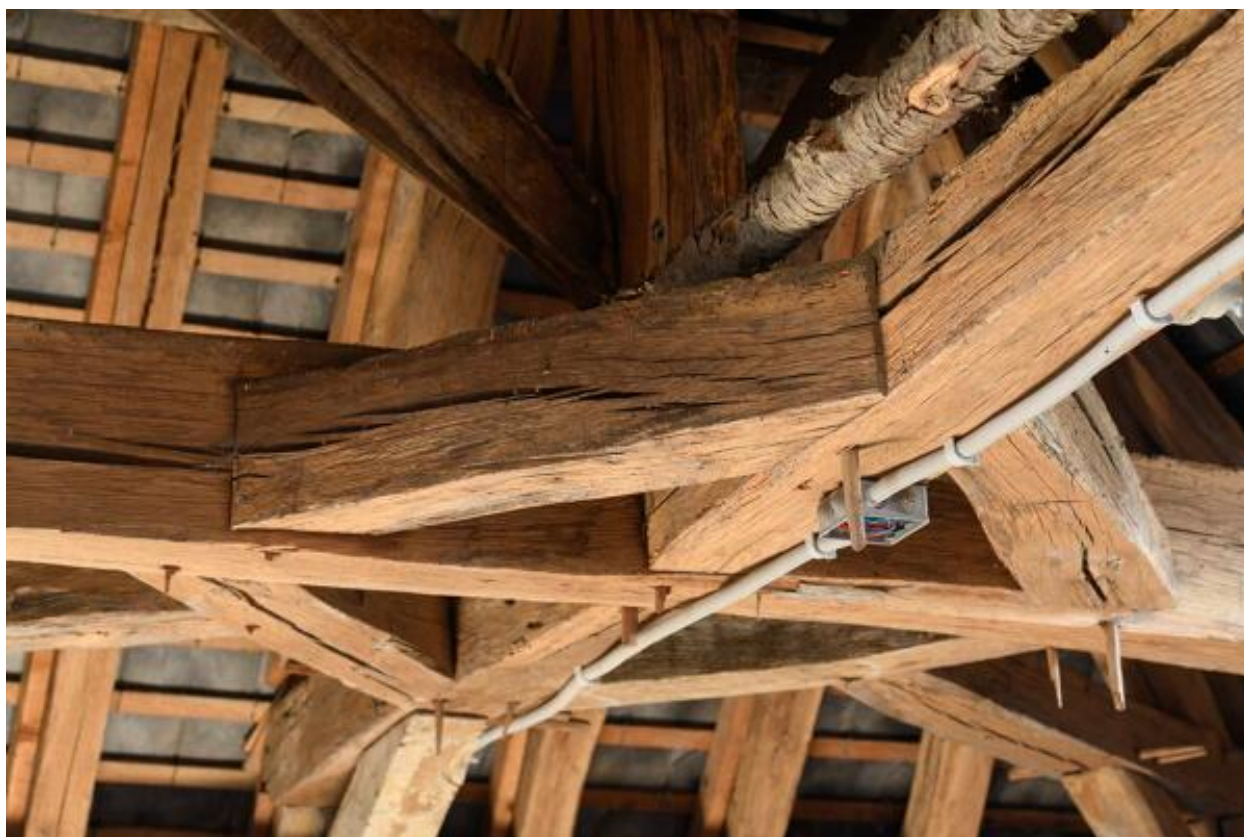
Détail d'une ferme de charpente, comble du presbytère.
