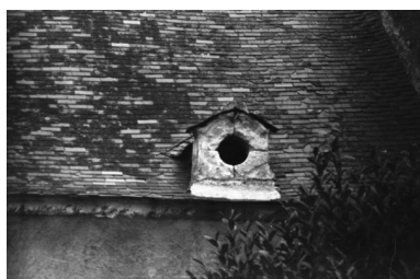
Détail d'un œil-de-bœuf, extension partie nord du presbytère. Phot. Marie-Anne Eon IVR52_19724900514Z
