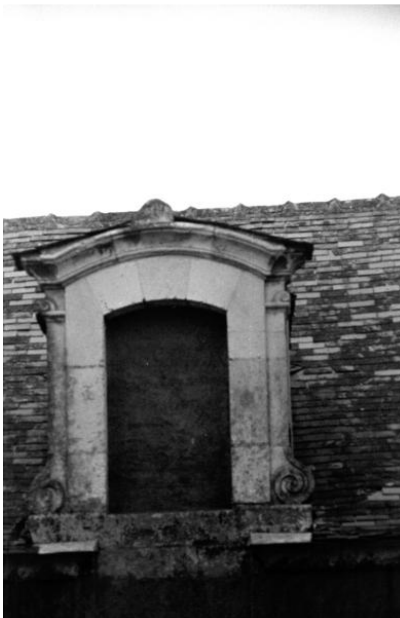
Détail d'une lucarne, corps principal du presbytère.
