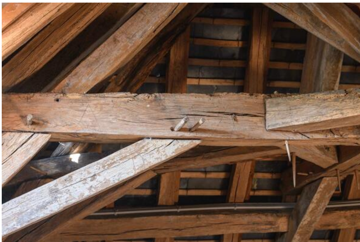
Détail de l'entrait de la fermette, comble du presbytère.
