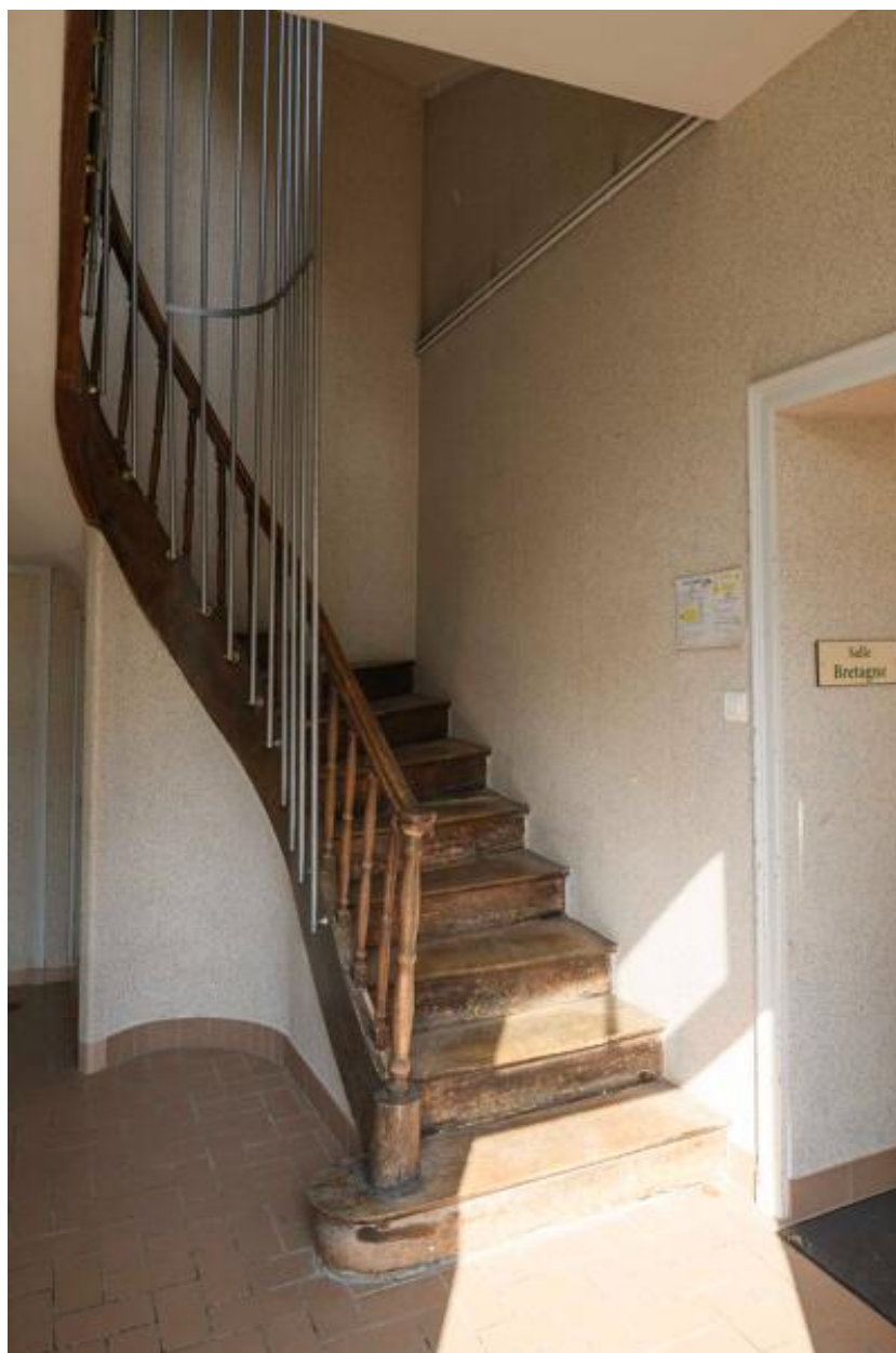
Vue d'ensemble de l'escalier du vestibule, rez-de-chaussée du presbytère.
