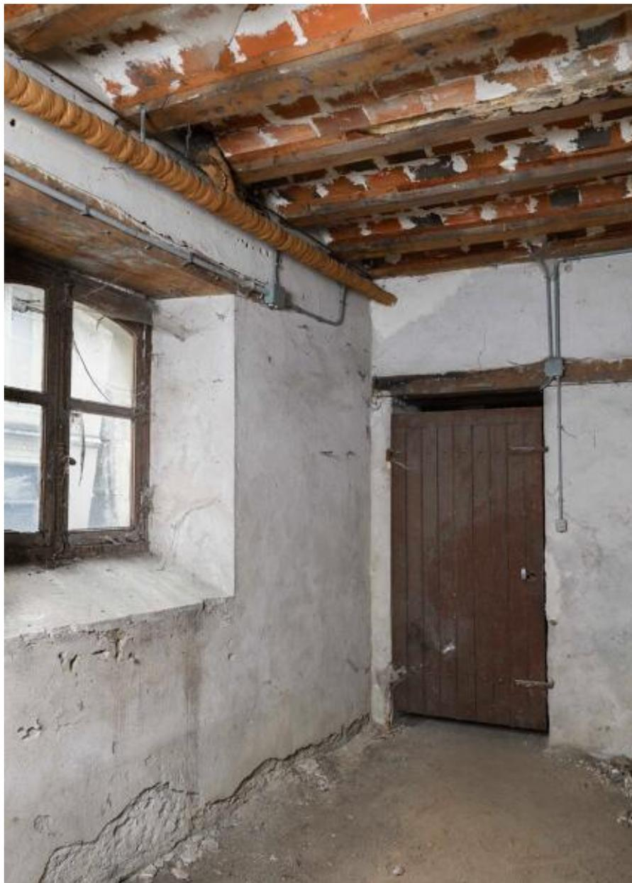
Intérieur, étage de soubassement avec plancher à vouîtains, école de filles, Montjean-sur-Loire.
