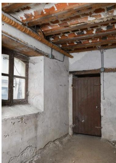
Intérieur, étage de soubassement avec plancher à voûtains, école de filles, Montjean-sur-Loire.
