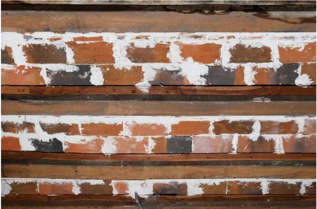
Détail du plancher à voûtains, étage de soubassement, école de filles, Montjean-sur-Loire.
