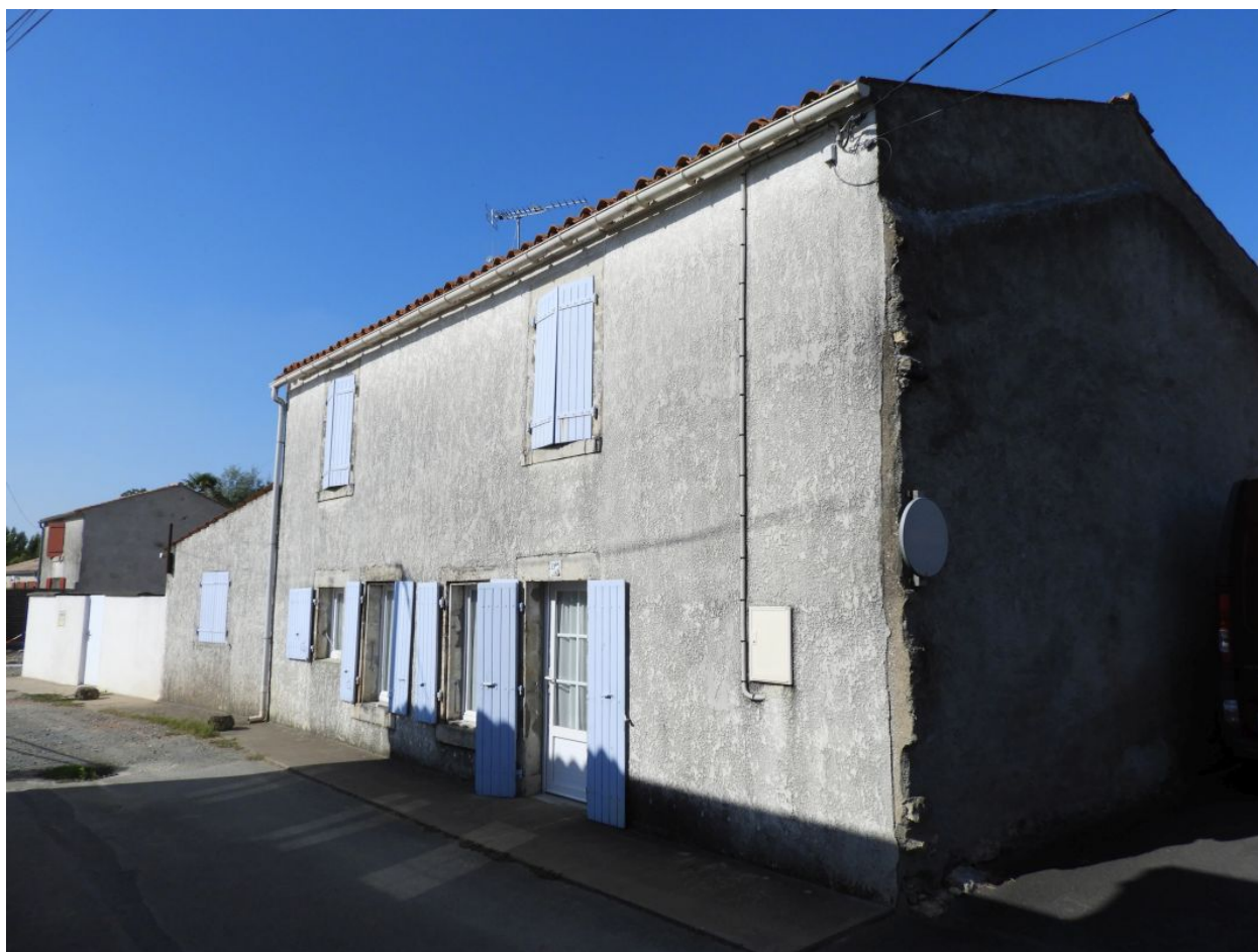
La maison vue depuis le sud, rue Nationale.
