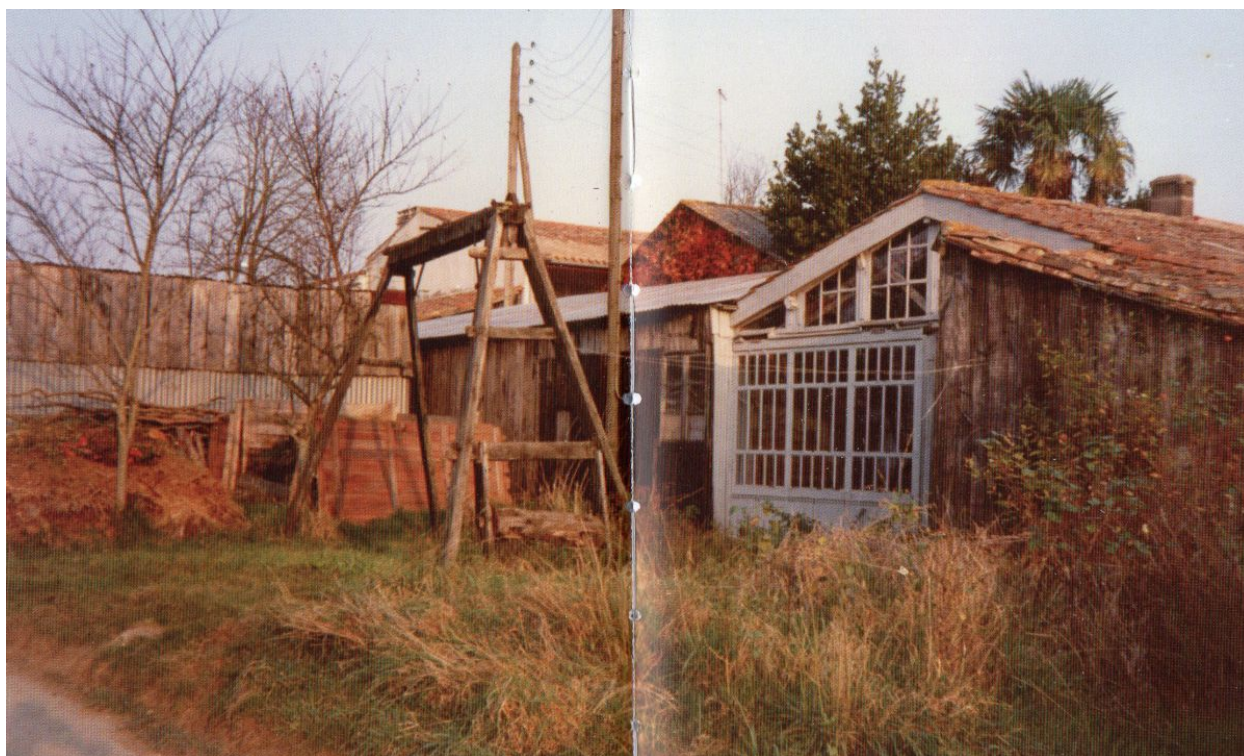
L'ancien atelier au bord du chemin de halage, vu depuis l'ouest vers 1990, avant sa démolition.
