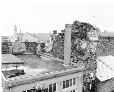
Transept, bras sud : vestiges des faces intérieures sud (à gauche) et ouest (à droite), avec les restes des fenêtres arasées.
