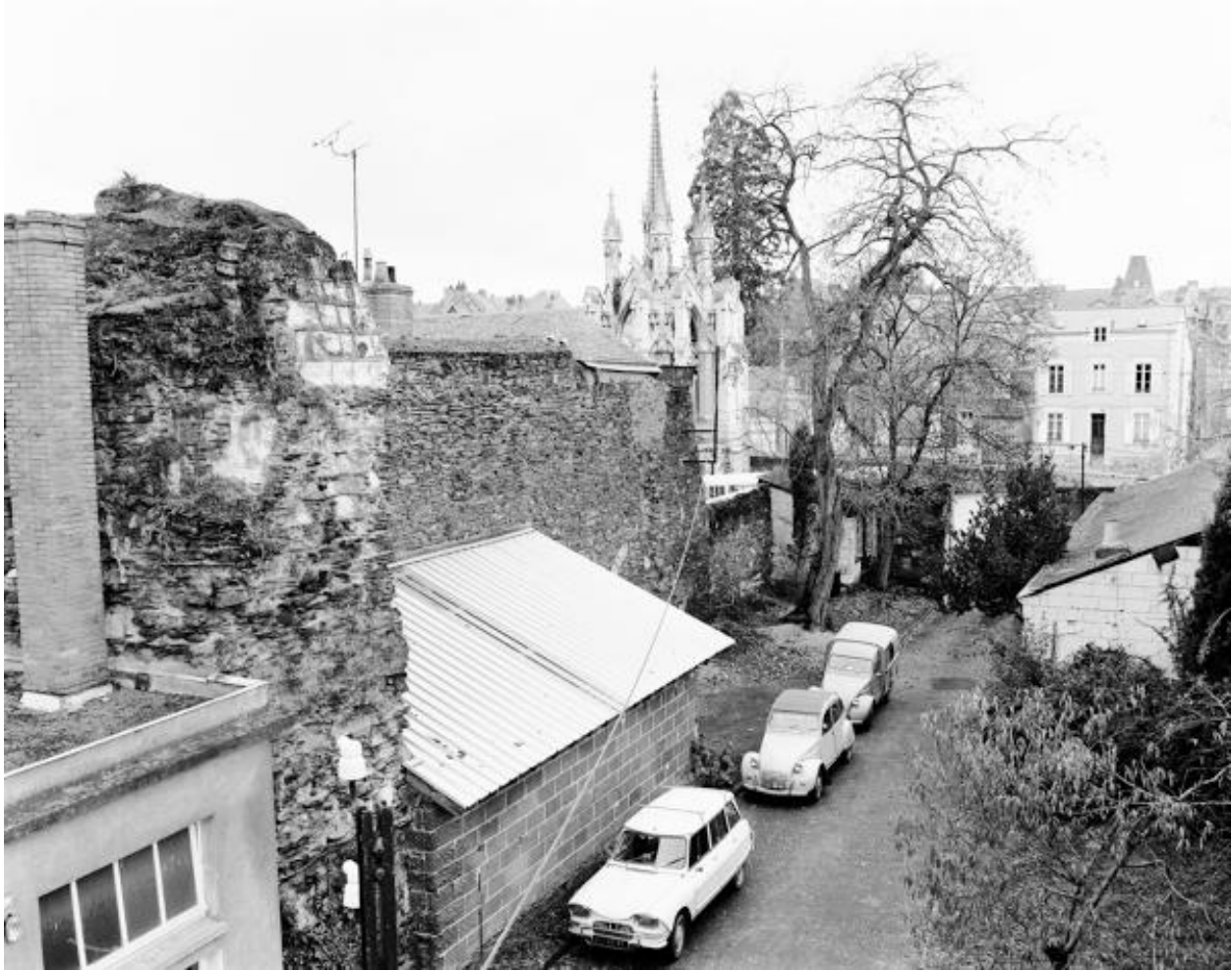
Vestiges de la nef : élévations intérieure sud et ouest, depuis la croisée du transept. Au premier plan à gauche, massif sud de séparation entre nef et transept.
