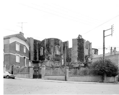
Chevet : vue de situation au sud-est.
