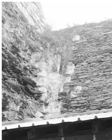
Nef, angle intérieur sud-est : vestige d'un départ de voûte à nervures.
