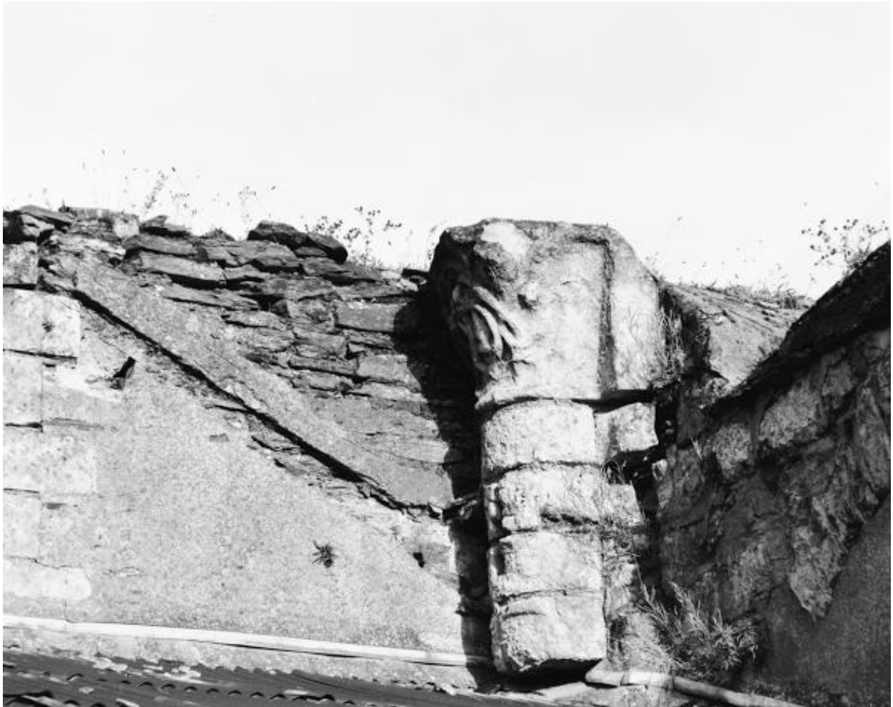
Transept, bras nord, angle intérieur nord-est : détail sur le reste de colonne et chapiteau.
