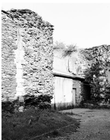
Nef, angle intérieur nord-est et bras nord du transept avec la porte en plein cintre de l'escalier du clocher. Au 1er plan, vestiges de la colonne d'angle de la voûte septentrionale de la nef et arrachement du massif nord entre nef et transept.
