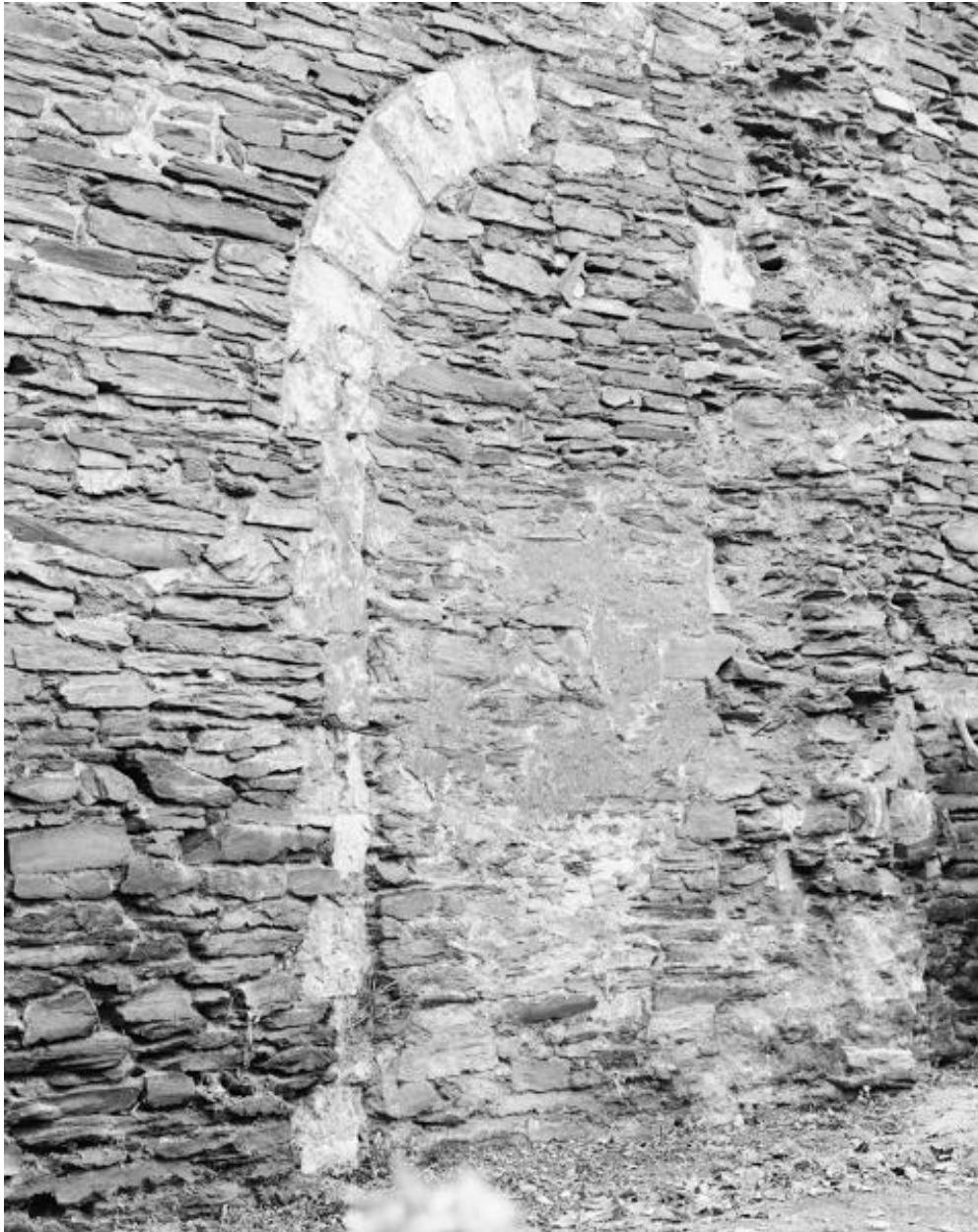
Nef, élévation intérieure sud : vestige d'une porte.
