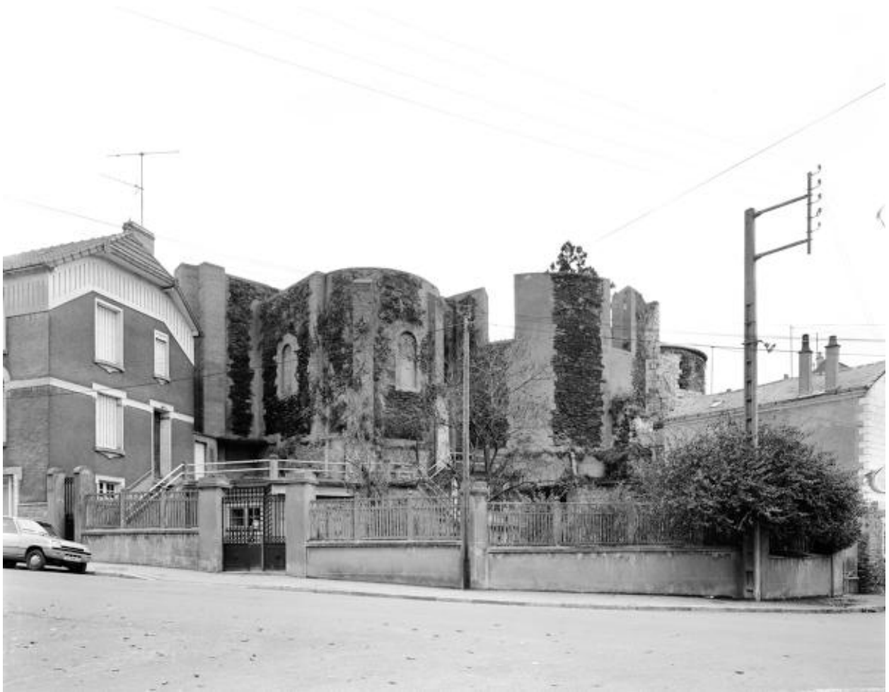
Chevet : vue de situation au sud-est.
