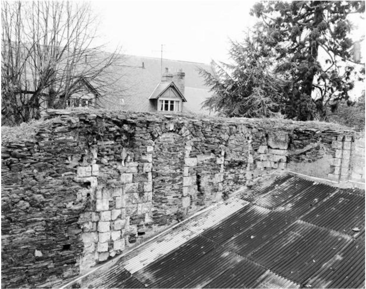
Transept, bras nord, élévation intérieure ouest, partie haute : les fenêtres.
