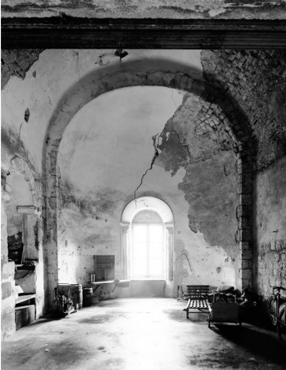
Absidiole nord : élévation intérieure, vers l'est.
