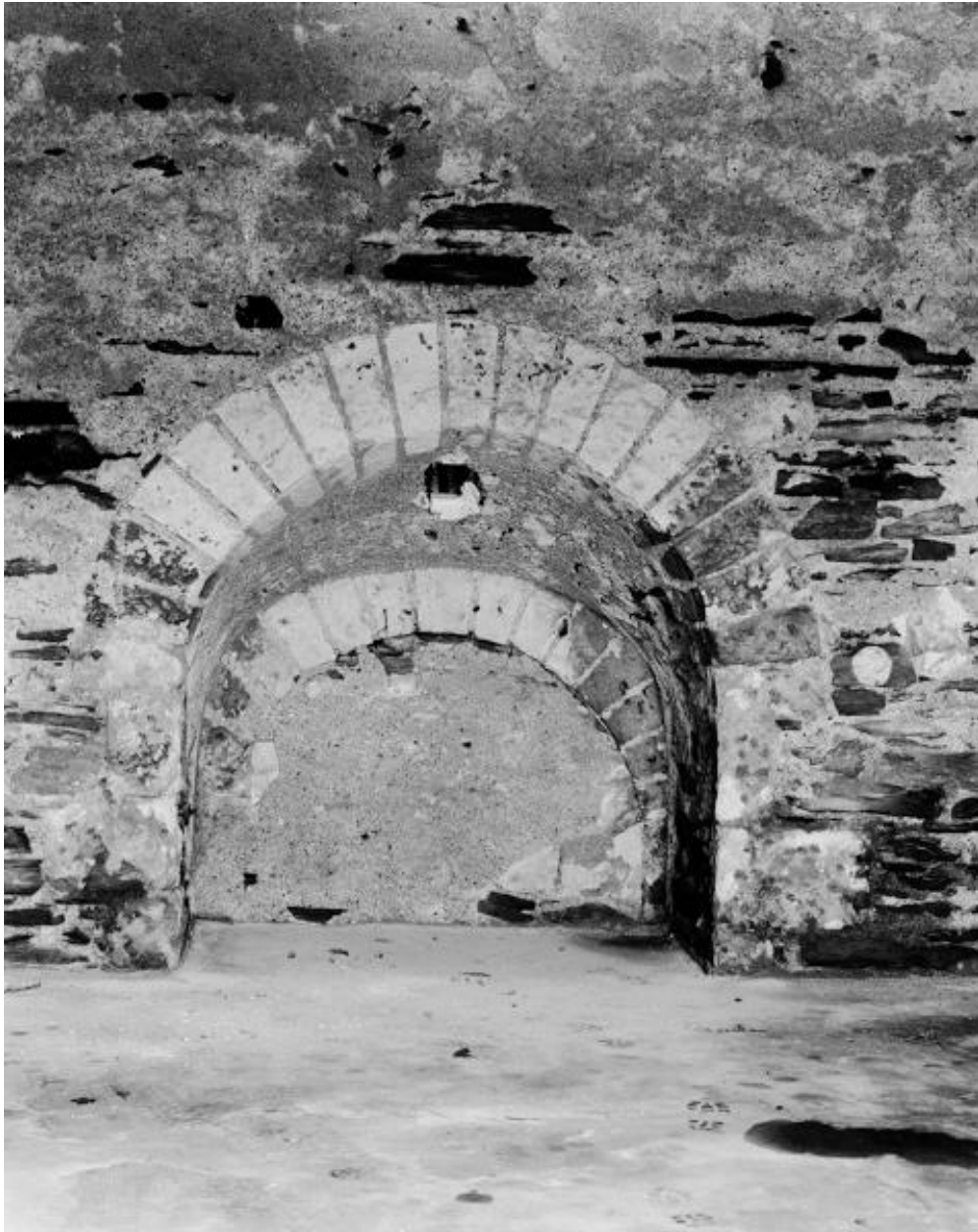
Transept, bras nord, élévation intérieure nord, partie inférieure : détail sur la porte murée.
