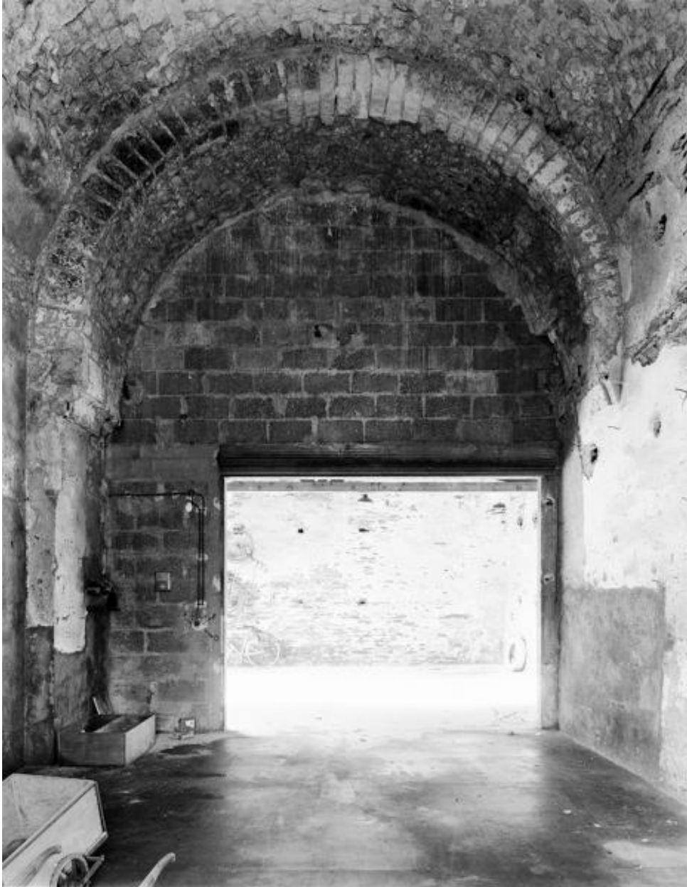
Absidiole nord : élévation intérieure, vers l'ouest.
