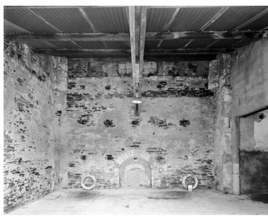
Transept, bras nord, élévation intérieure nord : partie inférieure.
