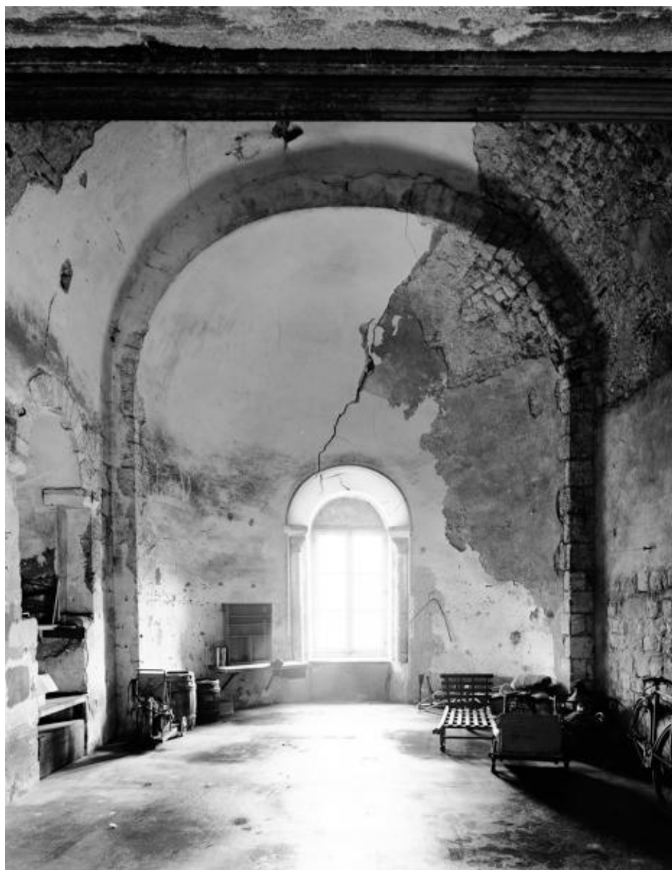
Absidiole nord : élévation intérieure, vers l'est.
