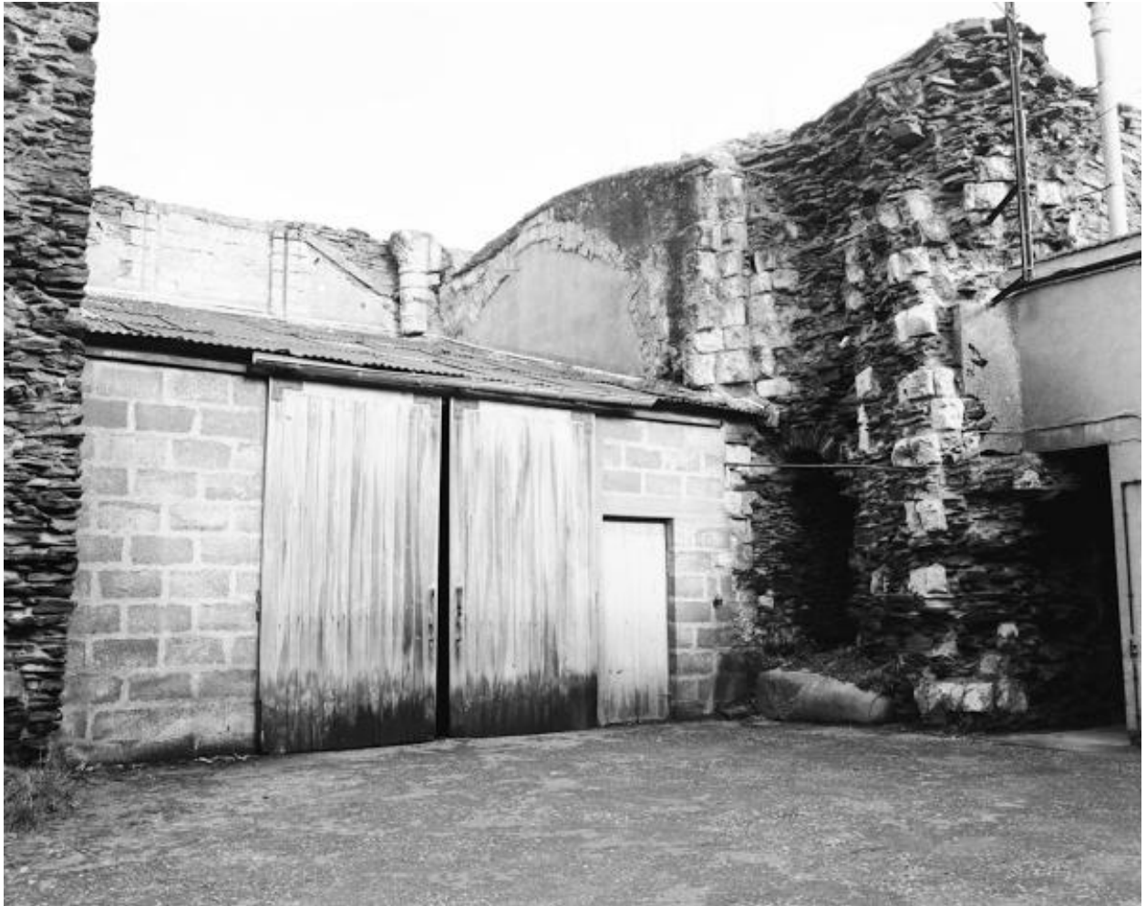
Transept, bras nord, élévations intérieures nord (à gauche) et est (à droite) : parties hautes.
