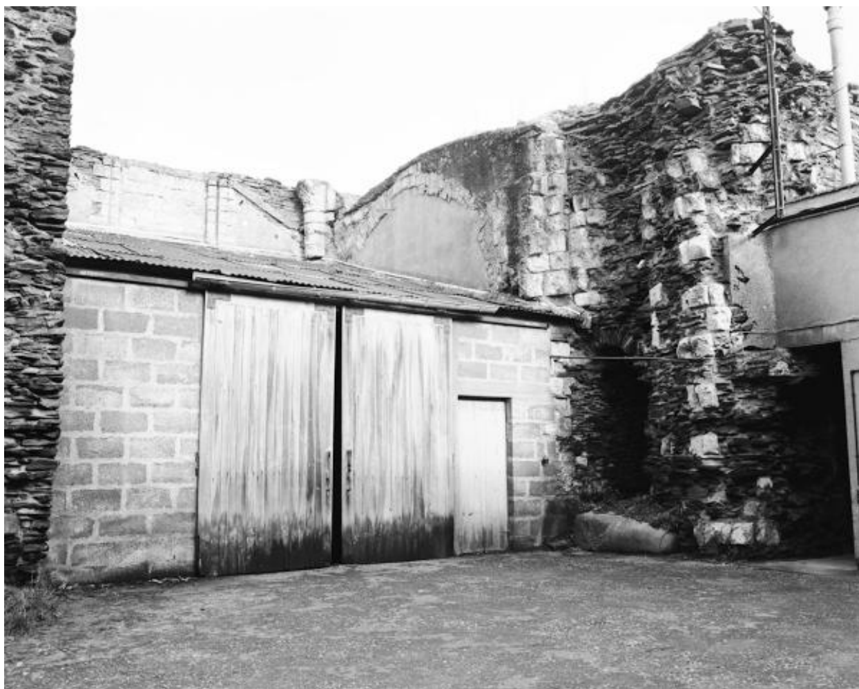
Transept, bras nord, élévations intérieures nord (à gauche) et est (à droite) : parties hautes.
