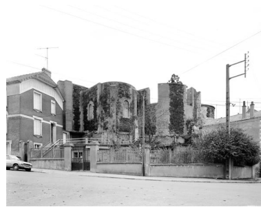
Chevet : vue de situation au sud-est.
