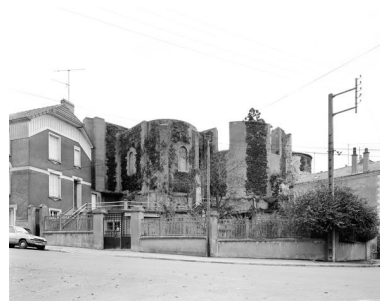
Chevet : vue de situation au sud-est.
