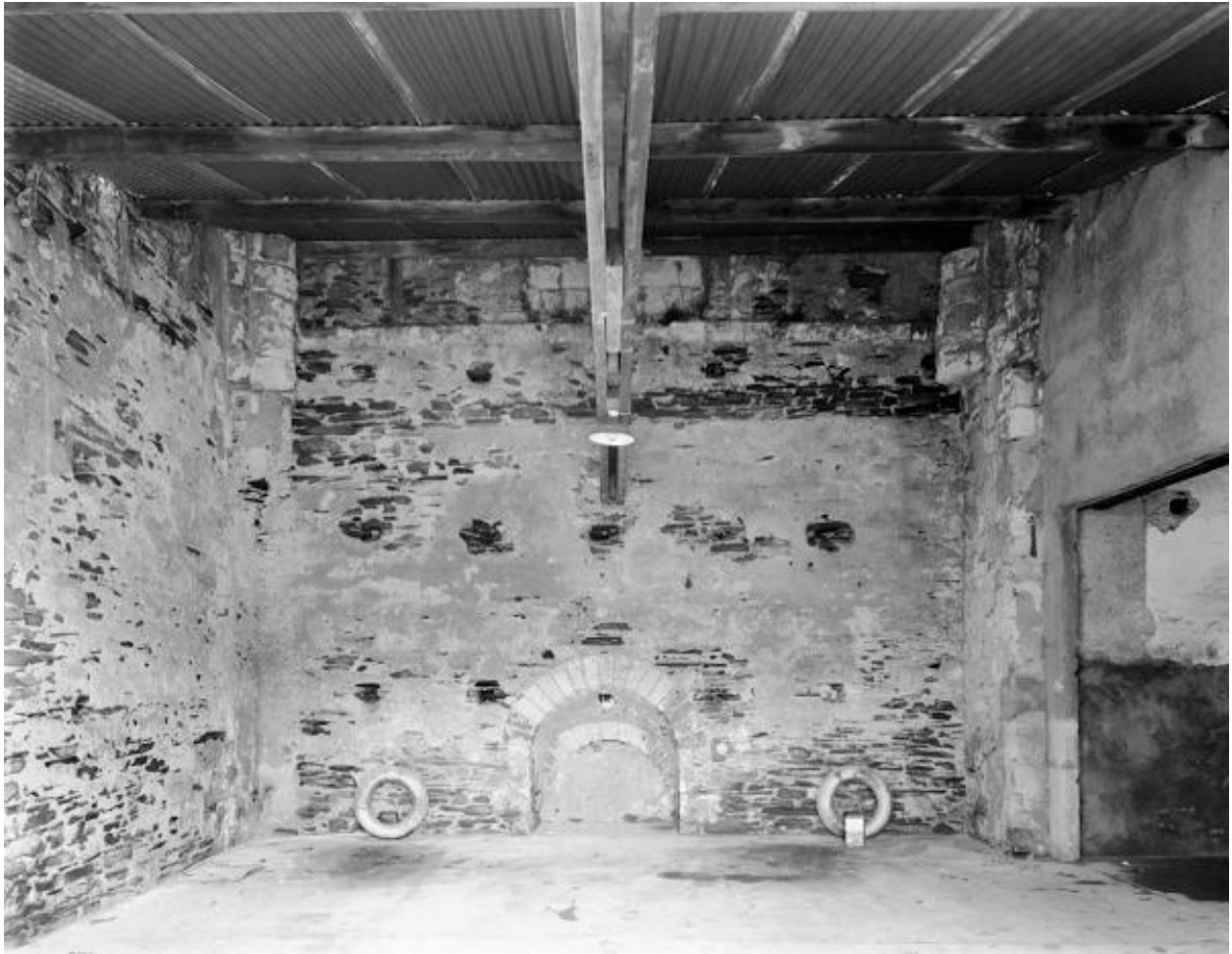
Transept, bras nord, élévation intérieure nord : partie inférieure.
