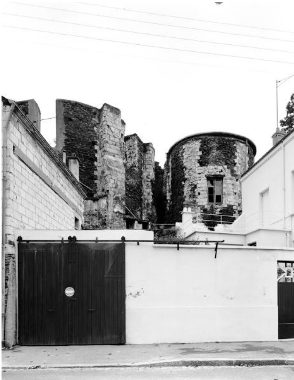
Chevet et absidiole nord, murs extérieurs, depuis l'est.
