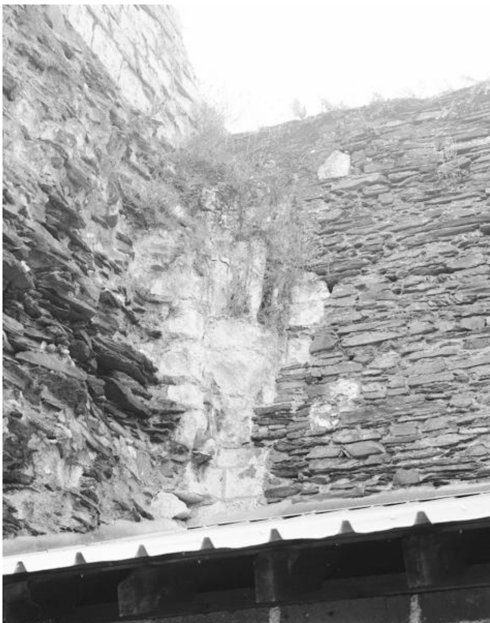
Nef, angle intérieur sud-est : vestige d'un départ de voûte à nervures.
