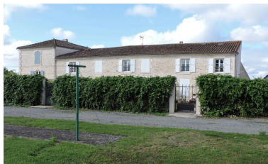
L'ancien logement en retour d'équerre à l'arrière du logis, vu depuis l'est.
