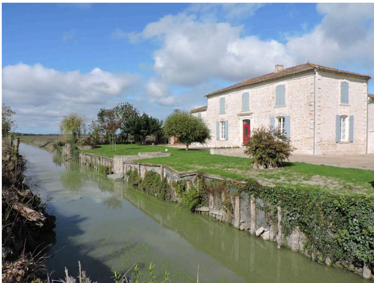
Le logis de ferme au bord du Petit canal de la Société, vus depuis l'est.
