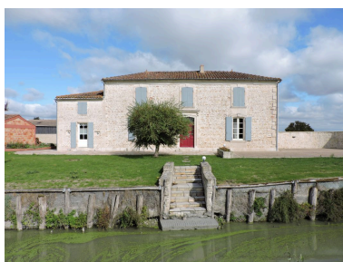
Le logis et son accès au canal vus depuis le sud.
