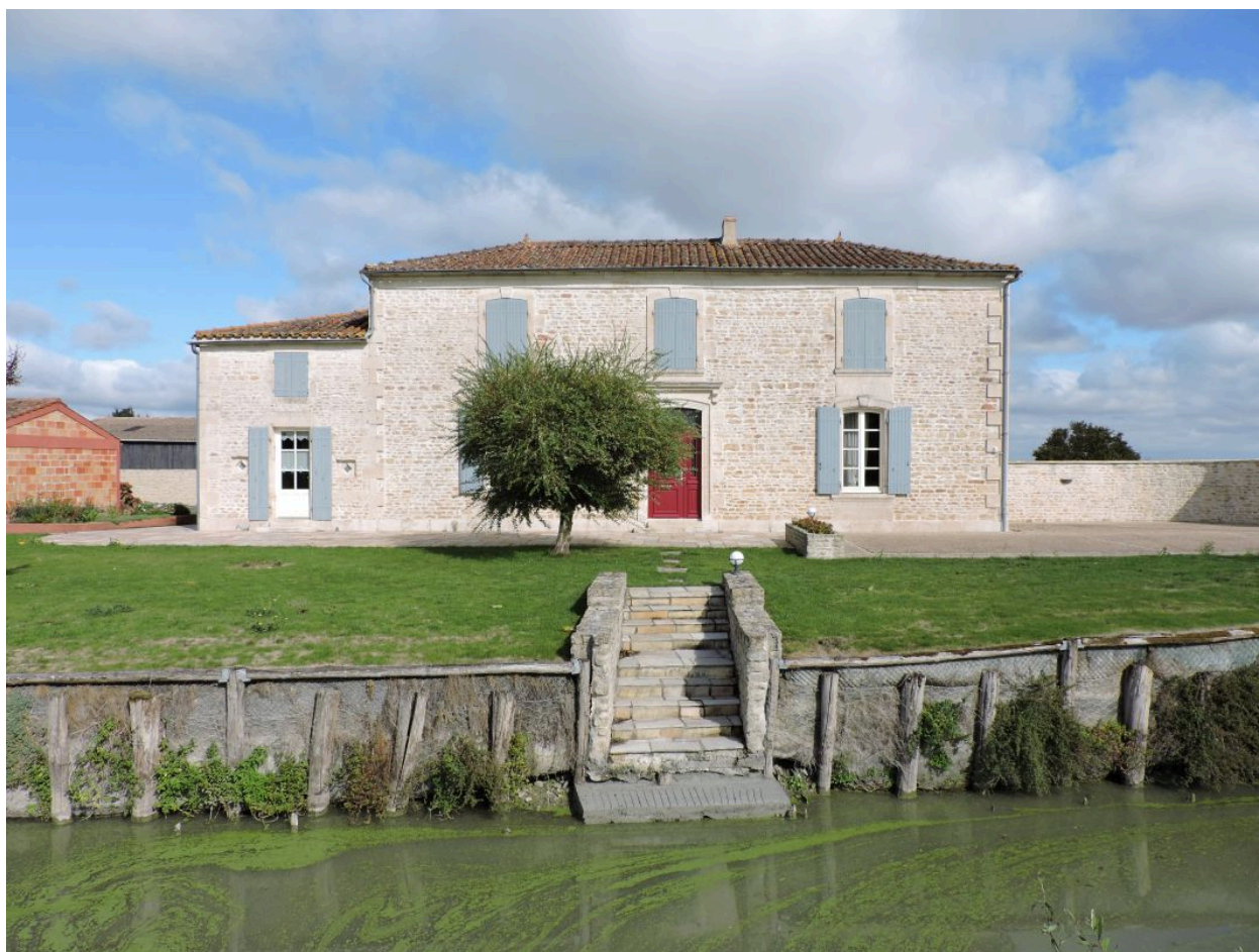
Le logis et son accès au canal vus depuis le sud.
