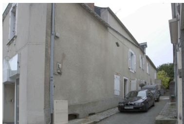
Vue depuis l'entrée de la ruelle. La maison est la deuxième en partant de la gauche. Phot. François Lasa IVR52_20045303264NUCA
