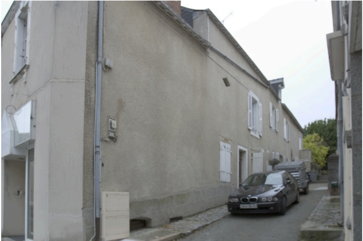
Vue depuis l'entrée de la ruelle. La maison est la deuxième en partant de la gauche.
