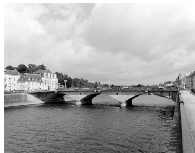
Vue d'ensemble depuis la rive gauche en aval.
