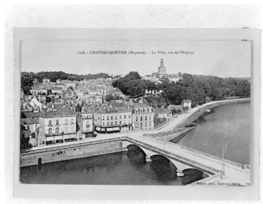
Le pont vu depuis la rive gauche en aval.
