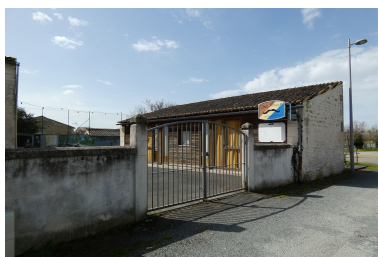
Le préau dans l'angle nord de la cour nord, vu depuis l'est. Phot. Yannis Suire IVR52_20238501093NUCA
