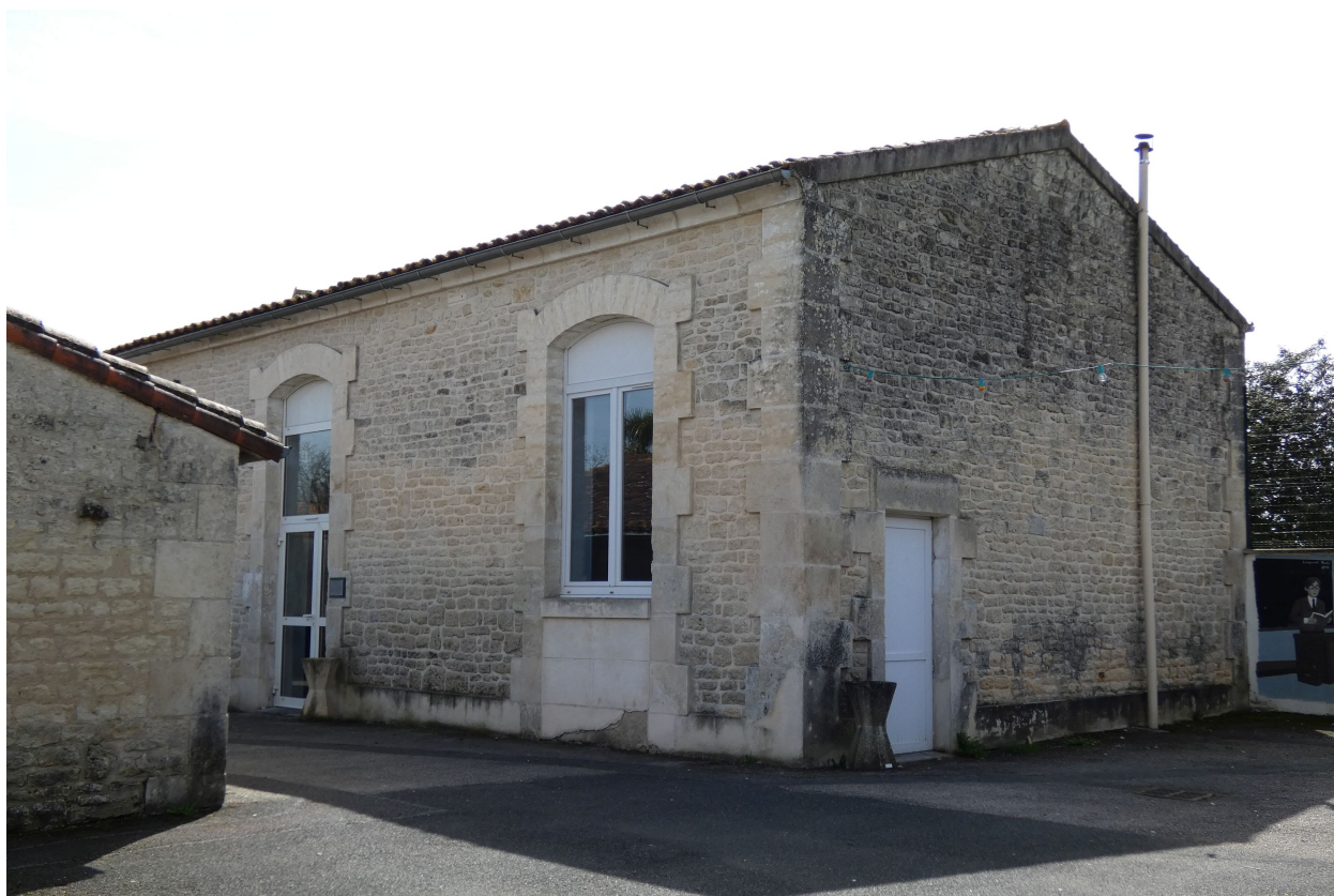
Le bâtiment de classe vu depuis le nord.
