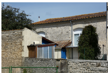
Le bâtiment de classe vu depuis le sud. Phot. Yannis Suire IVR52_20238501099NUCA
