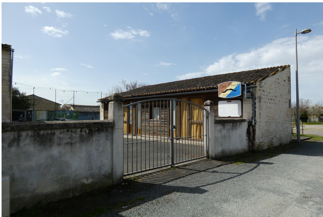
Le préau dans l'angle nord de la cour nord, vu depuis l'est.
