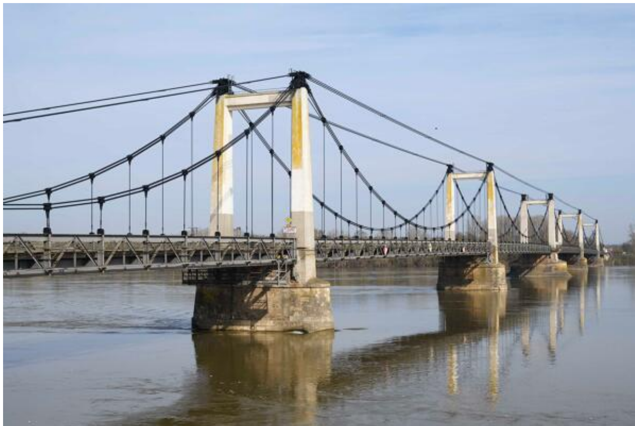
Vue d'ensemble du pont routier depuis les quais à l'est.
