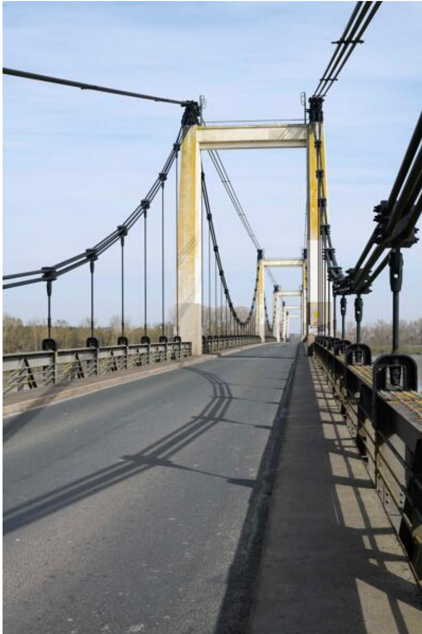
Détail de l'entrée sud et du tablier.
