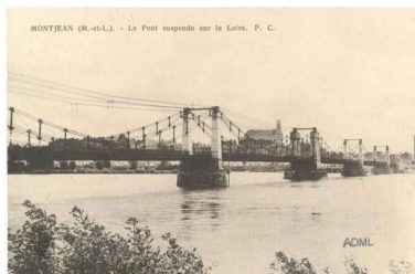
Vue d'ensemble du premier pont de Montjean modernisé par des suspensions en arc à trois articulations en 1927. Carte postale, photographie prise avant son effondrement en 1935. IVR52_20254900045NUCA
