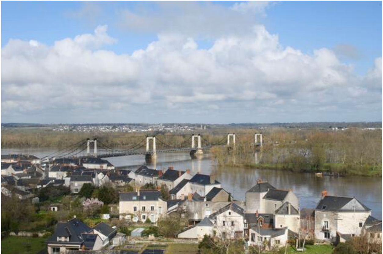
Vue d'ensemble du pont routier de Montjean depuis la ville-haute.
