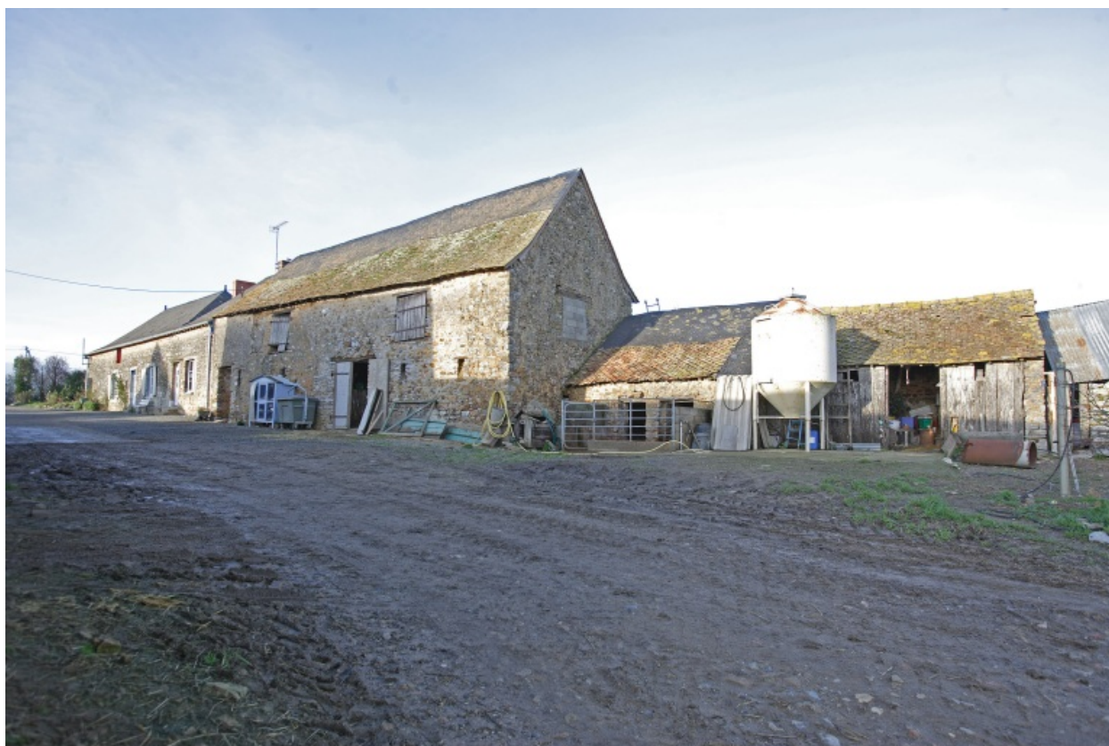
Le logis-fournil, l'étable-grange et la porcherie-bûcher vus depuis le sud-est.
