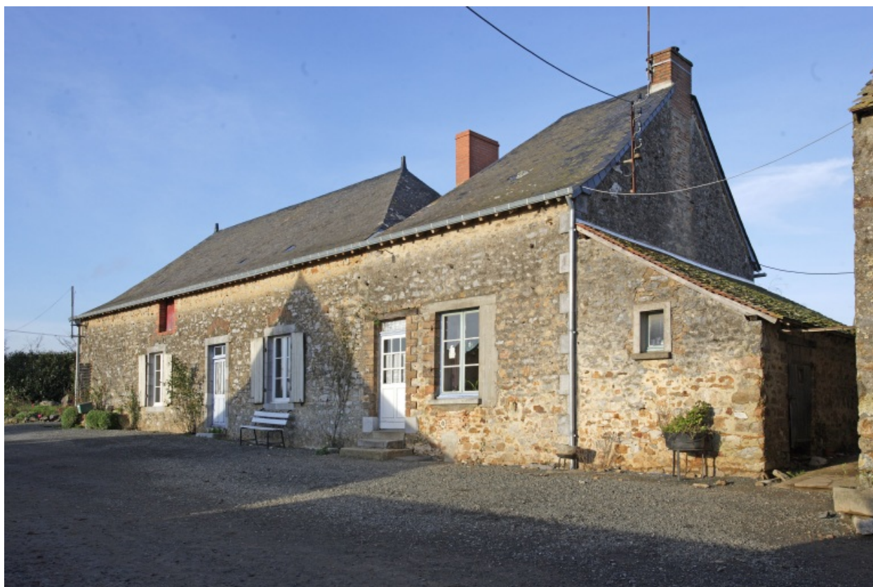
Le logis-fournil vu depuis le sud-est.
