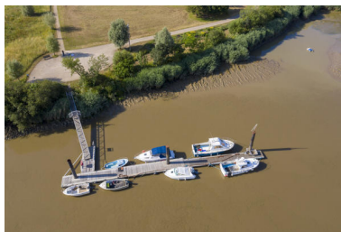
Ponton en Loire du Site Bikini. Phot. Pierre-Bernard Fourny IVR52_20214400598NUCA
