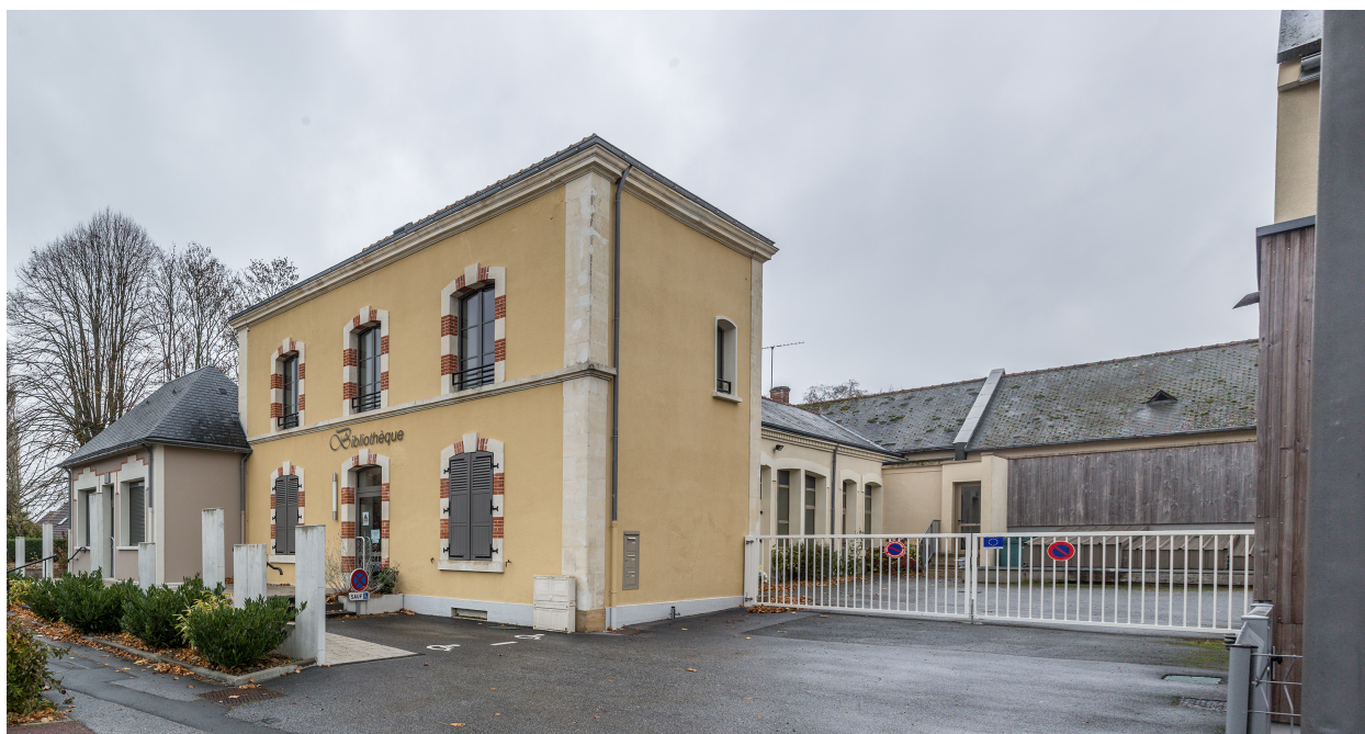
Une vue d'ensemble de l'école.
