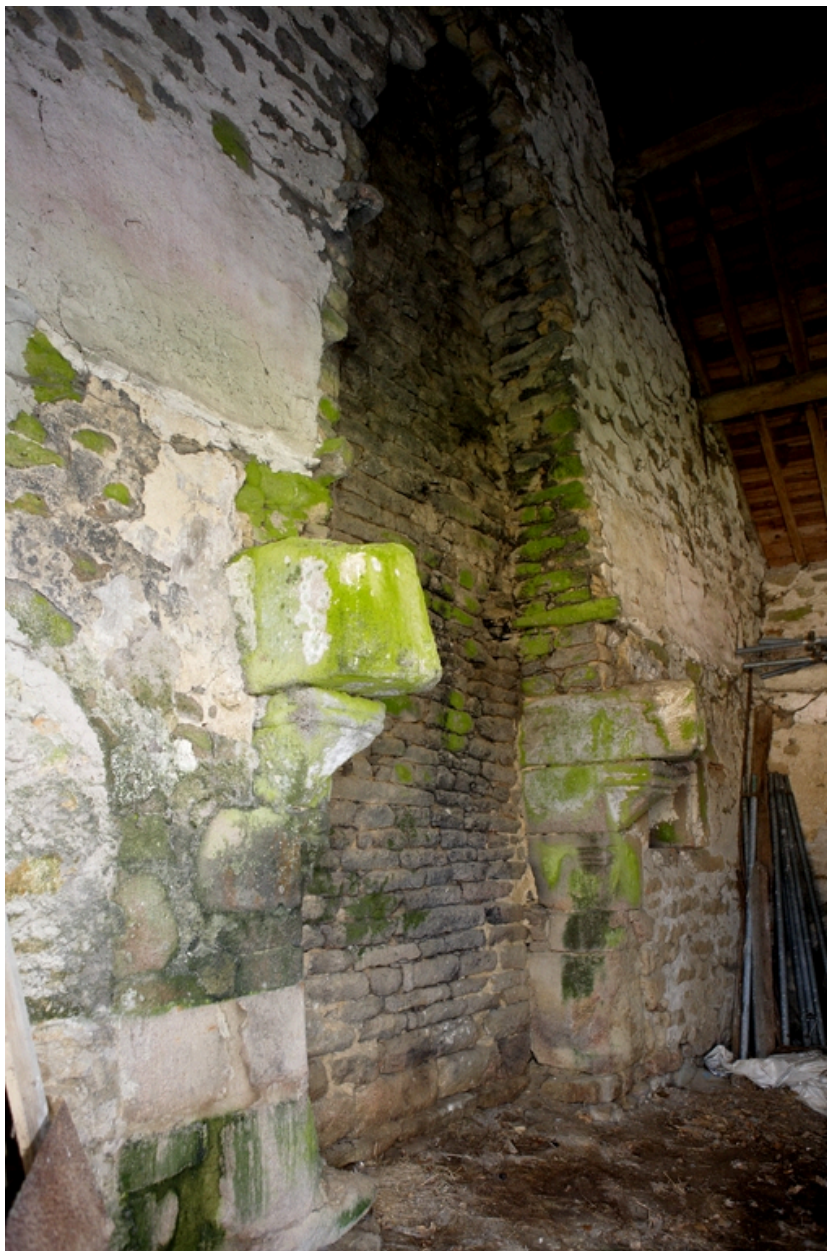
Vue de la cheminée du 1er logis.
