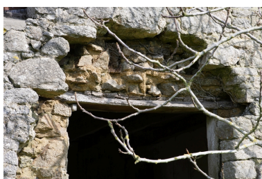
Détail du blocage de moellons entre les deux parements. Phot. Denis Pillet IVR52_20084400542NUCA
