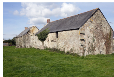
Vue du pignon est et des pierres d'attente dans l'angle sud-est du 1er logis. Phot. Denis Pillet IVR52_20084400540NUCA
