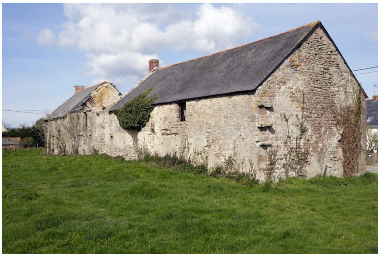
Vue du pignon est et des pierres d'attentes dans l'angle sud-est du 1er logis.
