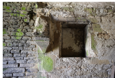
Détail de la niche murale du 1er logis. Phot. Denis Pillet IVR52_20084400549NUCA
