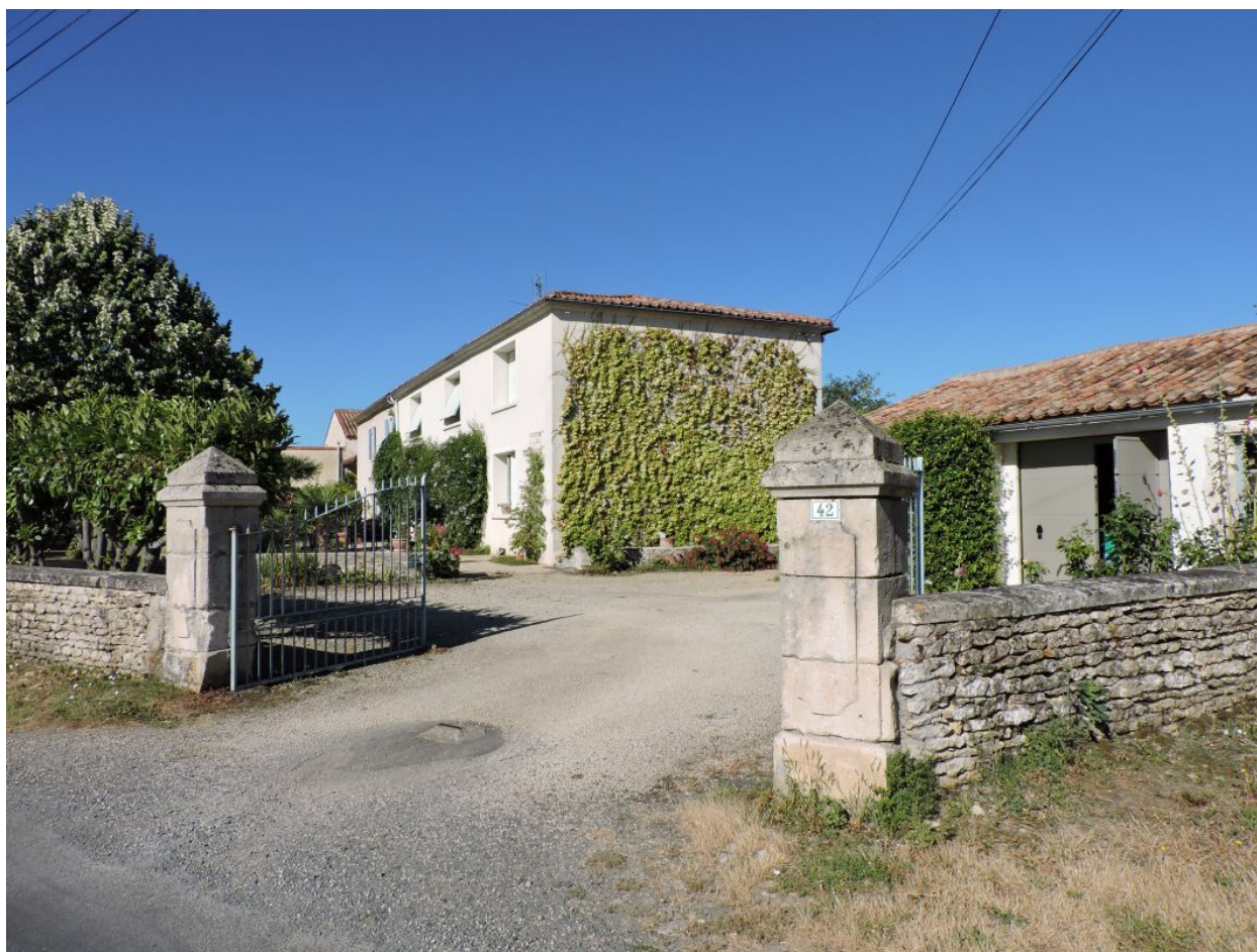
Partie nord (construite en 1870) vue depuis le nord-est : portail, ancien fournil-buanderie à droite, logis remanié à l'arrière-plan.
