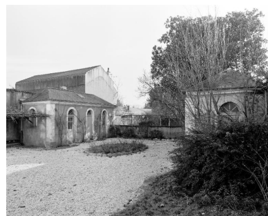
La cour, vue prise vers le sud. Phot. François Lasa IVR52_19984400539X
