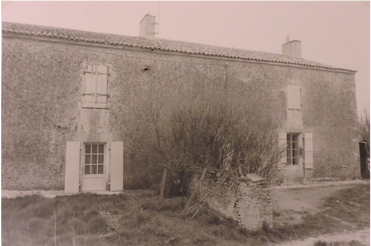
La façade ouest du logis en 1971.
