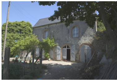
La façade principale vue depuis le sud. Phot. François Lasa IVR52_20045301937NUCA
