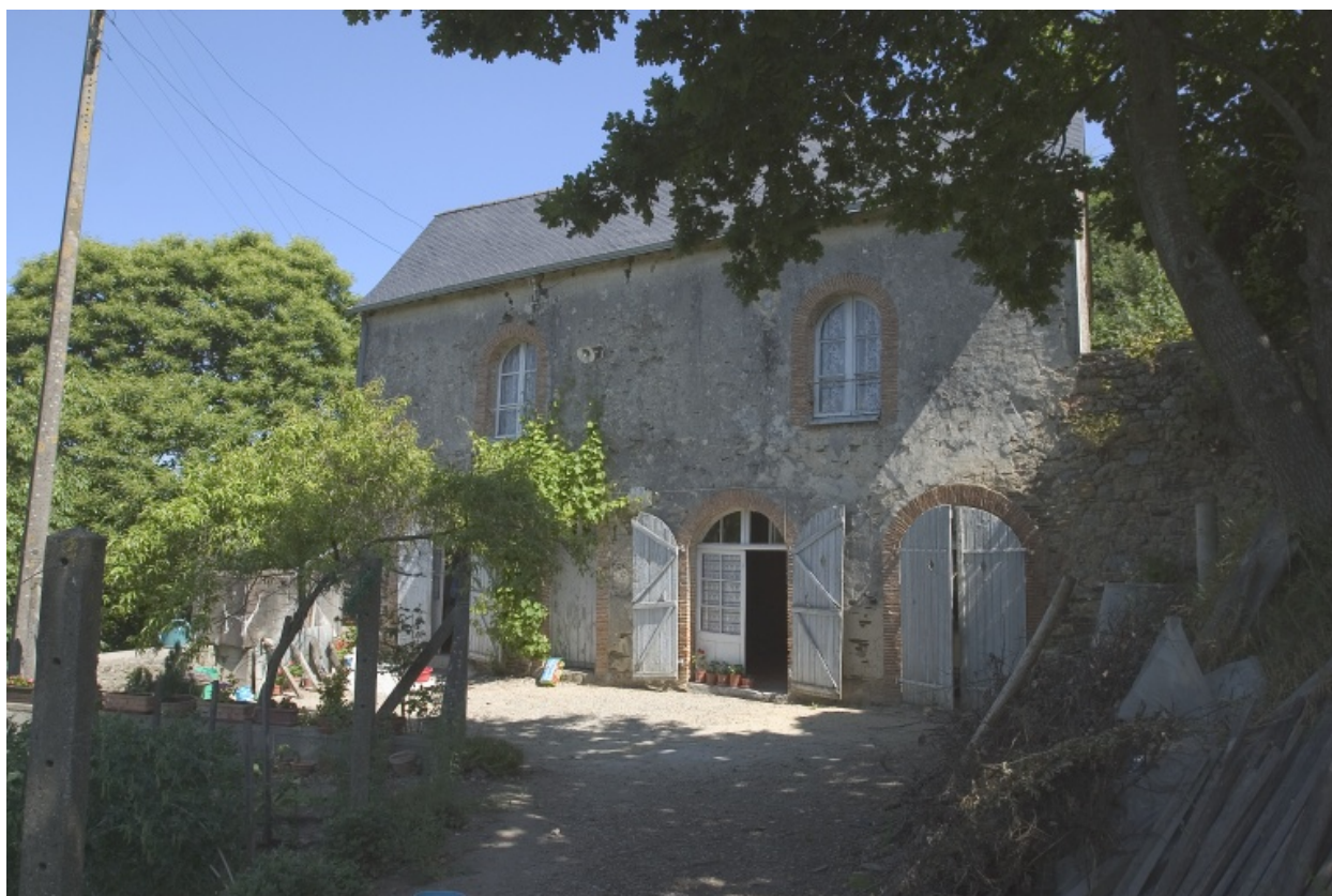
La façade principale vue depuis le sud.
