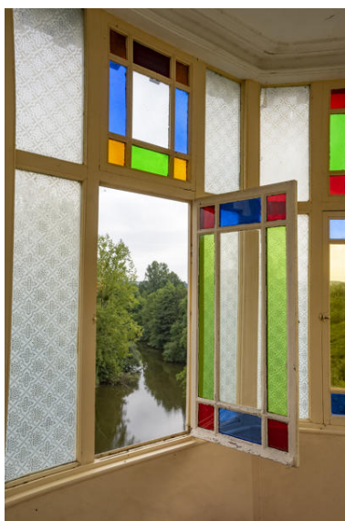
Un détail d'une fenêtre du kiosque. Phot. Pierre-Bernard Fourny IVR52_20215301064NUCA
