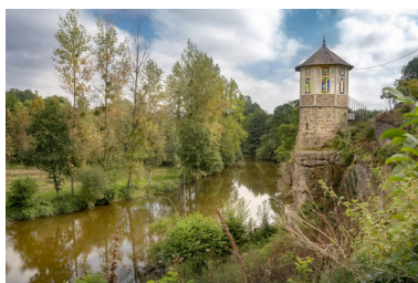
Le kiosque surplombant la Mayenne. Phot. Pierre-Bernard Fourny IVR52_20215301073NUCA
