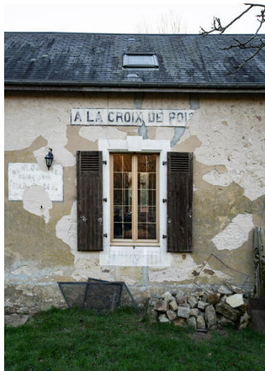
Détail de l'élévation de l'hôtel sur rue.
