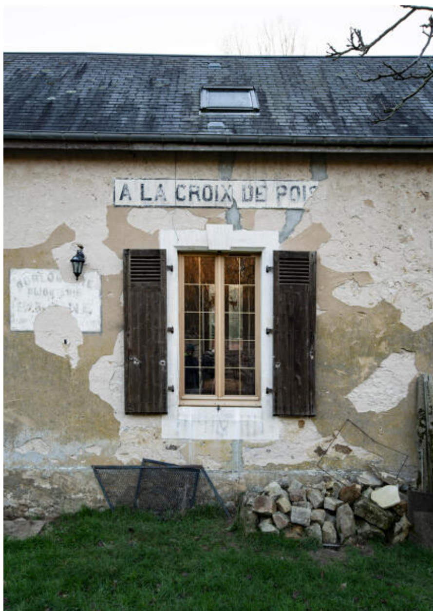
Détail de l'élévation de l'hôtel sur rue.
