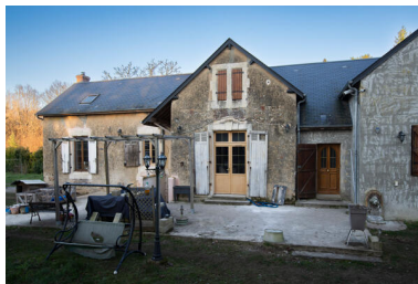
Elevation de l'hôtel sur cour. Phot. Thierry Seldubuisson IVR52_20247200099NUCA
