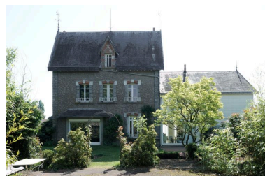
Maison de Georges Mary : vue depuis l'ouest. Phot. Bruno Rousseau, Phot. Youenn Communeau IVR52_20114901432NUCA
