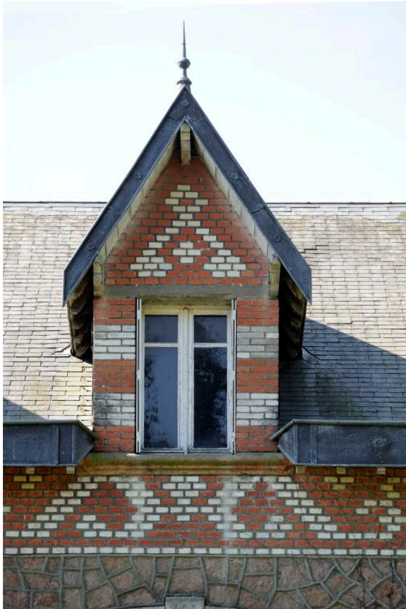
Maison de Georges Mary : détail d'une lucarne.
