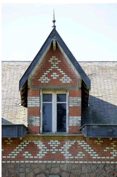
Maison de Georges Mary : détail d'une lucarne. Phot. Bruno Rousseau, Phot. Youenn Communeau IVR52_20114901428NUCA
