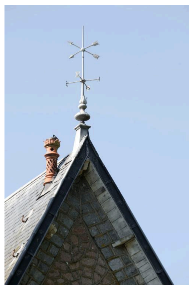
Maison de Georges Mary : détail de la toiture. Phot. Bruno Rousseau, Phot. Youenn Communeau IVR52_20114901429NUCA
