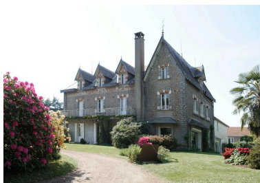
Maison de Georges Mary : vue depuis le nord-ouest. Phot. Bruno Rousseau, Phot. Youenn Communeau IVR52_20114901430NUCA
