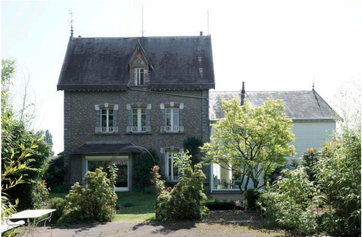
Maison de Georges Mary : vue depuis l'ouest.
