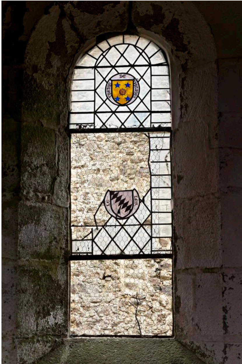
Vue d'ensemble de la verrière 2.
