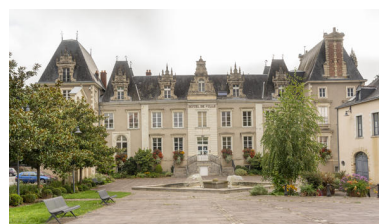
La façade sur cour. Phot. Pierre-Bernard Fourny IVR52_20215301150NUCA
