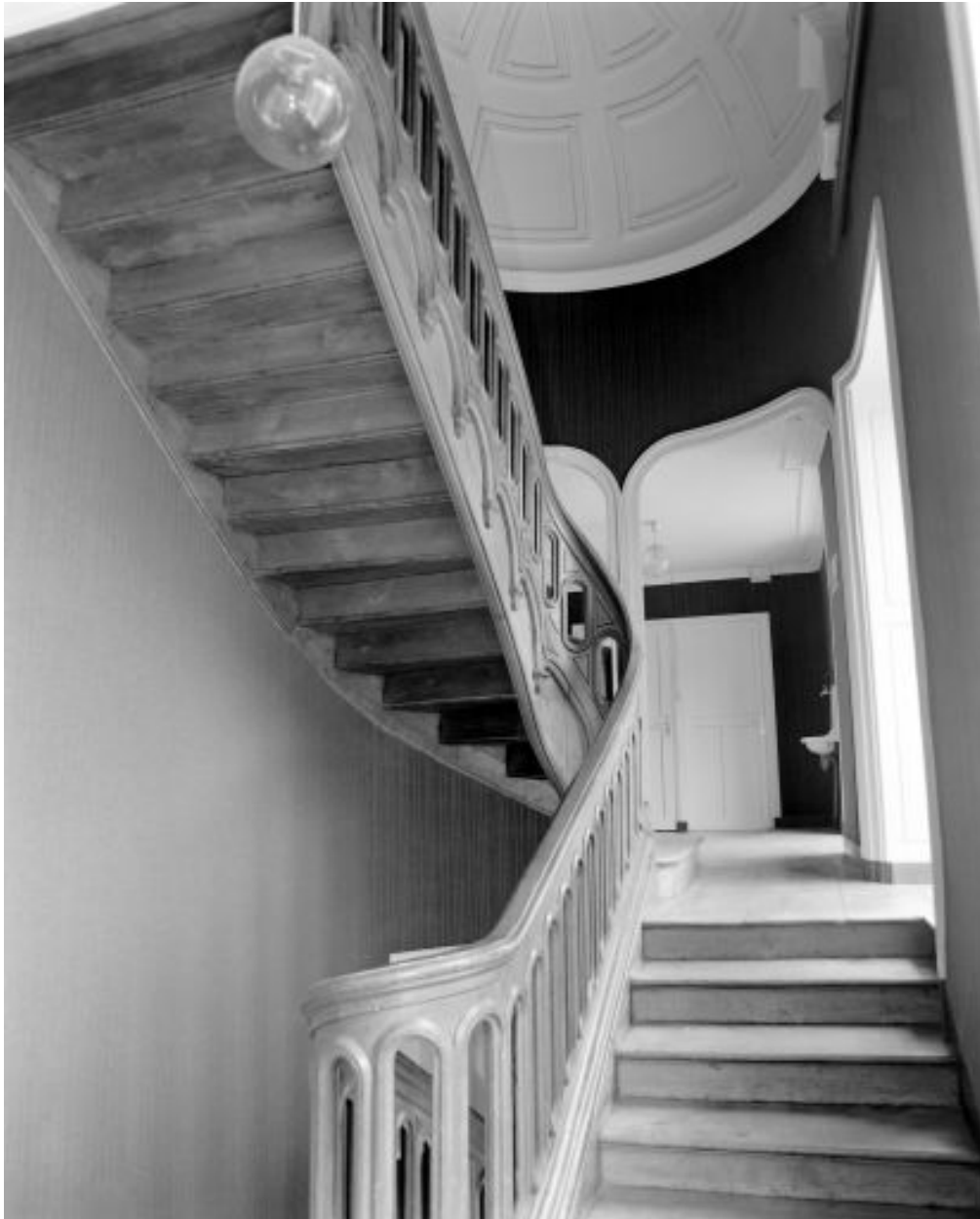
L'escalier vu vers le palier du premier étage.
