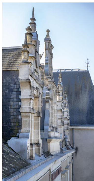
Les lucarnes. Phot. Pierre-Bernard Fourny IVR52_20215301231NUCA
