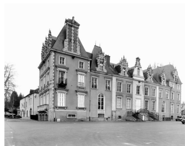
Les élévations postérieure et latérale sud du château vues depuis le sud-est. Phot. François Lasa IVR52_20015300023V
