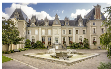
La façade sur cour. Phot. Pierre-Bernard Fourny IVR52_20215301295NUCA
