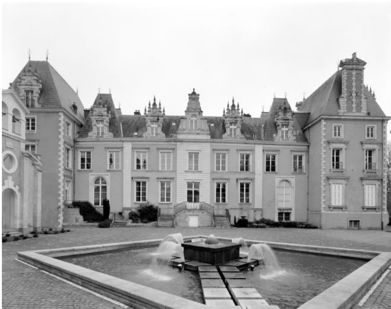
L'élévation antérieure du château vue depuis l'ouest.
