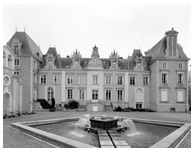
L'élévation antérieure du château vue depuis l'ouest. Phot. François Lasa IVR52_20015300022V
