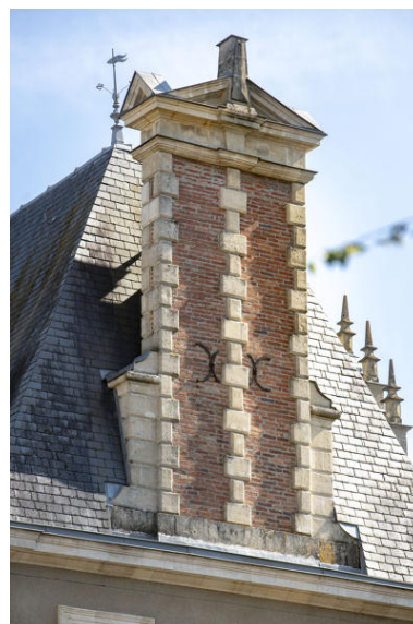
Une souche de cheminée. Phot. Pierre-Bernard Fourny IVR52_20215301265NUCA
