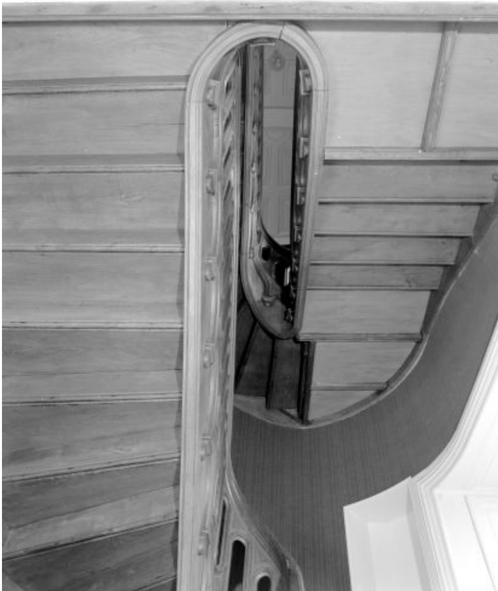
L'escalier : vue en contre-plongée depuis le rez-de-chaussée.
