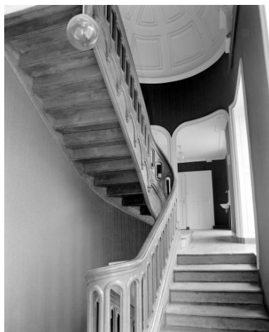
L'escalier vu vers le palier du premier étage. Phot. François Lasa IVR52_20015300082X
