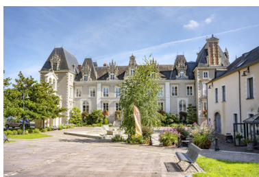
La façade sur cour. Phot. Pierre-Bernard Fourny IVR52_20215301270NUCA
