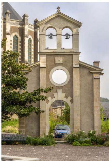
La façade de l'ancienne chapelle. Phot. Pierre-Bernard Fourny IVR52_20215301159NUCA
