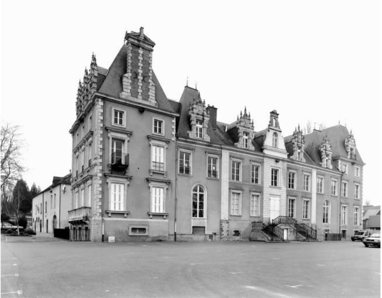
Les élévations postérieure et latérale sud du château vues depuis le sud-est.
