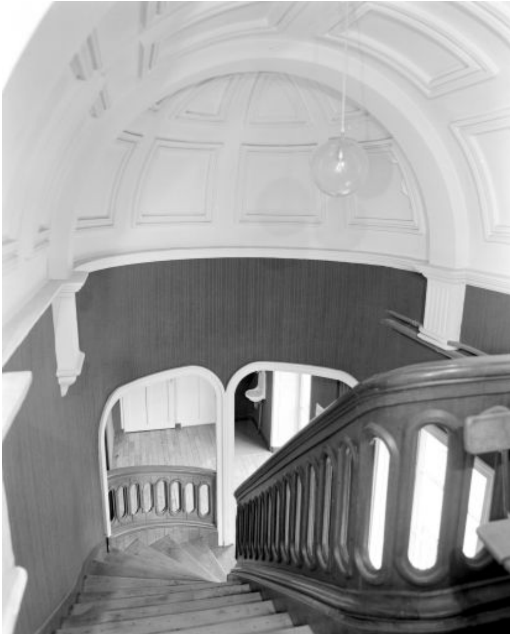
L'escalier vu depuis le palier de l'étage de comble.
