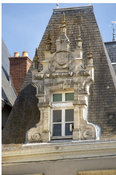
Une lucarne. Phot. Pierre-Bernard Fourny IVR52_20215301264NUCA
