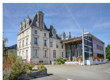
La façade sur la Mayenne. Phot. Pierre-Bernard Fourny IVR52_20215301269NUCA
