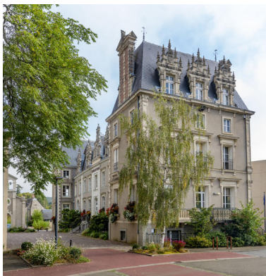
Le pavillon sud. Phot. Pierre-Bernard Fourny IVR52_20215301158NUCA
