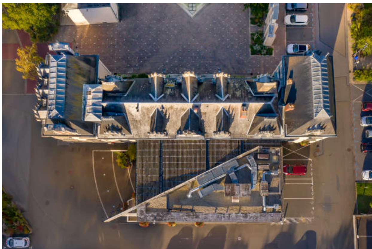
Une vue aérienne des toits du château.
