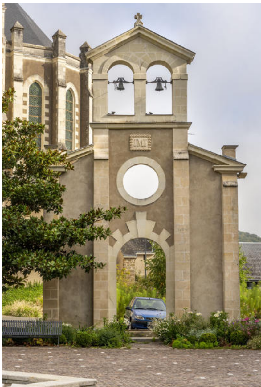
La façade de l'ancienne chapelle.
