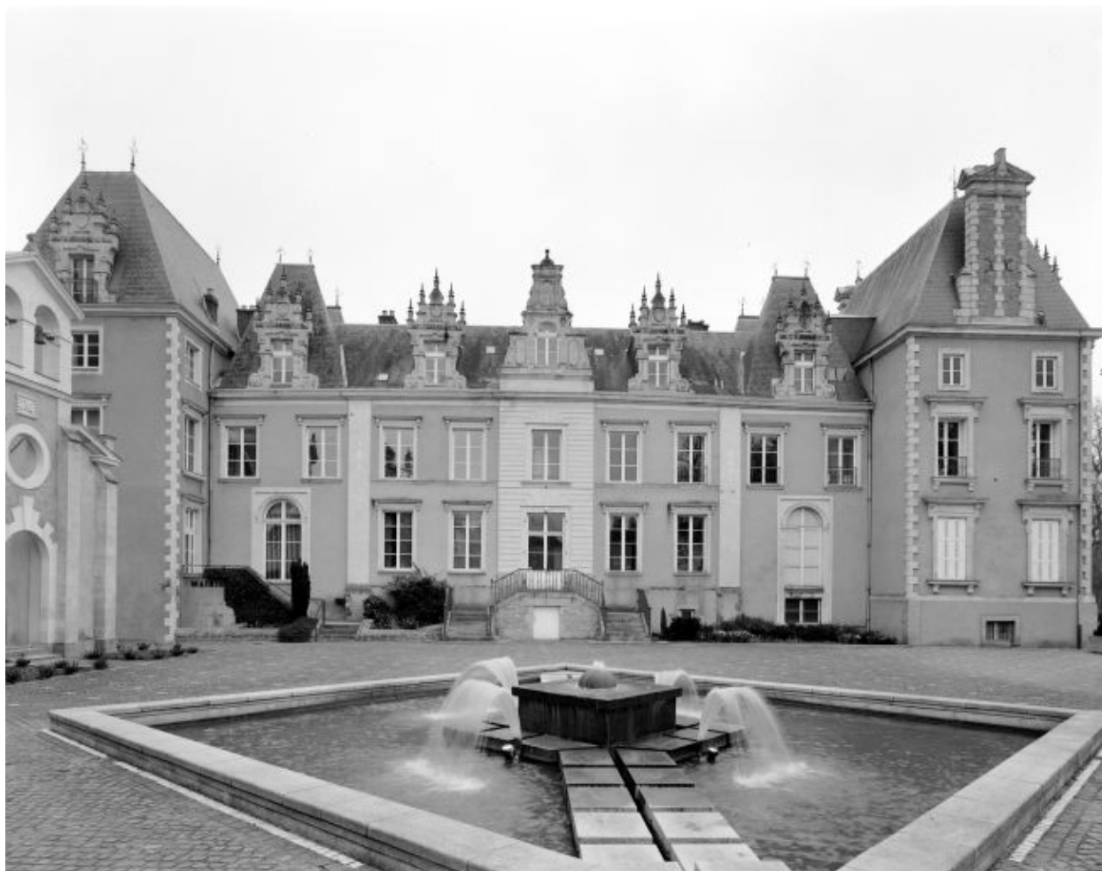
L'élévation antérieure du château vue depuis l'ouest.
