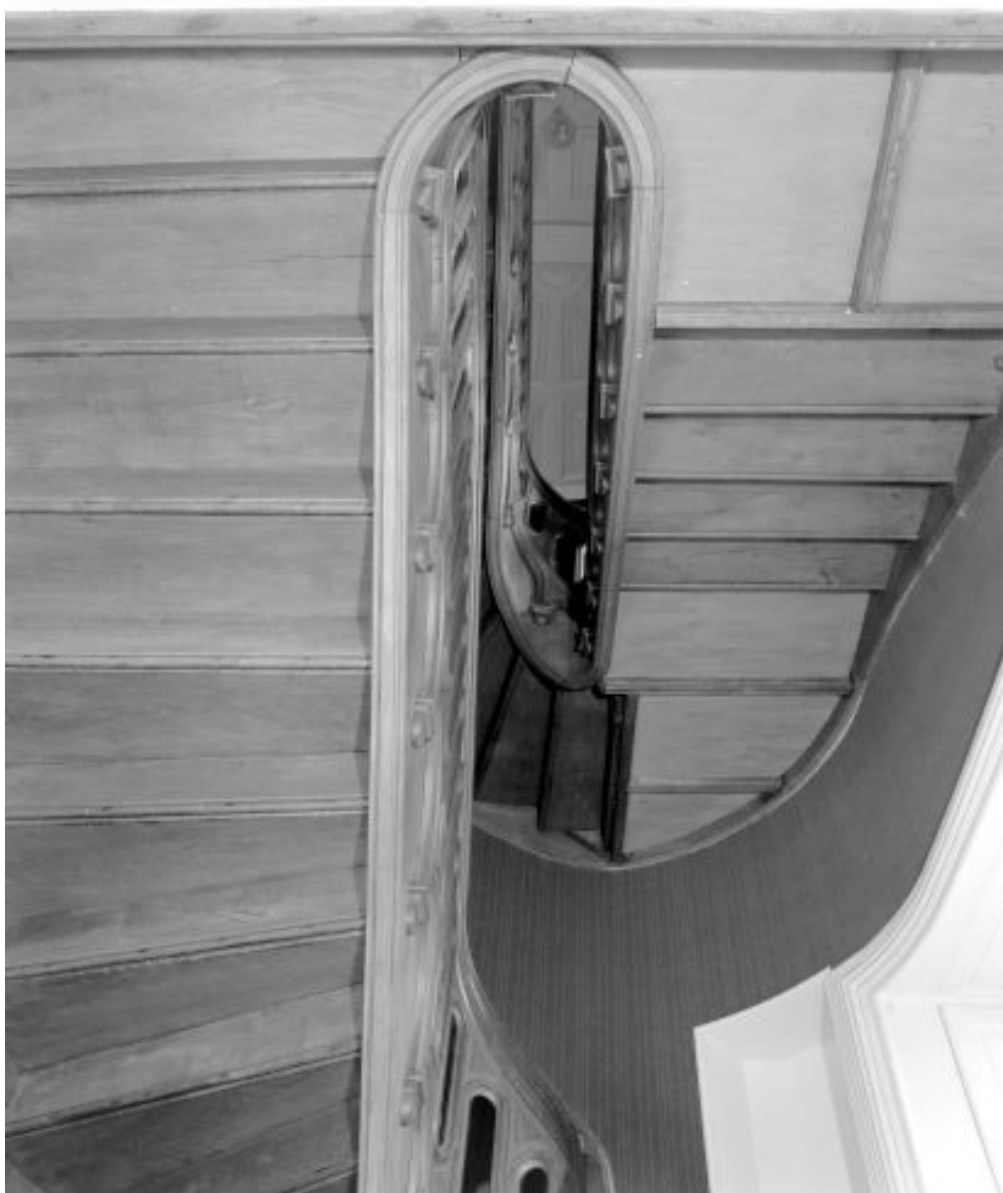
L'escalier : vue en contre-plongée depuis le rez-de-chaussée.
