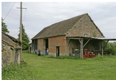
Grange-étable, élévation antérieure.
