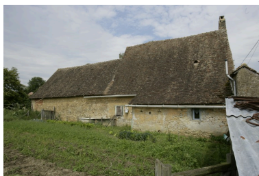
Logis, élévation postérieure. Phot. François Lasa IVR52_20077200653NUCA
