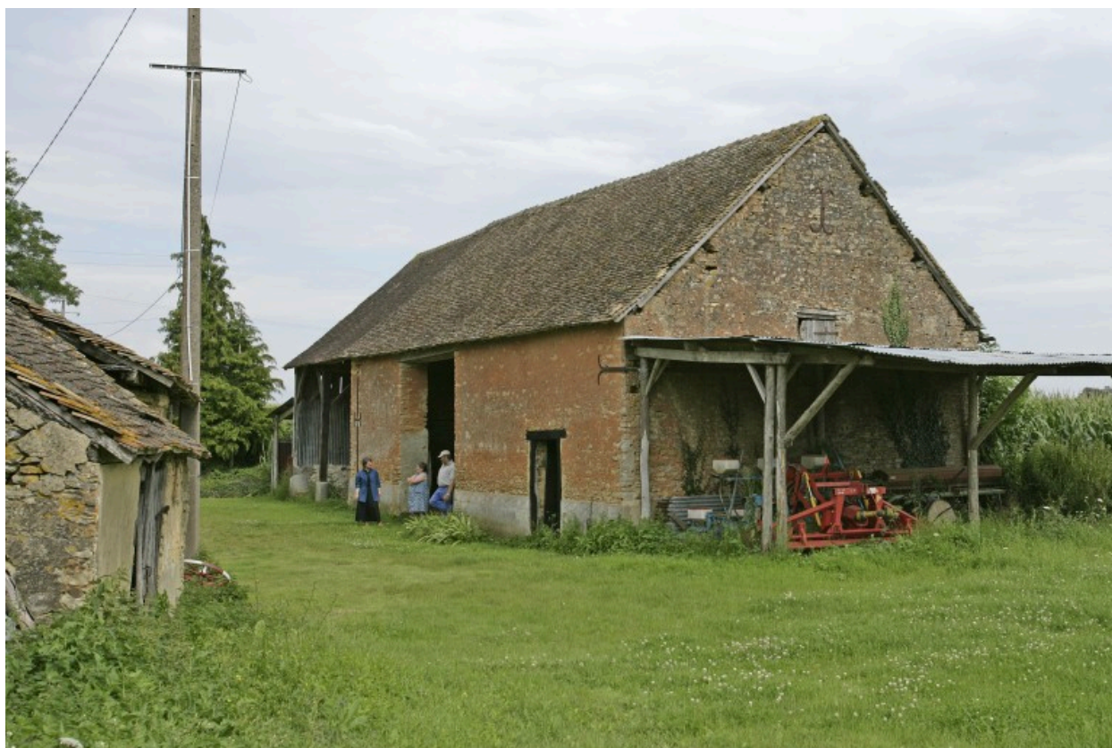
Grange-étable, élévation antérieure.
