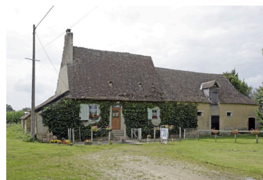
Logis, élévation sur cour. Phot. François Lasa IVR52_20077200651NUCA
