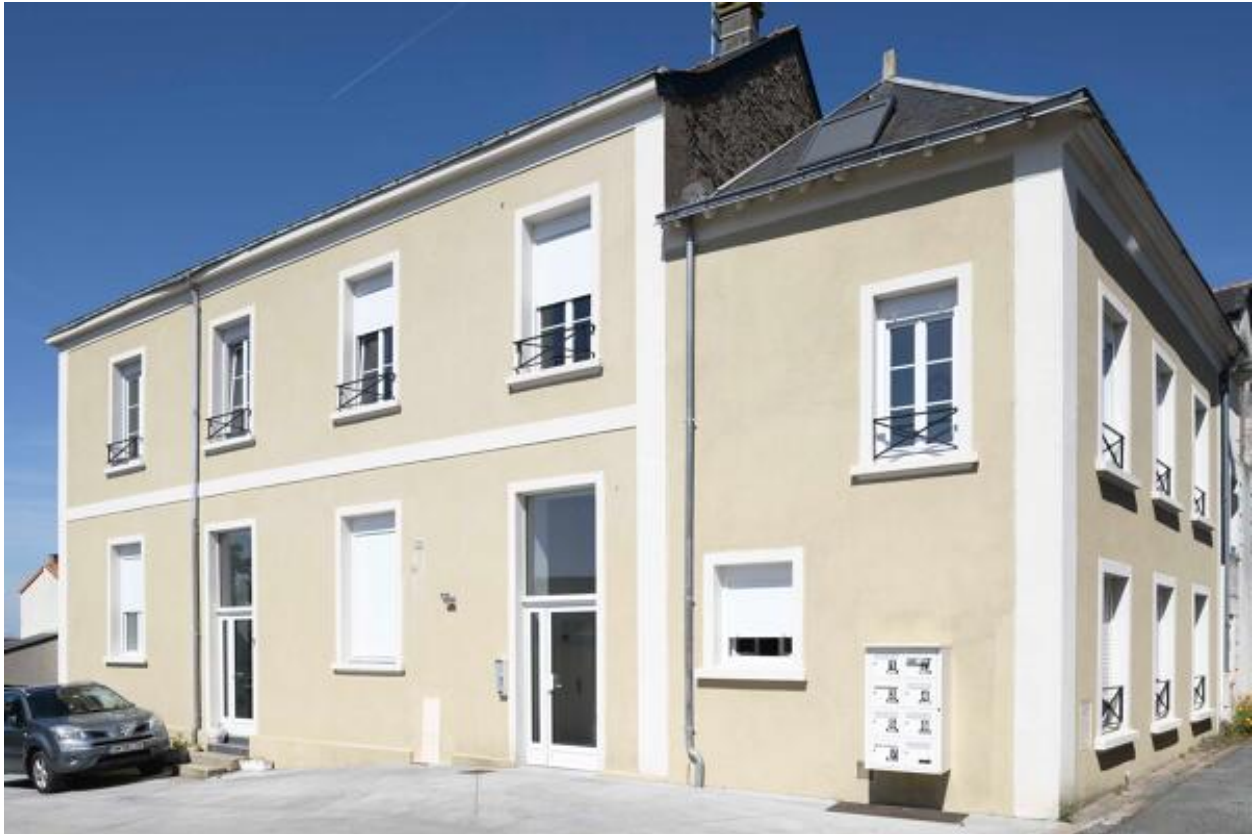
Vue de l'ancienne mairie-école depuis la rue.
