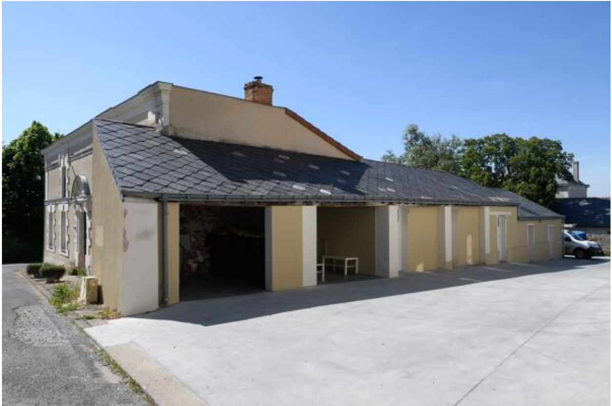
Vue du préau depuis le sud-est.
