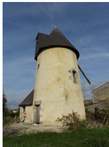
Le moulin vu depuis le sud. Phot. Yannis Suire IVR52_20178500227NUCA
