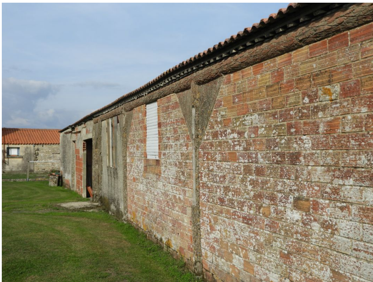
Détail de la dépendance perpendiculaire à la rue : élévation en brique avec structure en faux bois de ciment.
