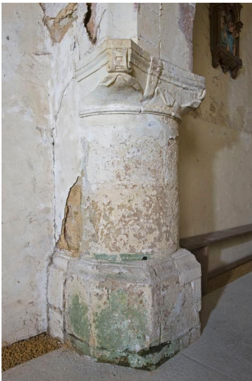
Colonne engagée centrale du bas-côté sud
