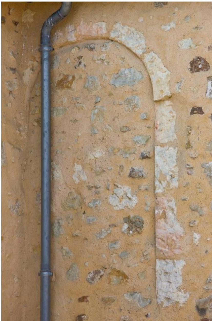
Fenêtre bouchée du mur sud du chœur
