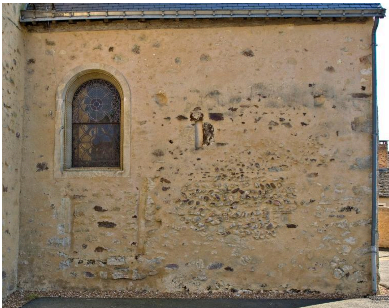
Détail du mur nord de la nef
