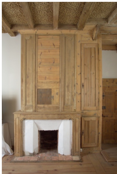
Cheminée du corps sud, premier étage. Phot. Denis Pillet IVR52_20074400651NUCA
