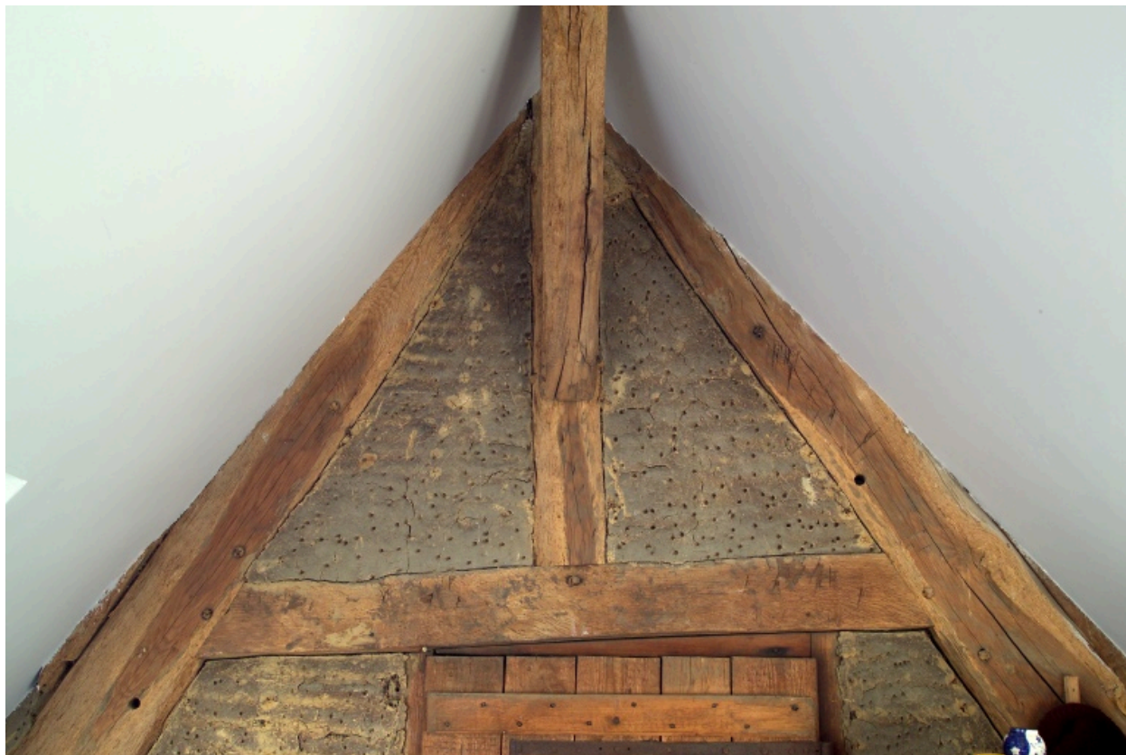
Cloison en terre dans le comble du corps nord.
