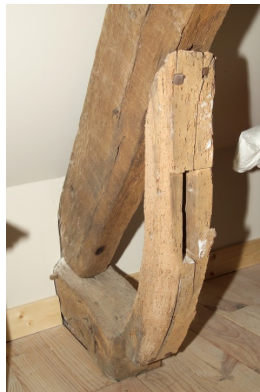
Corps sud, détail de charpente. Phot. Denis Pillet IVR52_20074400653NUCA
