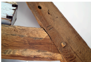
Marque d'assemblage, charpente du corps nord. Phot. Denis Pillet IVR52_20074400656NUCA
