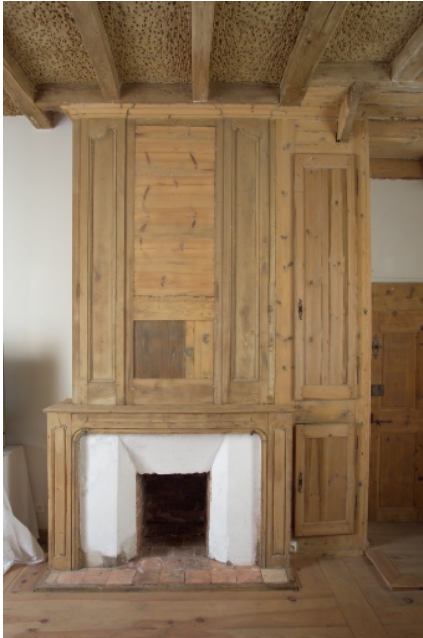
Chéminée du corps sud, premier étage.
