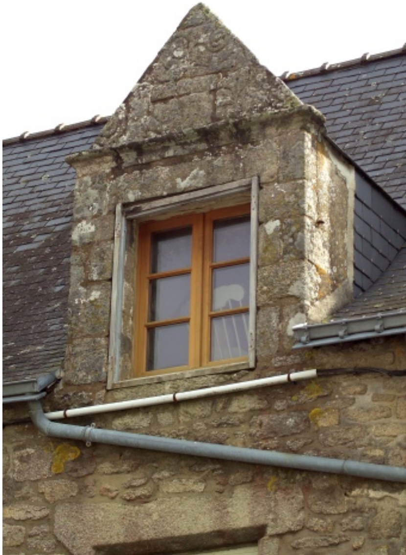
détail de lucarne du corps sud.
