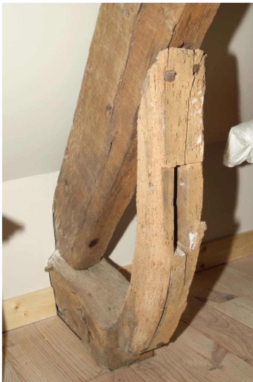
Corps sud, détail de charpente.
