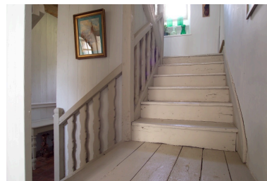
Vue de l'escalier depuis le rez-de-chaussée. Phot. Denis Pillet IVR52_20074400660NUCA
