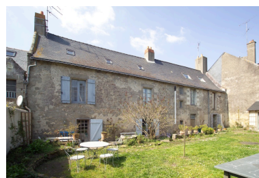
Vue de la façade postérieure vers le Nord-Ouest. Phot. Denis Pillet IVR52_20074400640NUCA
