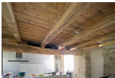
Plafond du rez-de- chaussée du corps sud. Phot. Denis Pillet IVR52_20074400648NUCA
