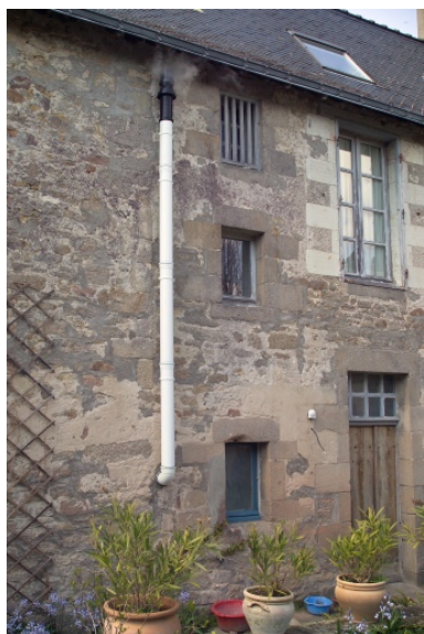
Alignement des trois fenêtres de l'escalier et chaînage d'angle du corps sud. Phot. Denis Pillet IVR52_20074400641NUCA
