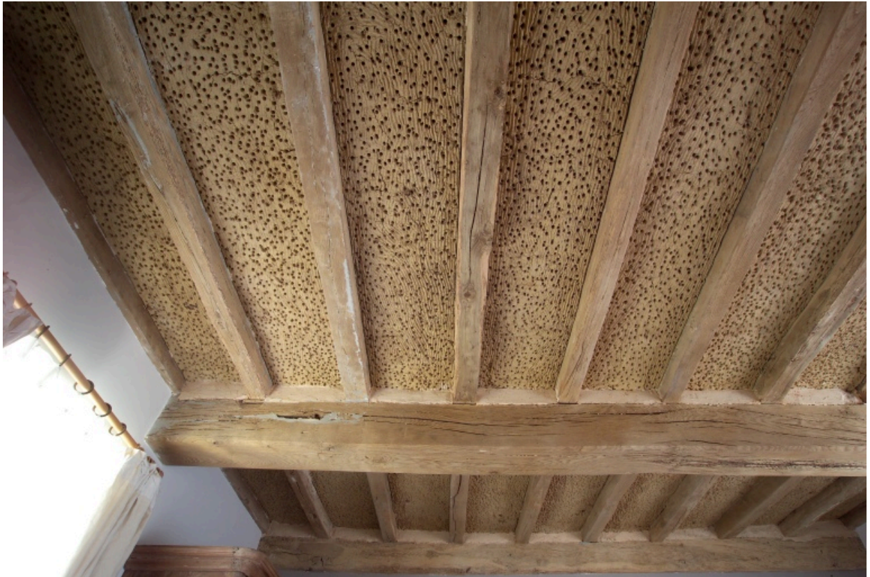
Plafond du corps sud, premier étage.
