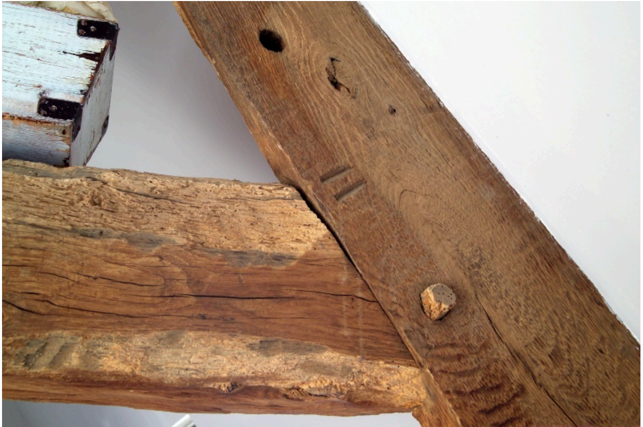
Marque d'assemblage, charpente du corps nord.
