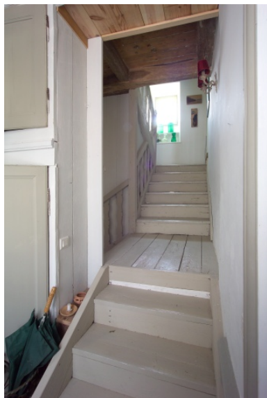
Vue de l'escalier depuis le rez-de-chaussée. Phot. Denis Pillet IVR52_20074400644NUCA
