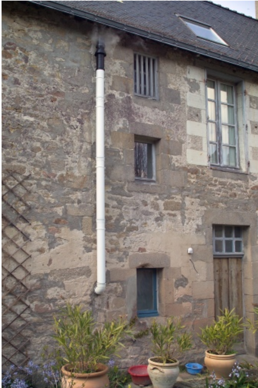
Alignement des trois fenêtres de l'escalier et chaînage d'angle du corps sud.
