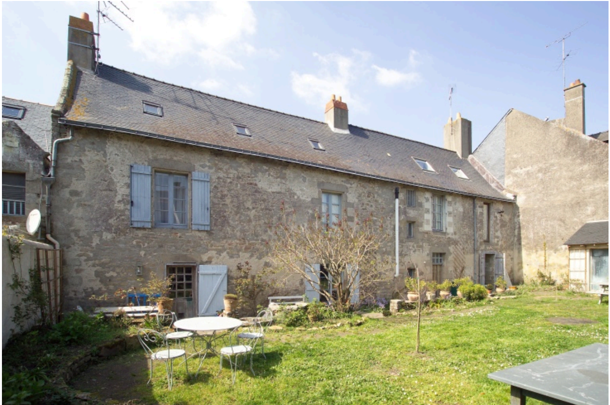
Vue de la façade postérieure vers le Nord-Ouest.
