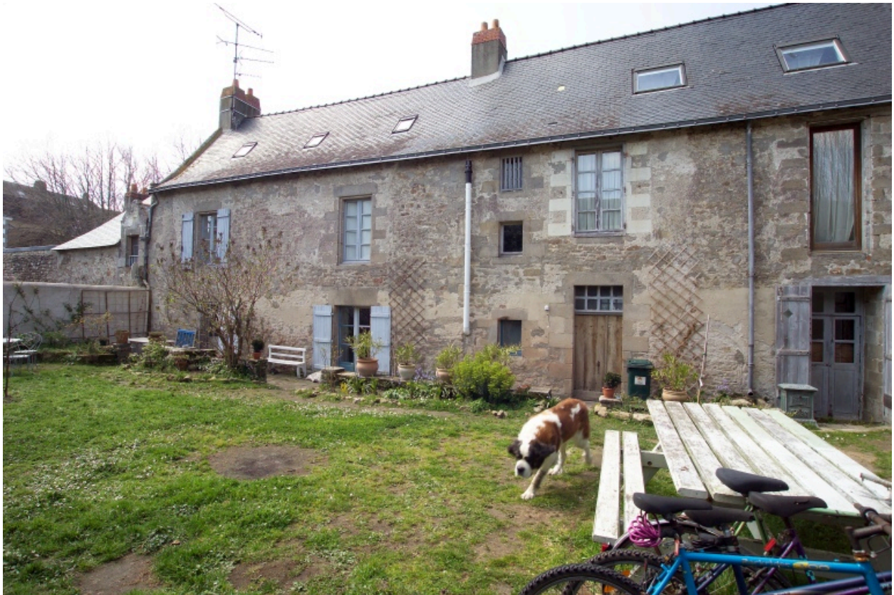
Vue de la façade postérieure vers le Sud-Ouest.
