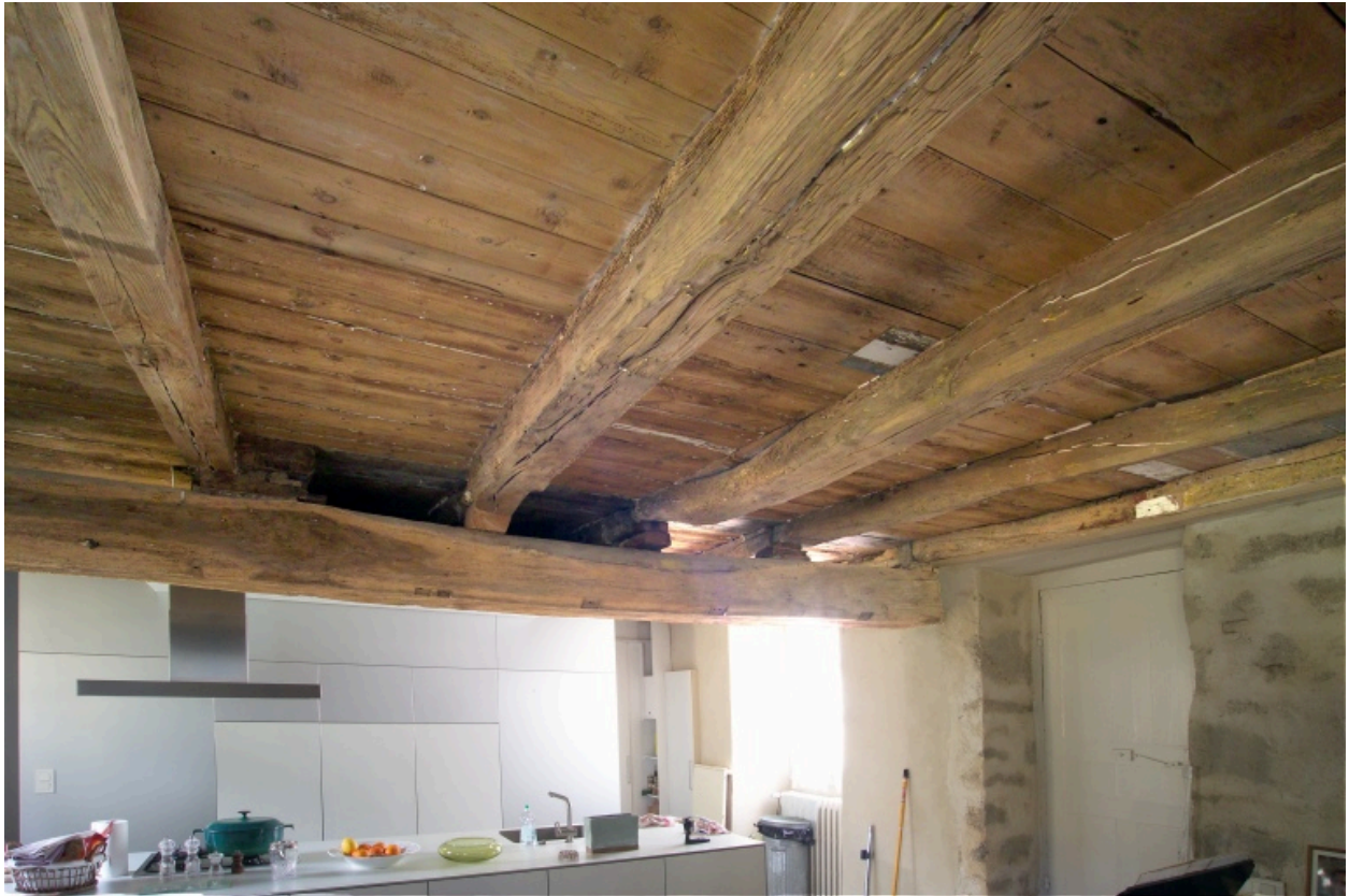
Plafond du rez-de-chaussée du corps sud.
