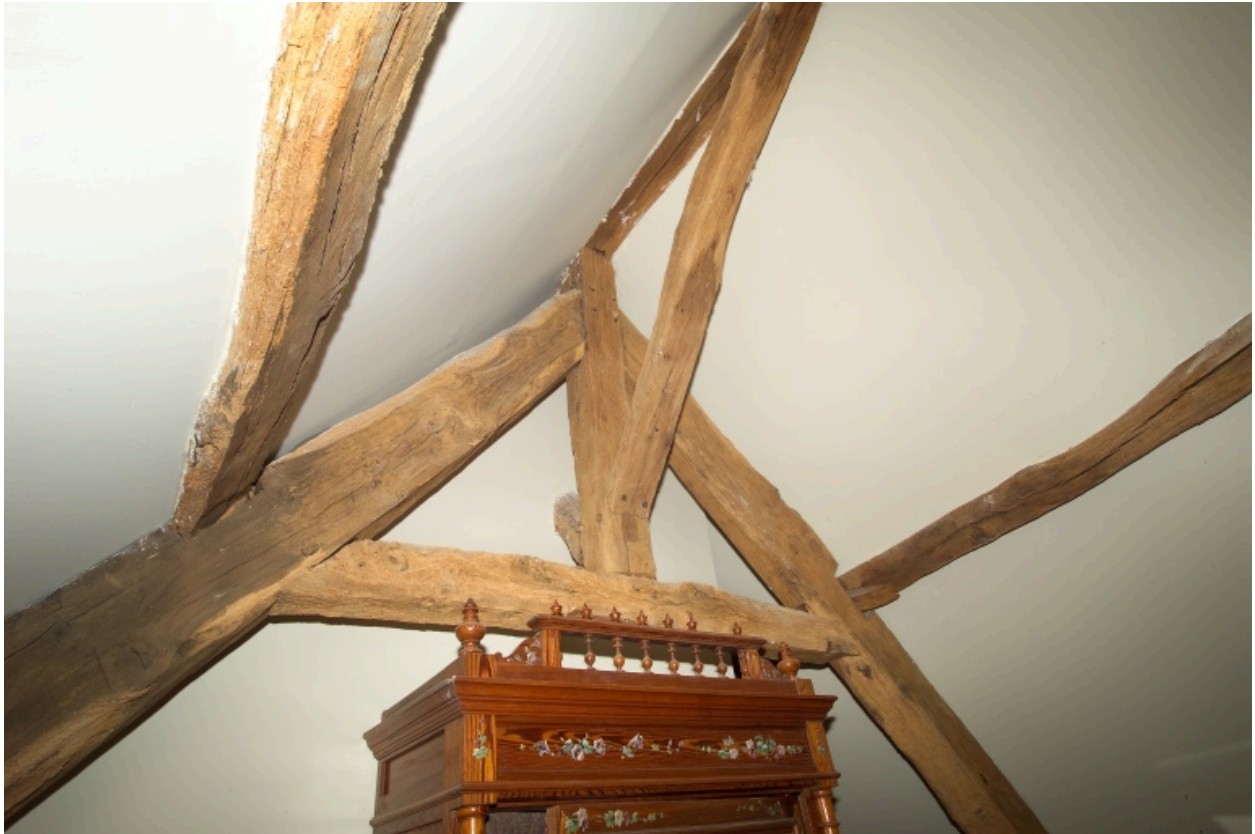
Corps sud, charpente.
