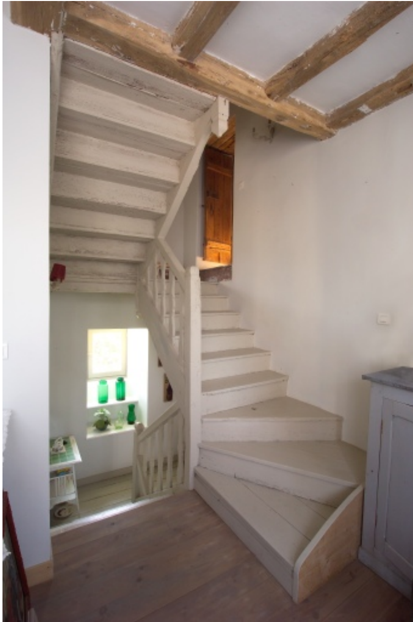
Vue de l'escalier depuis le premier étage.
