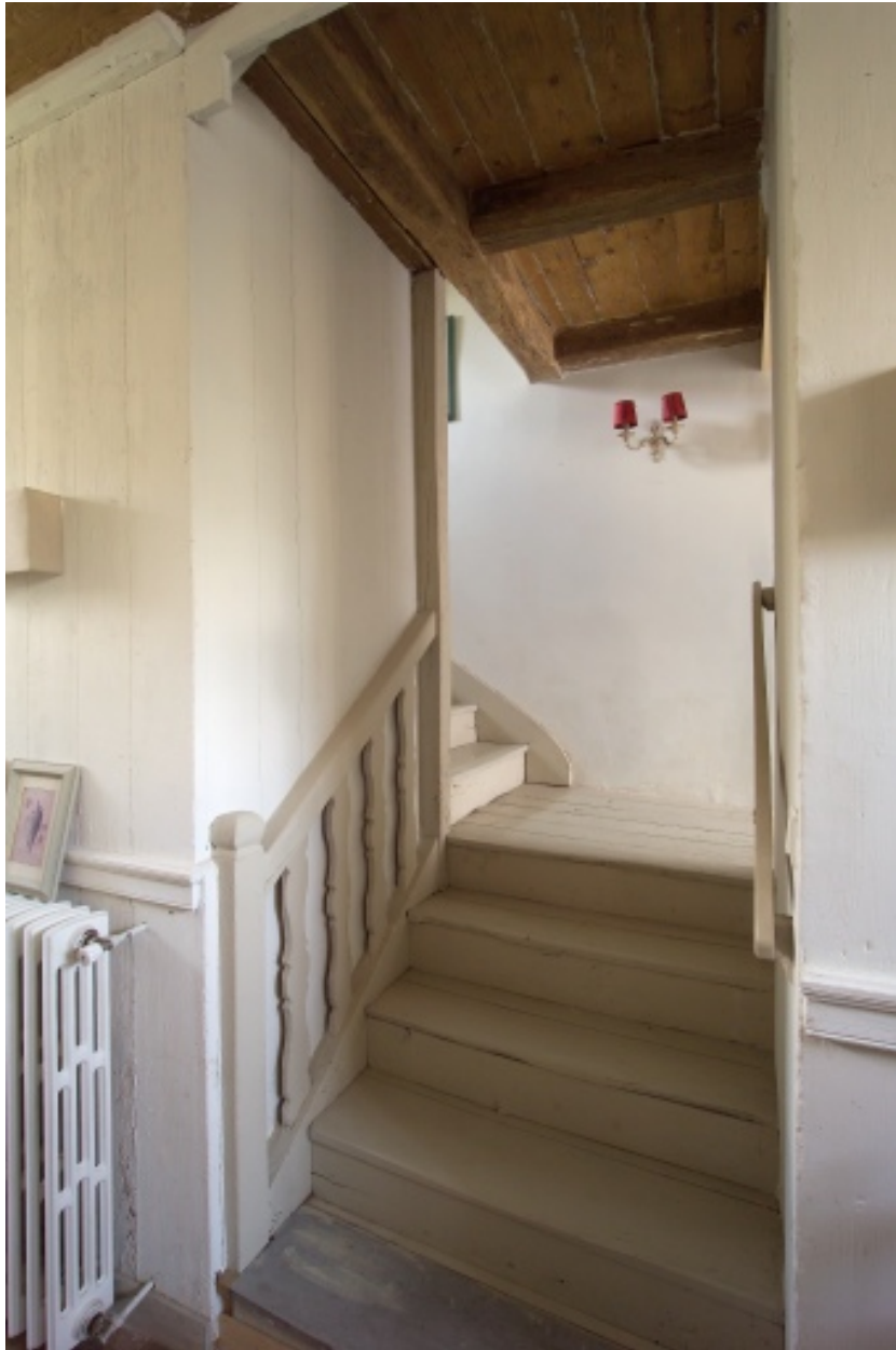
Vue de l'escalier depuis le rez-de-chaussée.
