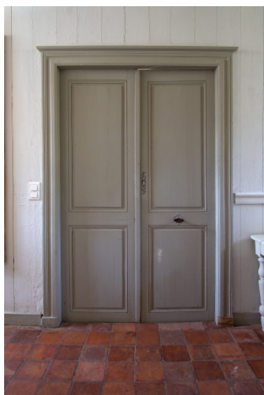
Couloir et accès à la salle en rez-de-chaussée du corps nord. Phot. Denis Pillet IVR52_20074400659NUCA
