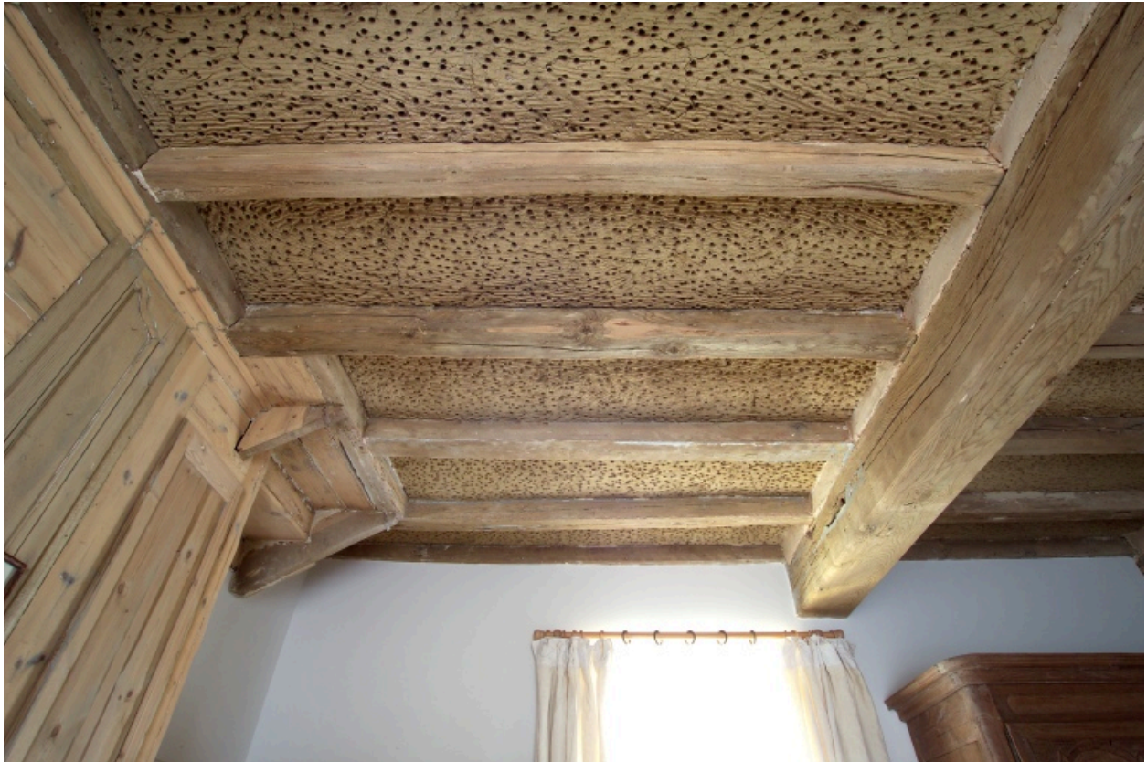
Plafond du corps sud, premier étage, détail trumeau de cheminée.
