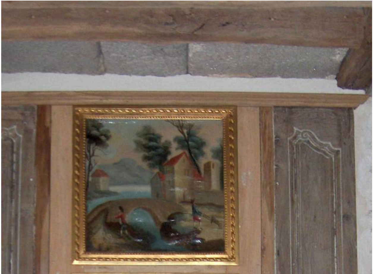
Détail du trumeau de la cheminée du corps sud, rez-de-chaussée.
