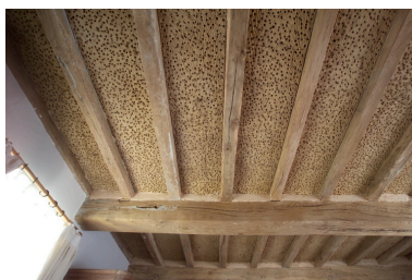
Plafond du corps sud, premier étage. Phot. Denis Pillet IVR52_20074400650NUCA
