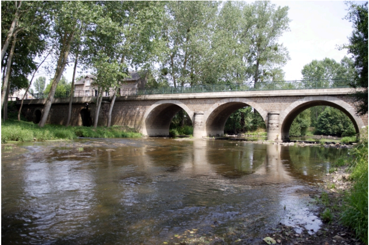
Vue d'aval, depuis la rive gauche.
