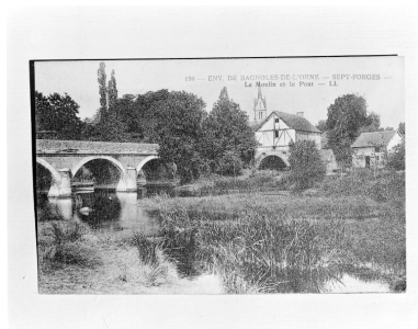
Vue d'amont, depuis la rive gauche, du pont et du moulin.
