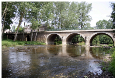
Vue d'aval, depuis la rive gauche.
