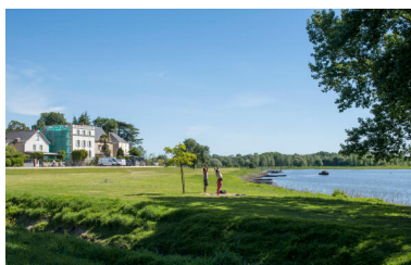
Vue d'ensemble du quai de la Noé et de la villa Quies depuis le sud-ouest. Phot. Armelle Maugin IVR52_20204900165NUCA
