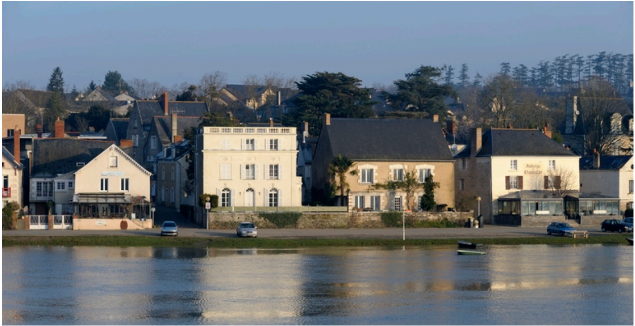
Vue d'ensemble du quai de la Noé depuis la rive gauche de la Maine.
