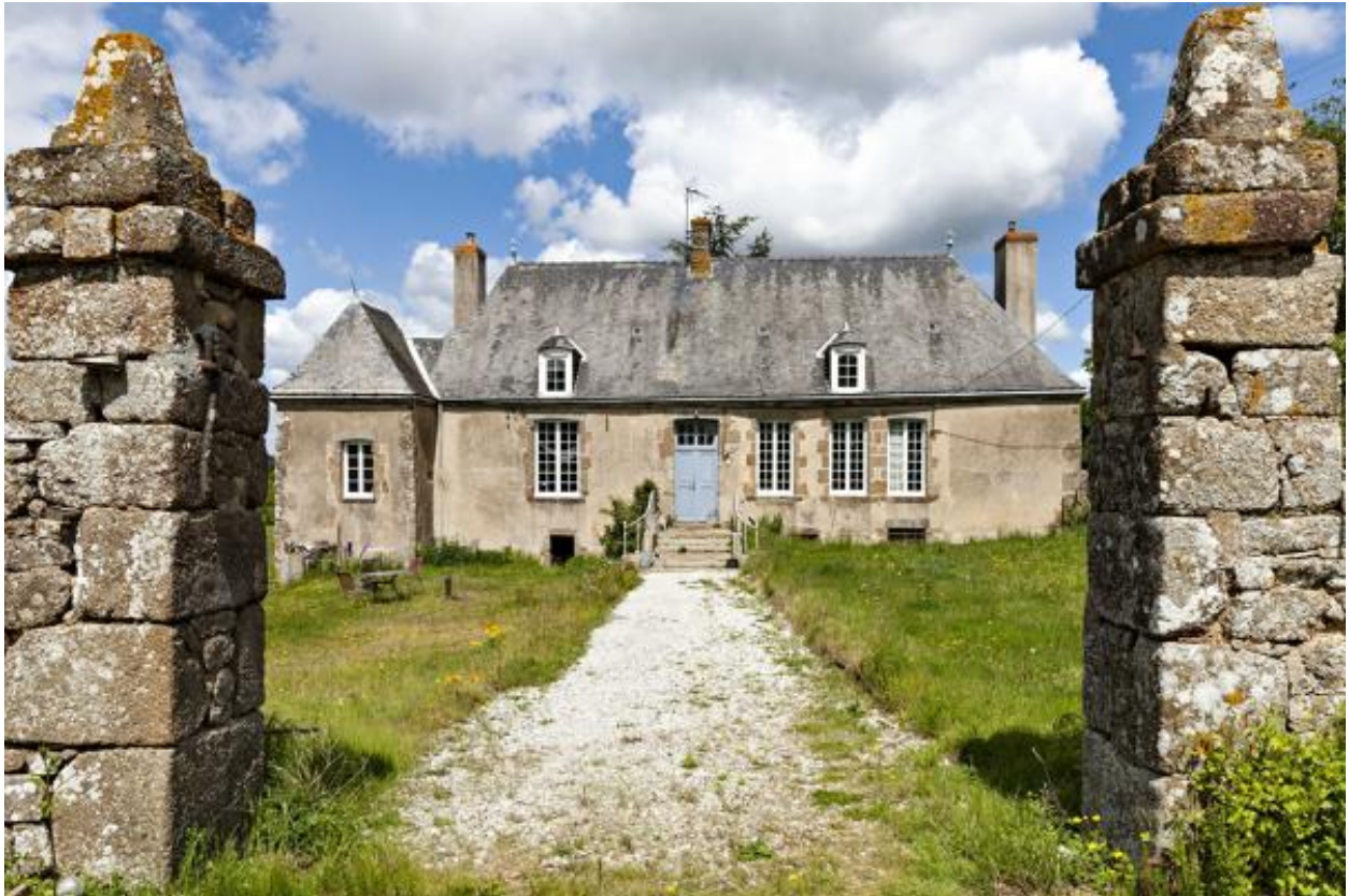
Façade sud à travers le portail du mur de clôture.
