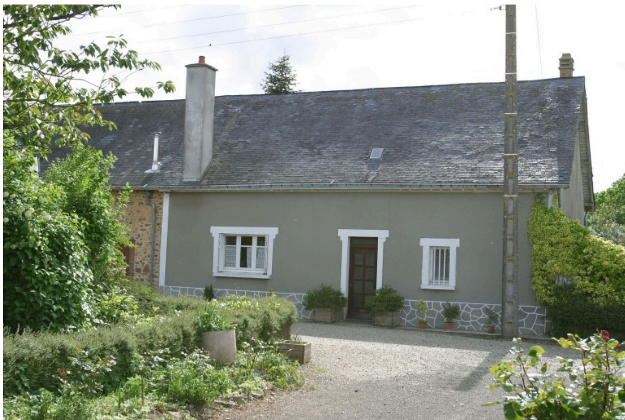
Le logis et une partie de l'étable vus depuis le chemin d'accès à l'est.
