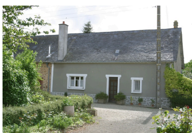
Le logis et une partie de l'étable vus depuis le chemin d'accès à l'est. Phot. François Lasa IVR52_20035301489NUCA
