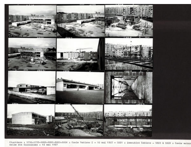
Vue du chantier de l'école maternelle des Glonnières, Maryse Bastié. IVR52_20217200012NUCA
