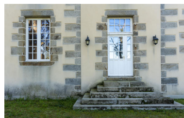
La façade postérieure du château, détail du perron. Phot. Pierre-Bernard Fourny IVR52_20215301691NUCA
