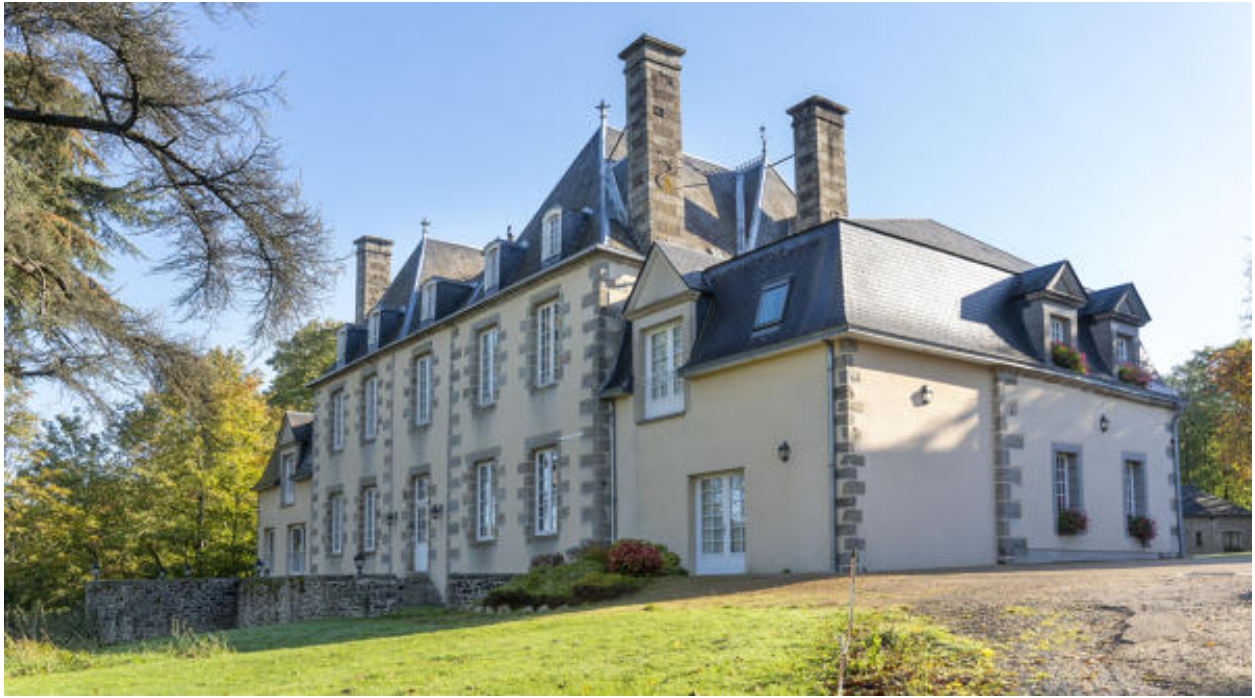
La façade postérieure du château.
