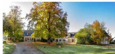
Les bâtiments de l'hôtel-restaurant. Phot. Pierre-Bernard Fourny IVR52_20215301686NUCA
