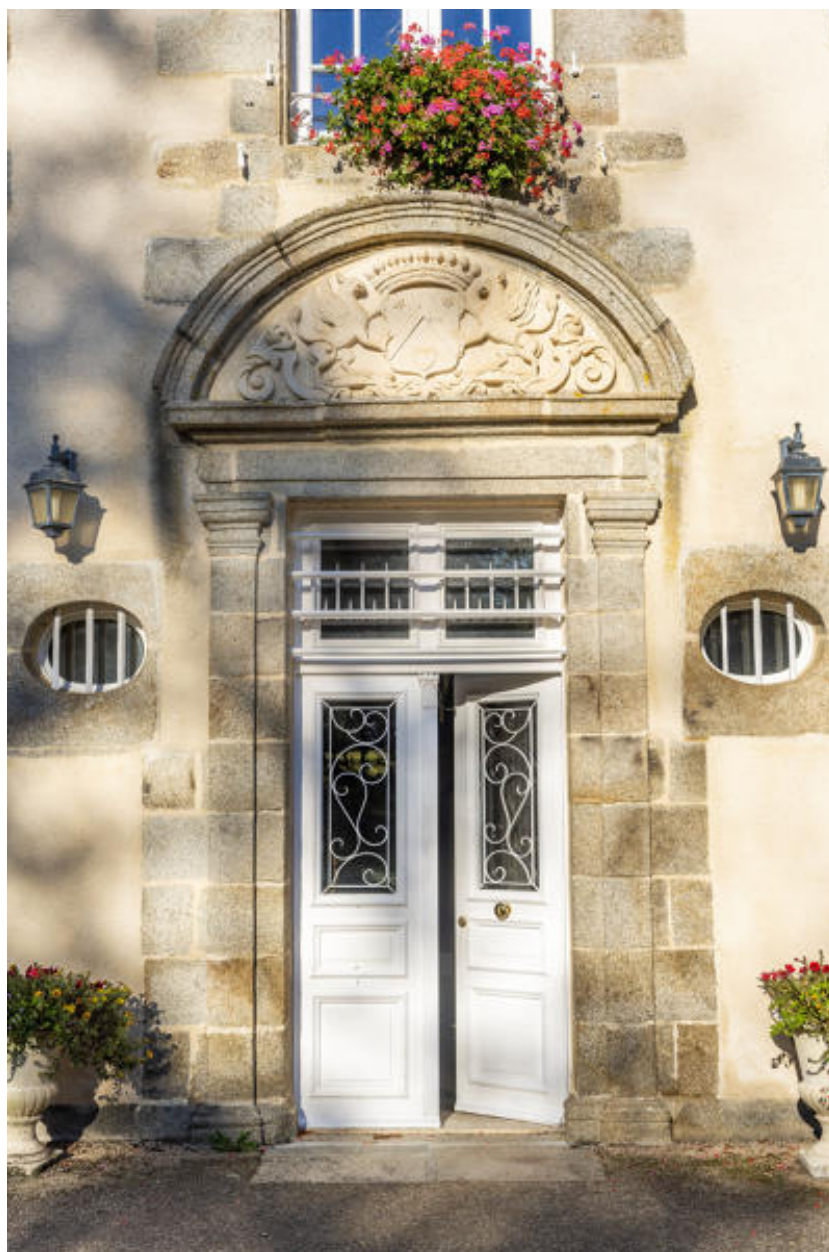
La porte principale du château.
