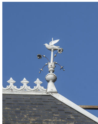
Un épi de faîtage. Phot. Pierre-Bernard Fourny IVR52_20215301685NUCA
