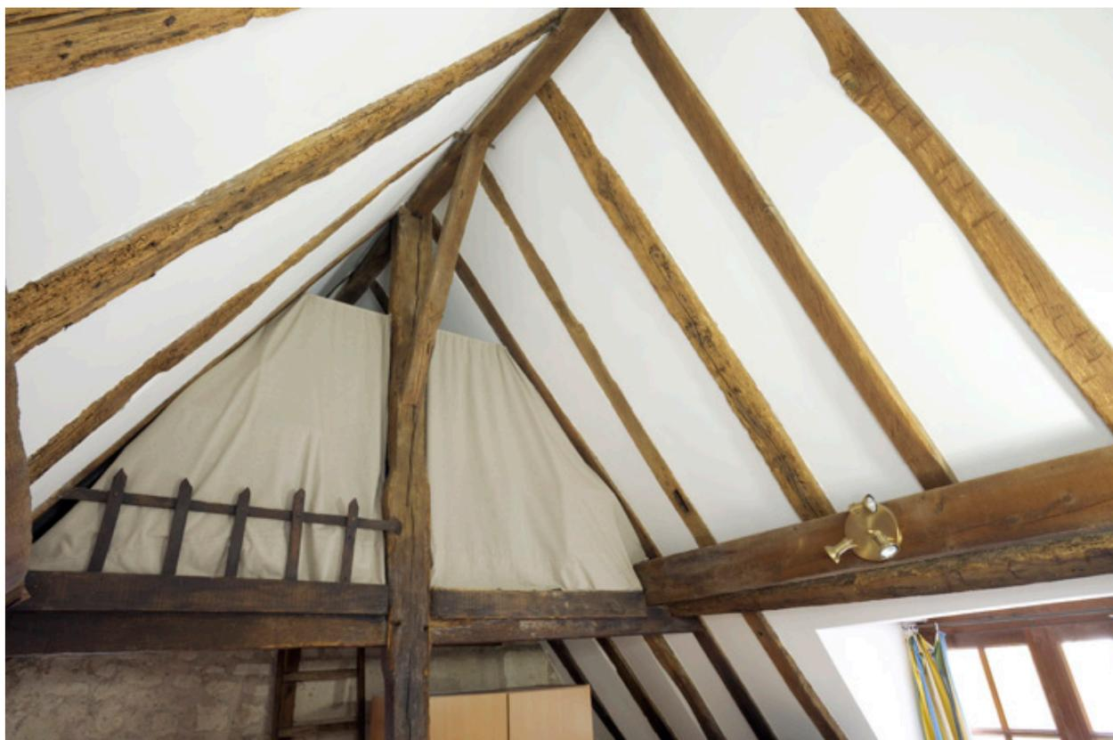
Comble : vue de la charpente, détail du poinçon nord et du contreventement.
