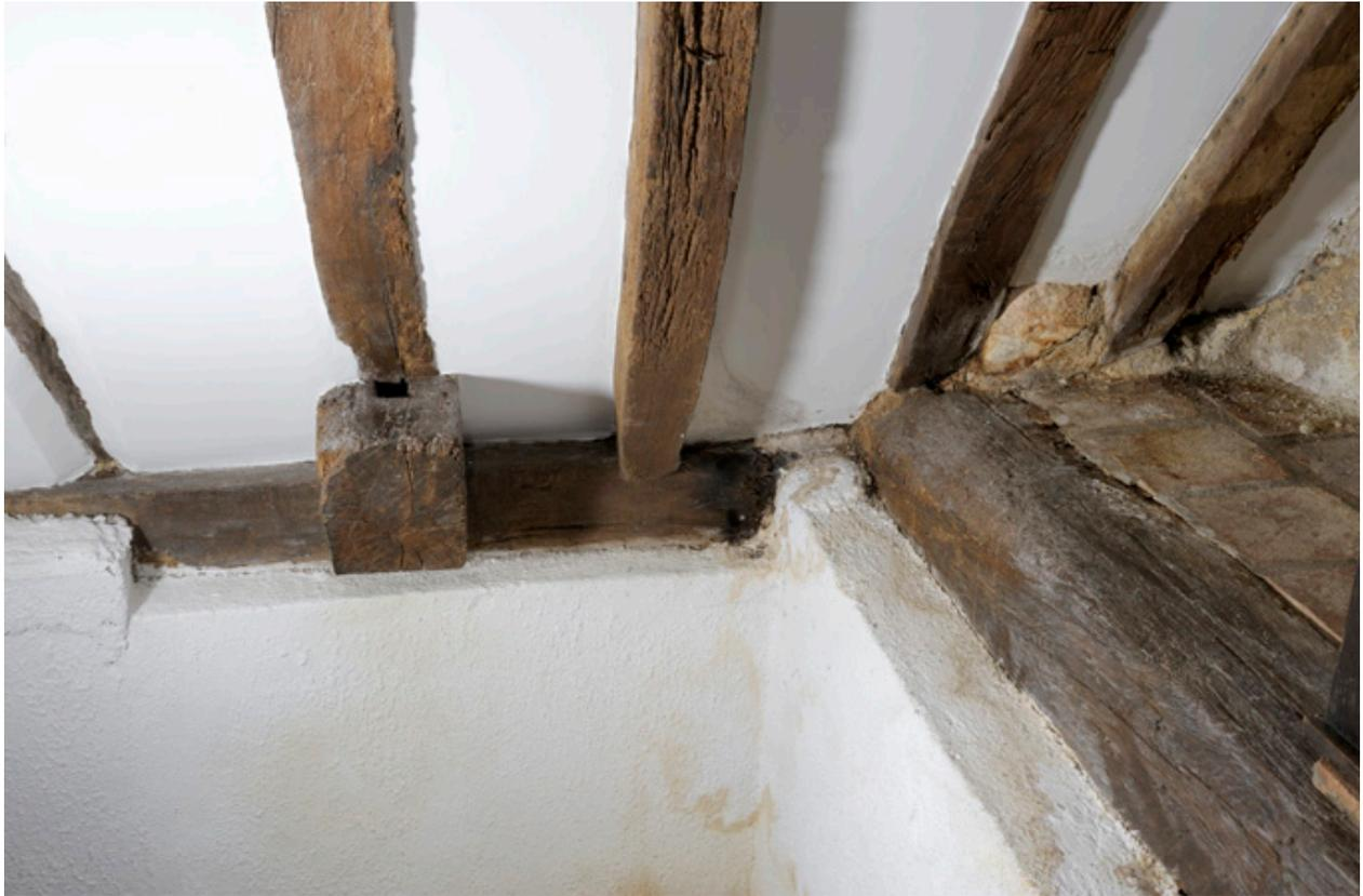
Comble : vue de la charpente, détail de la sablière portant chevrons et poutres.
