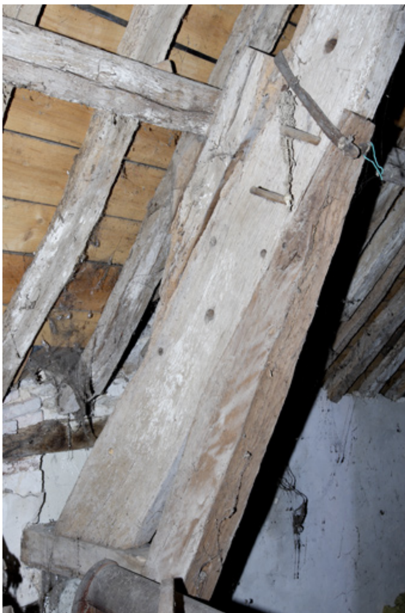
Logis. Charpente. Détail d'un arbalétrier.
