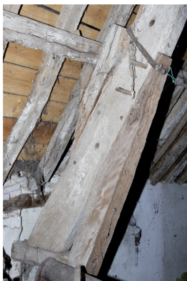
Logis. Charpente. Détail d'un arbalétrier. Phot. Denis Pillet IVR52_20084402200NUCA
