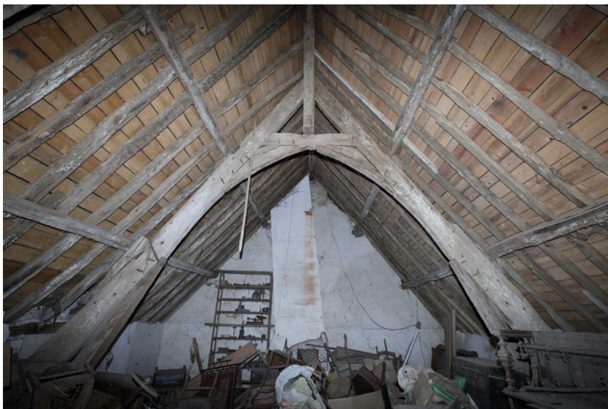
Logis. Charpente. Vue d'une ferme.
