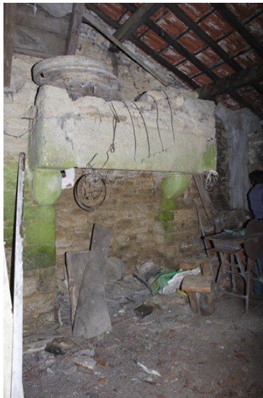
Communs. Cheminée en remploi (?). Phot. Denis Pillet IVR52_20084402185NUCA
