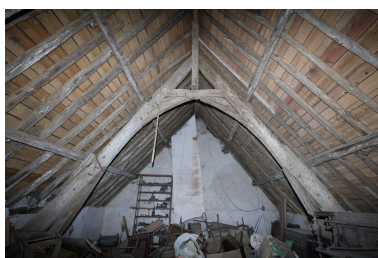
Logis. Charpente. Vue d'une ferme. Phot. Denis Pillet IVR52_20084402199NUCA
