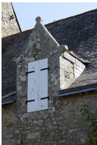
Aile nord. Façade est. Lucarne. Phot. Denis Pillet IVR52_20084402182NUCA
