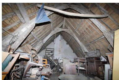
Logis. Charpente. Vue d'ensemble. Phot. Denis Pillet IVR52_20084402198NUCA
