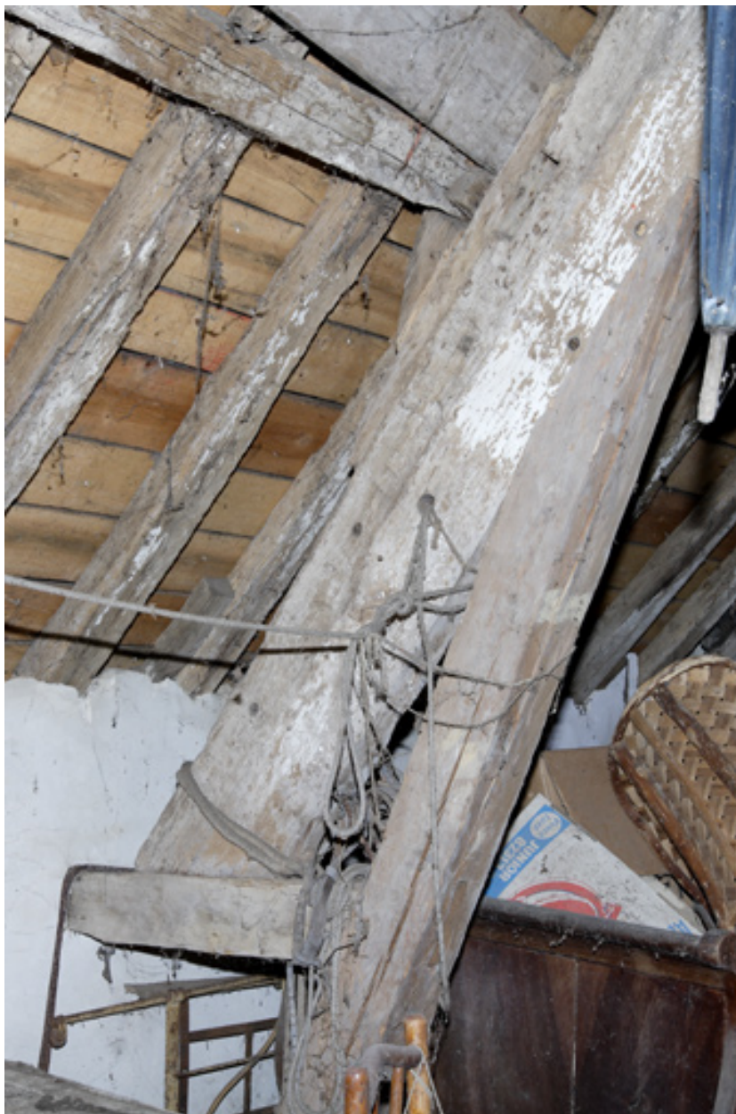
Logis. Charpente. Détail d'un arbalétrier.
