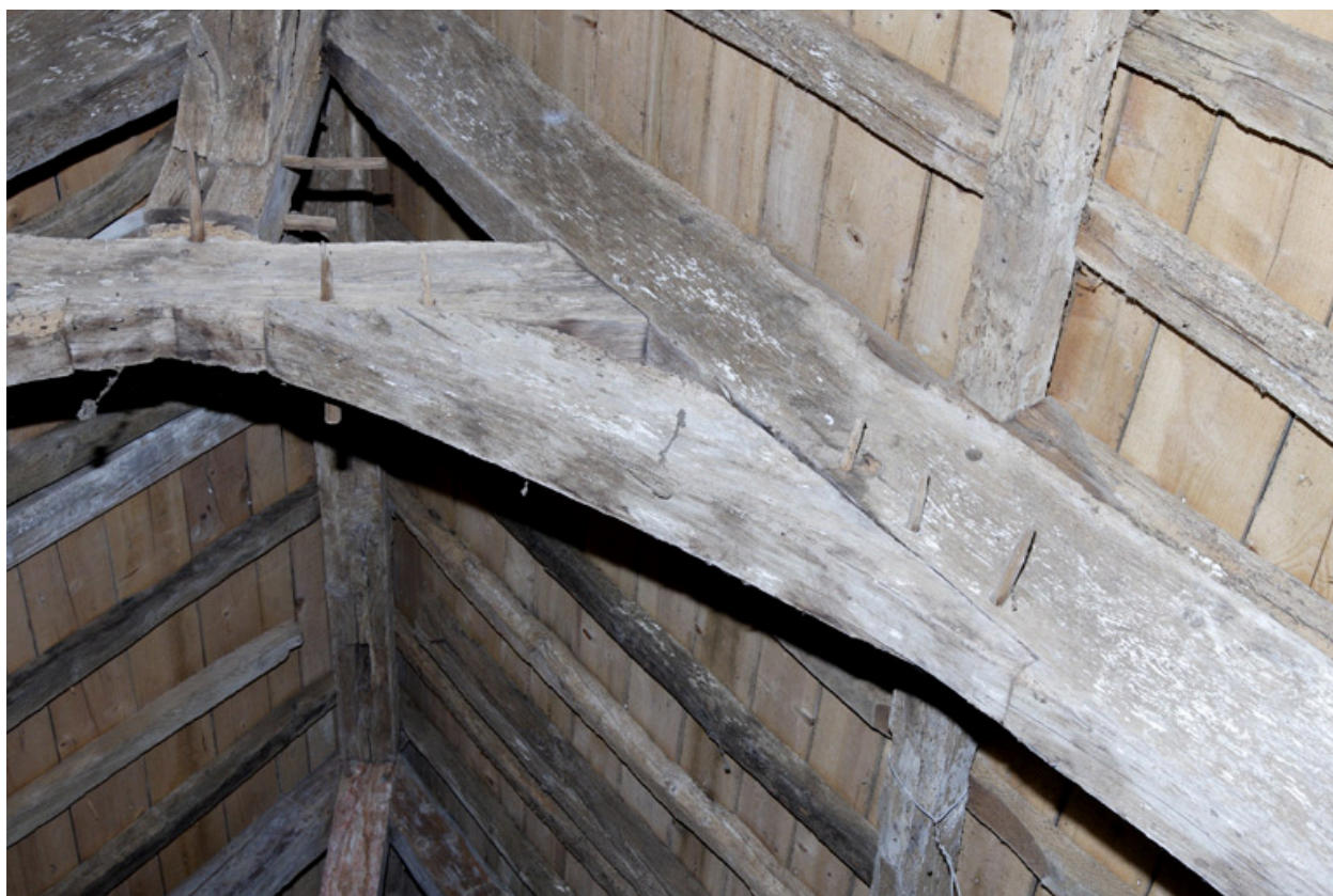
Logis. Charpente. Détail d'un lien.
