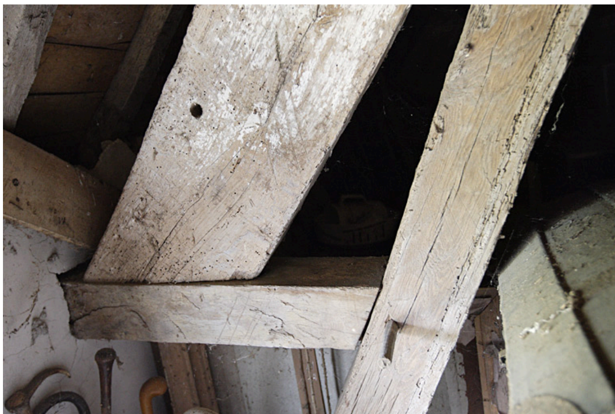
Logis. Charpente. Détail du blochet.
