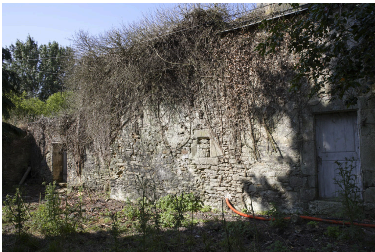
Aile nord. Façade ouest.
