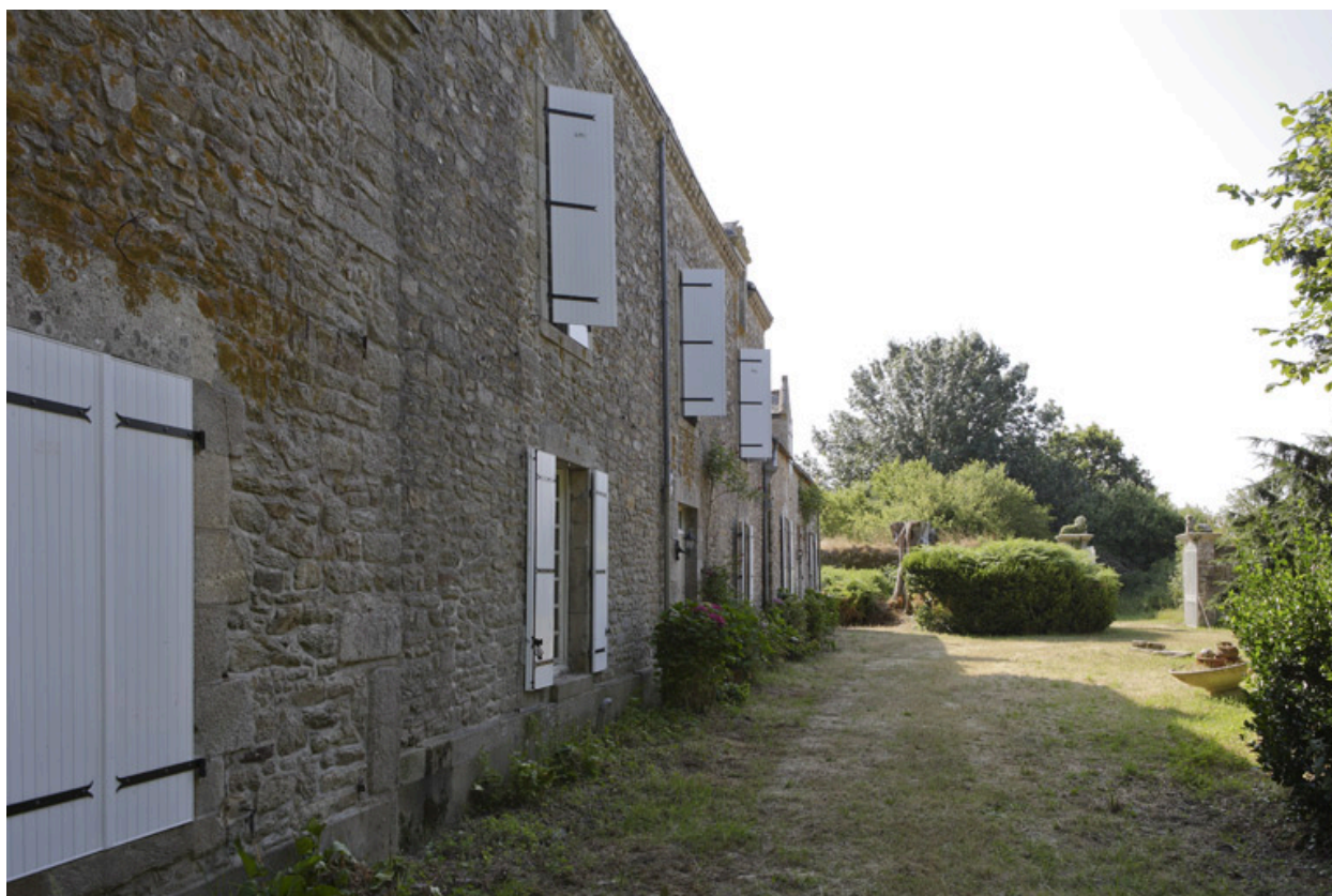
Logis. Façade est.
