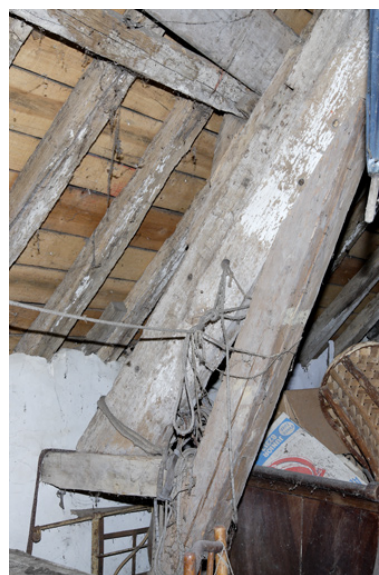
Logis. Charpente. Détail d'un arbalétrier. Phot. Denis Pillet IVR52_20084402197NUCA
