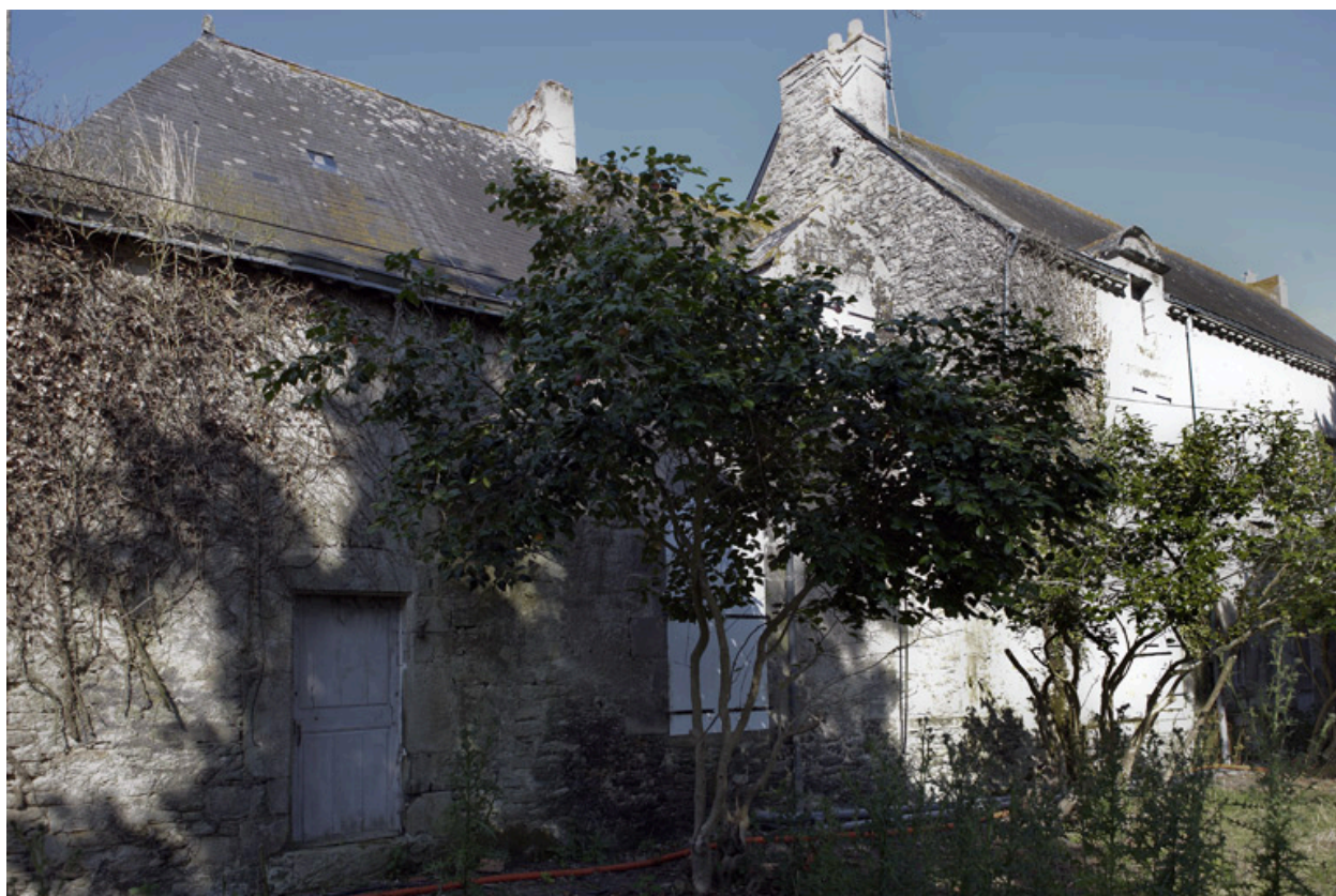
Aile sud. Façade est.
