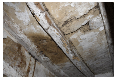
Aile sud. Détail du plafond en torchis. Phot. Denis Pillet IVR52_20084402177NUCA
