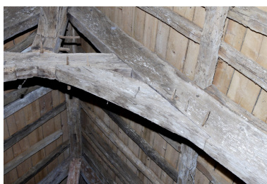
Logis. Charpente. Détail d'un lien. Phot. Denis Pillet IVR52_20084402201NUCA
