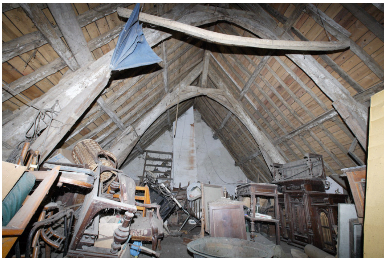
Logis. Charpente. Vue d'ensemble.
