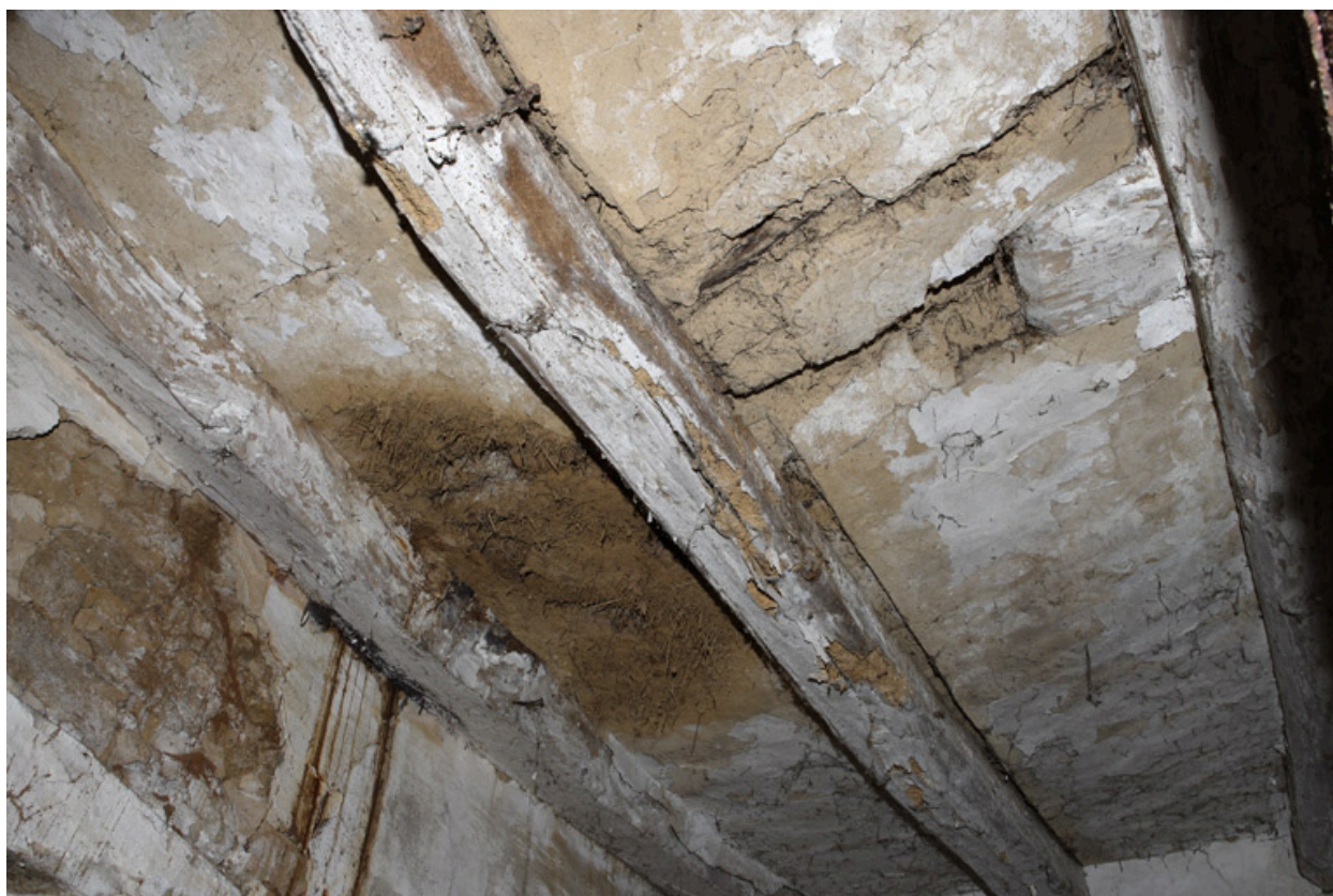
Aile sud. Détail du plafond en torchis.
