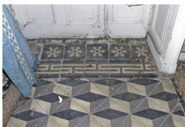
Logis. Vestibule d'entrée. Détail du carrelage. Phot. Denis Pillet IVR52_20084402205NUCA
