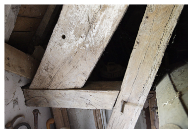
Logis. Charpente. Détail du blochet. Phot. Denis Pillet IVR52_20084402202NUCA
