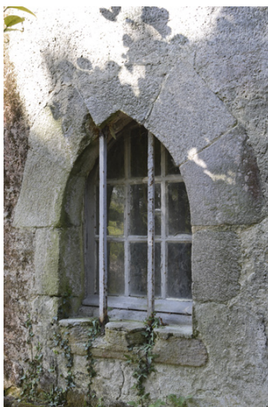
Logis. Façade ouest. Baie. Phot. Denis Pillet IVR52_20084402173NUCA
