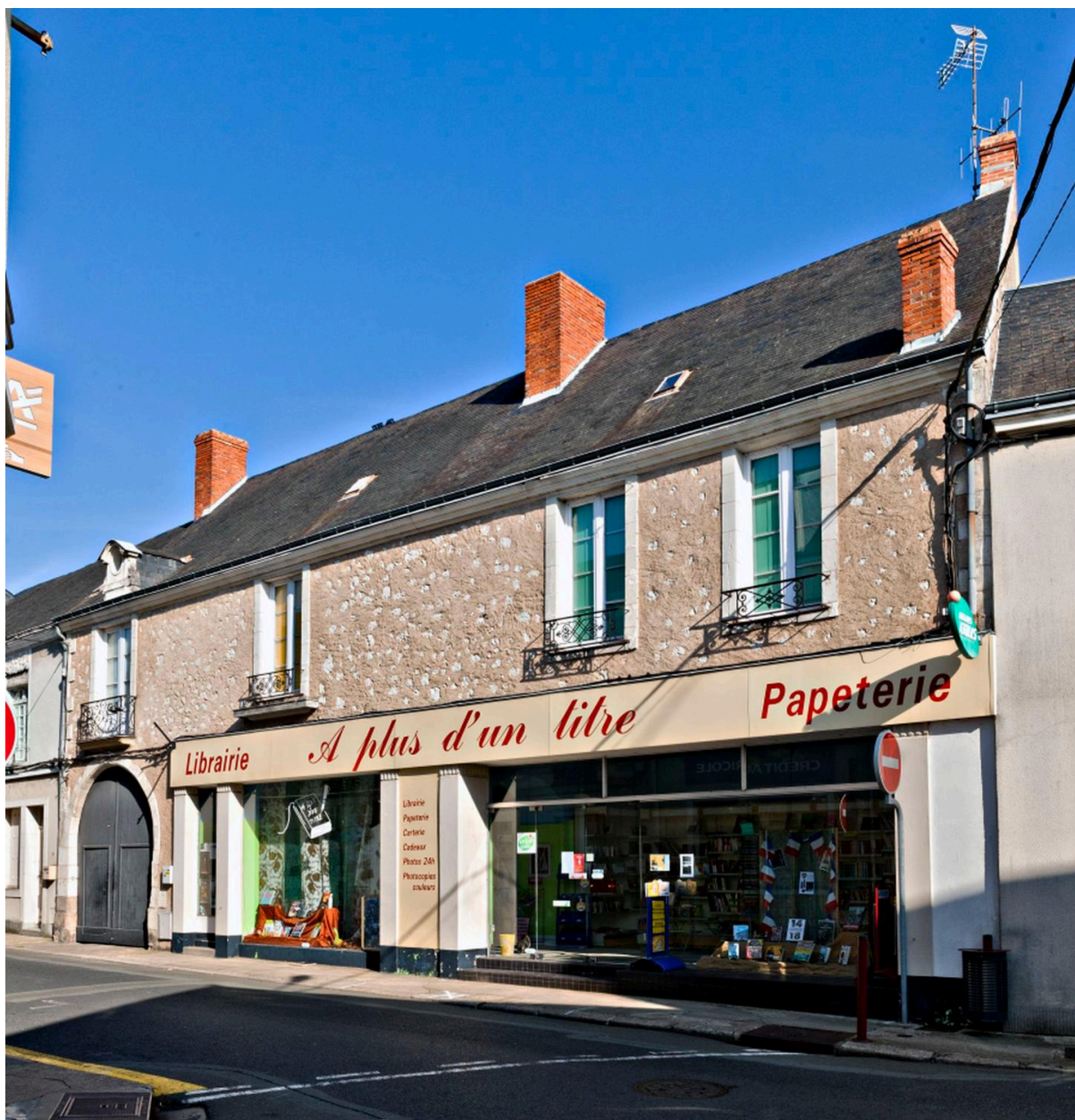
Façade antérieure sur rue, 1ère partie.
