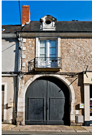
Travée du portail d'entrée de la cour. Phot. Yves Guillotin IVR52_20147202191NUCA
