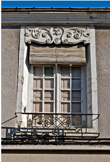
Baie du premier étage : menuiseries anciennes. Phot. Yves Guillotin IVR52_20147202195NUCA
