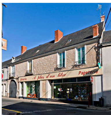
Façade antérieure sur rue, 1ère partie.
