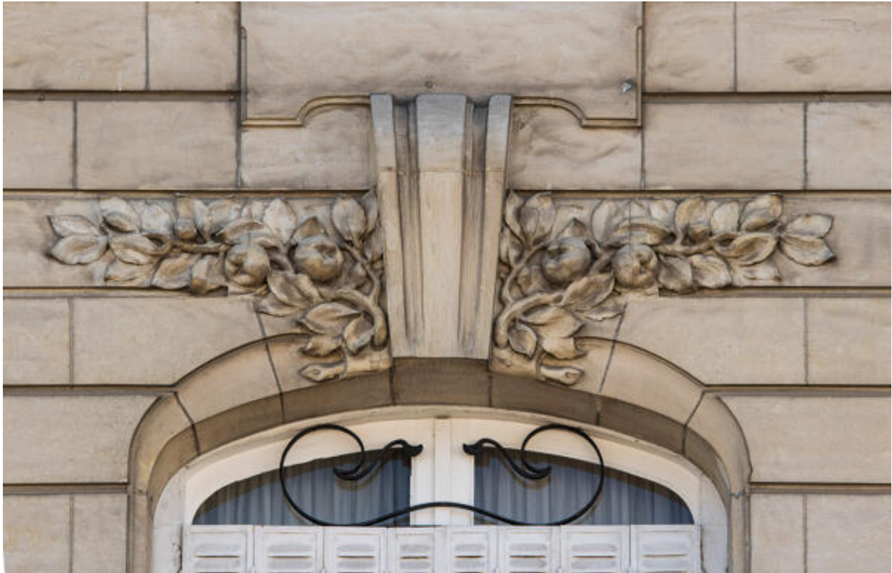
Détail de décor floral de part et d'autre de l'agrafe d'une fenêtre en façade principale d'une maison rue Gambetta.
