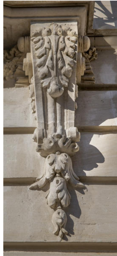
Vue d'une console de balcon sculptée rue Gambetta. Phot. Pierre-Bernard Fourny IVR52_20197201846NUCA
