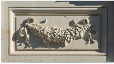
Détail de guirlande de fleurs en façade d'une maison rue du Clos-Margot. Phot. Thierry Seldubuisson IVR52_20237200282NUCA
