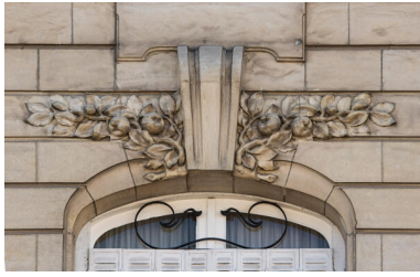
Détail de décor floral de part et d'autre de l'agrafe d'une fenêtre en façade principale d'une maison rue Gambetta. Phot. Thierry Seldubuisson IVR52_20237200386NUCA
