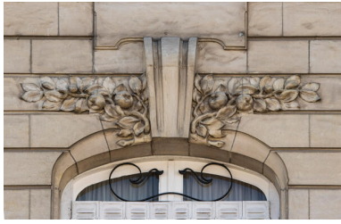
Détail de décor floral de part et d'autre de l'agrafe d'une fenêtre en façade principale d'une maison rue Gambetta. Phot. Thierry Seldubuisson IVR52_20237200386NUCA
