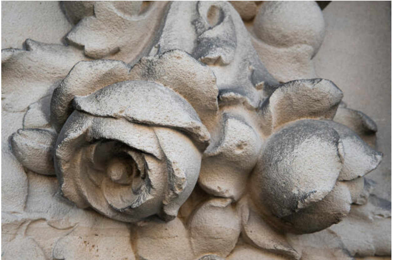
Détail de fleurs sculptées en façade avenue Bollée.
