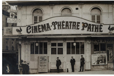
Vue du cinéma Pathé-Royal dont la façade a été réalisée par les sculpteurs Cottureau. Phot. Thierry Seldubuisson IVR52_20237200383NUCA
