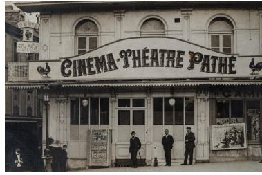
Vue du cinéma Pathé-Royal dont la façade a été réalisée par les sculpteurs Cottereau. Phot. Thierry Seldubuisson IVR52_20237200383NUCA
