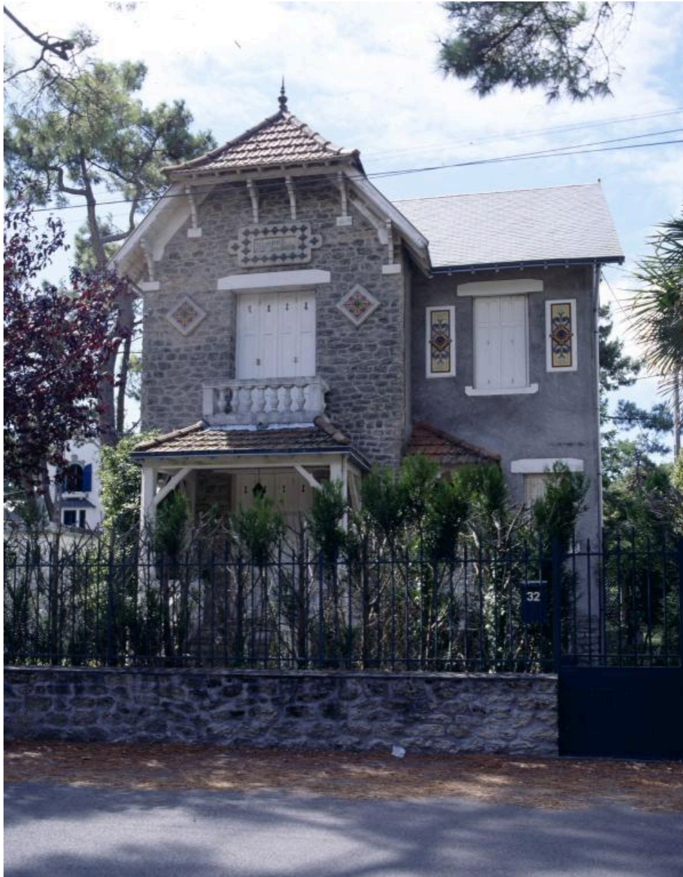
Maison dite villa balnéaire Nymphes des Bois, façade avenue de l'Hallali.
