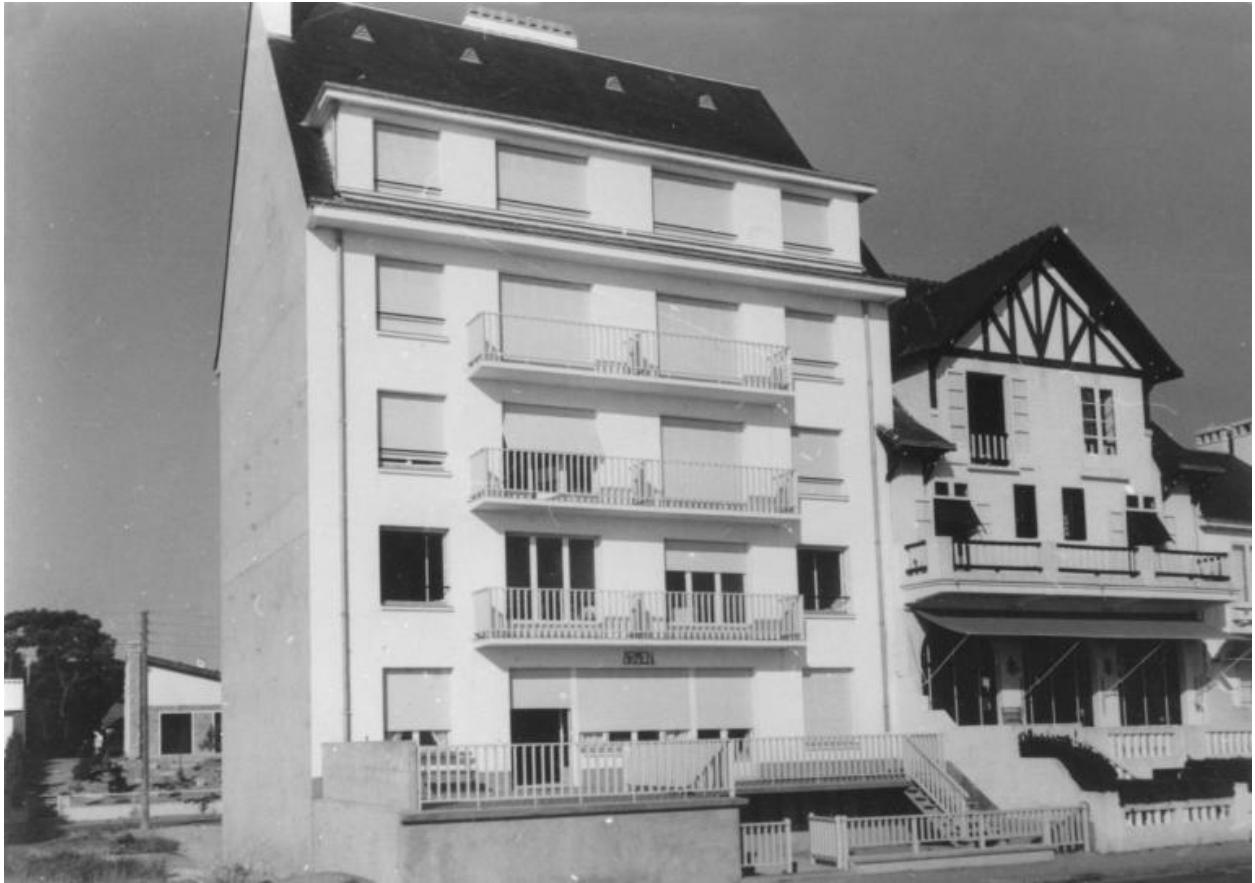
Immeuble Ar Men en 1960 (permis de construire accordé en 1956).
