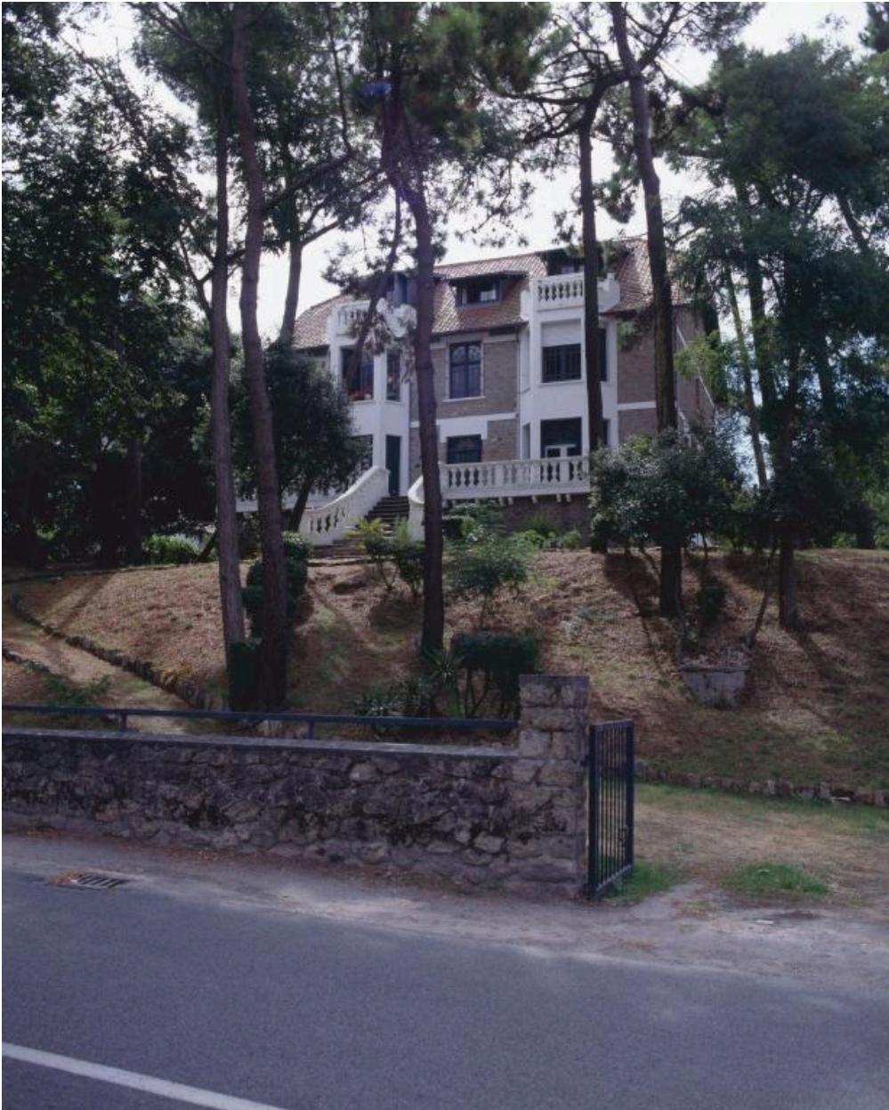
Maison dite villa balnéaire Les Clochettes d'Arvor actuellement immeuble à logements, façade avenue de Josselin (arrière du 23 avenue Duguesclin).
