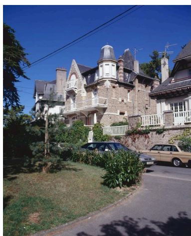
Villa Capella et ses voisines avenue de la Voie Lactée. Phot. Denis Pillet IVR52_19964401366XA
