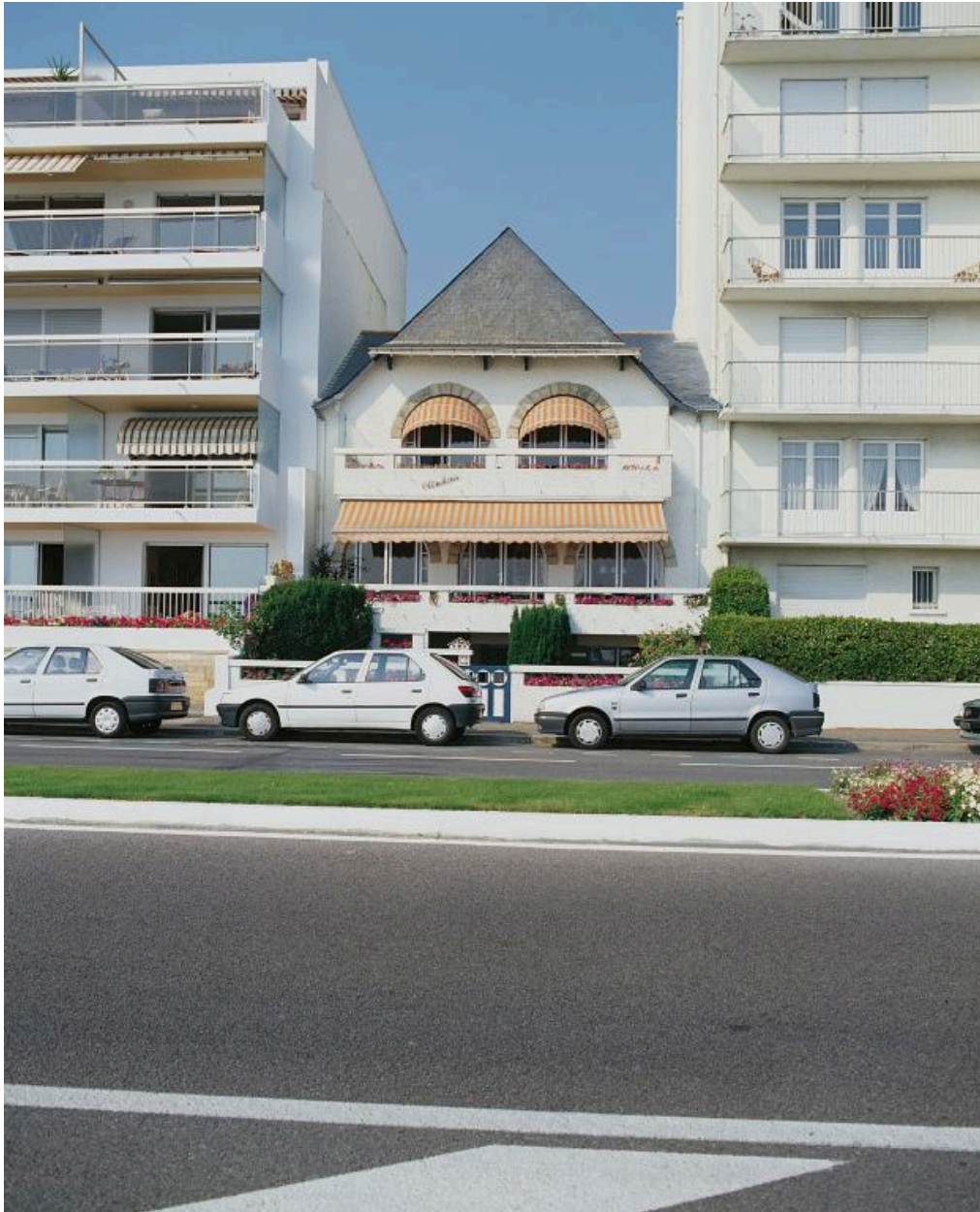
Maison dite villa balnéaire Ainhoa, façade boulevard de l'Océan.
