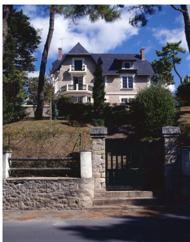
Maison dite villa balnéaire Les Capucines, façade avenue des Pléiades. Phot. Denis Pillet IVR52_19964401419XA
