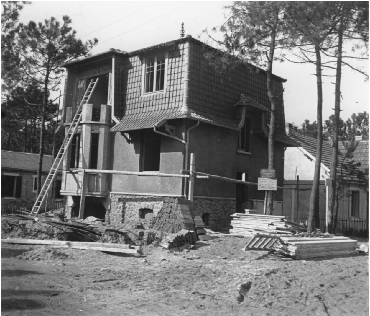
Maison de villégiature Petite Jeannette, villa en construction derrière le garage Minot.
