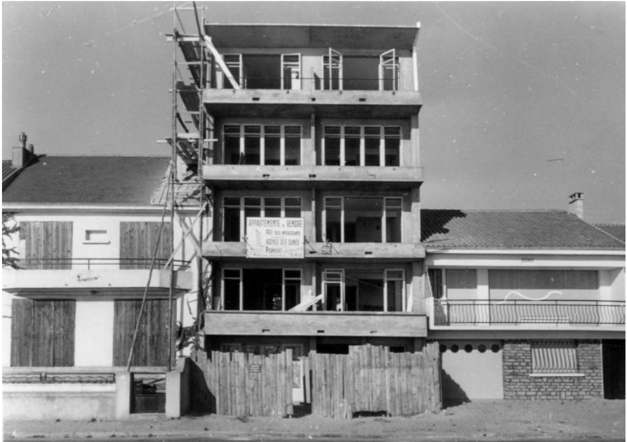
Immeuble La Sirène (permis de construire accordé en 1959).
