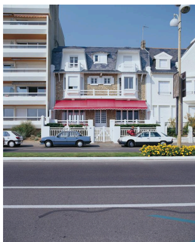
Maison dite villa balnéaire Achilleïs, façade boulevard de l'Océan. Phot. Denis Pillet IVR52_19964401307XA
