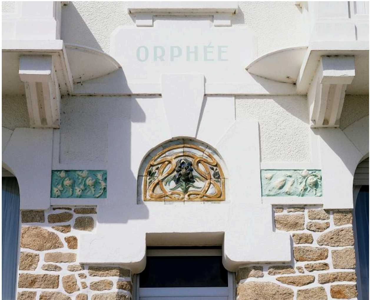
Iris art nouveau en céramique architecturale au-dessus de la porte d'entrée de la villa Orphée.
