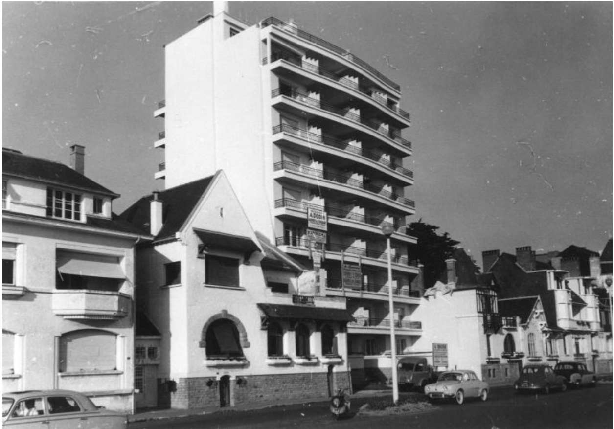
Immeuble à appartements Le Panorama, vu du sud-ouest (permis de construire accordé en 1955).
