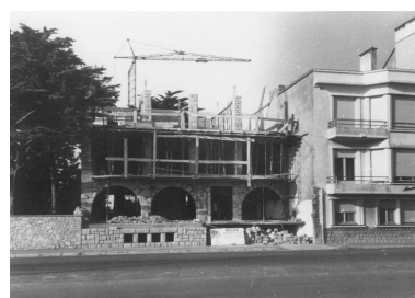
Immeuble à appartements Malgorn en construction en 1960 à la place de la villa du même nom (permis de construire accordé en 1959). Phot. François Lasa IVR52_19934401168X
