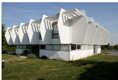
Siège du Groupe SAC (rue de Bretagne). Phot. Bruno Rousseau, Phot. Youenn Communeau IVR52_20114901296NUCA
