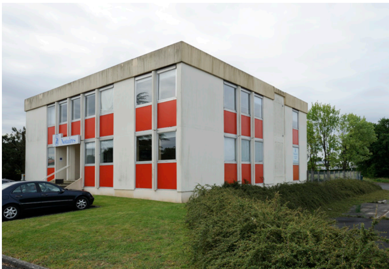
Ancien siège social de l'entreprise de BTP Chupin, composé à l'origine de quatre tours.
