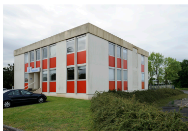
Ancien siège social de l'entreprise de BTP Chupin, composé à l'origine de quatre tours. Phot. Bruno Rousseau, Phot. Youenn Communeau IVR52_20114901511NUCA
