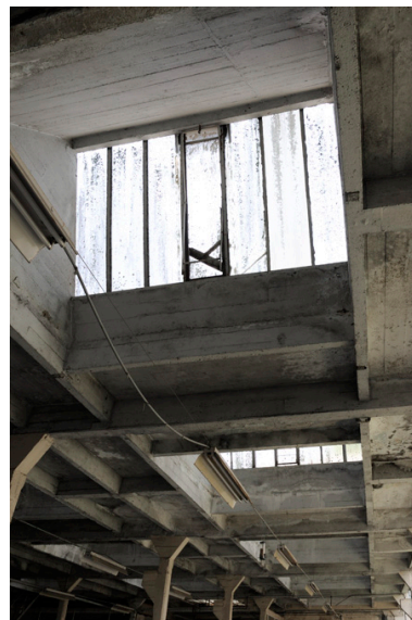
Vue intérieure des sheds. Phot. Bruno Rousseau, Phot. Youenn Communeau IVR52_20114901138NUCA
