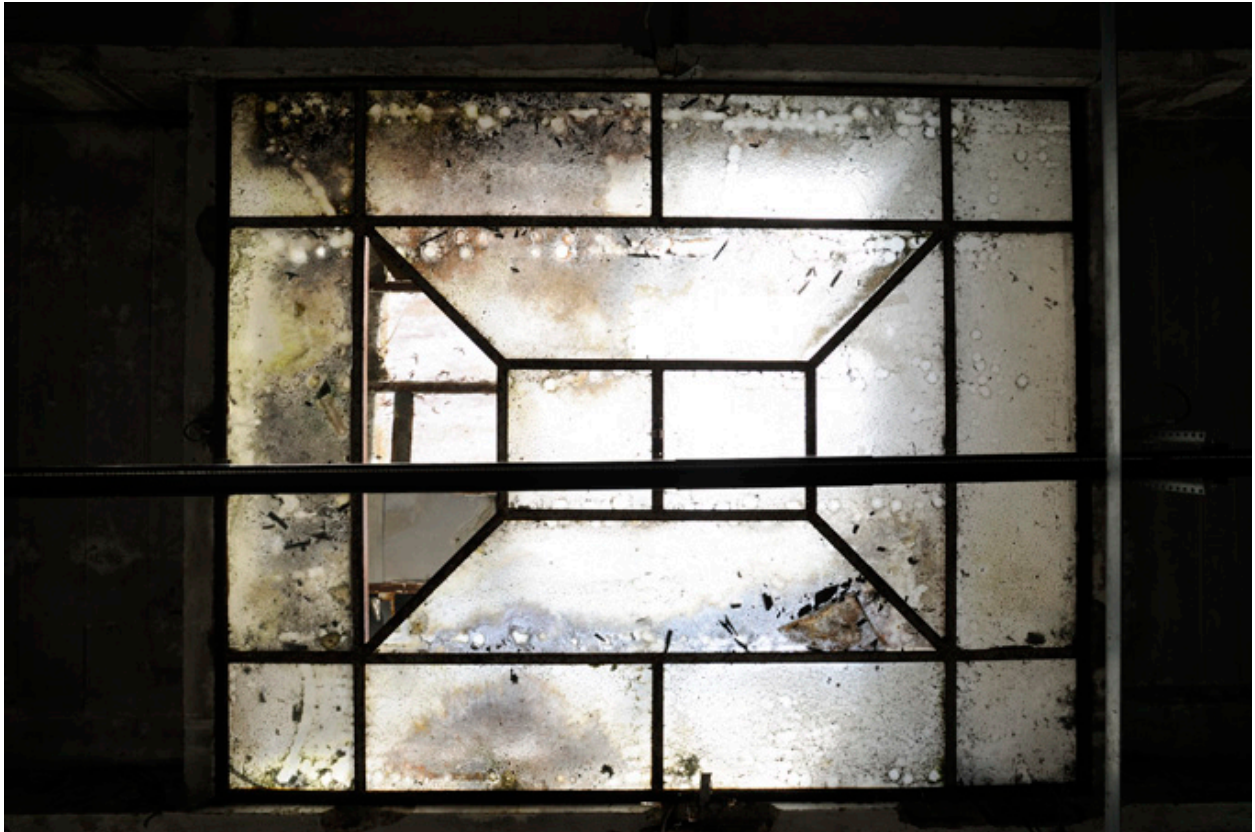
Détail de la verrière, présente à l'entrée de l'usine.
