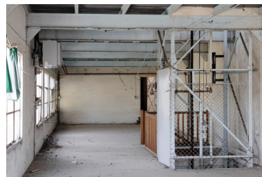
Escalier et monte-charge, du bâtiment construit en 1948. Phot. Bruno Rousseau, Phot. Youenn Communeau IVR52_20114901123NUCA
