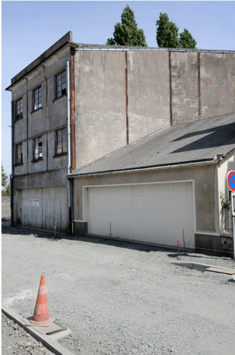
L'usine Repussard-Chupin, vue depuis la rue d'Anjou.
