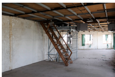
Vue intérieure (2e étage) du bâtiment construit en 1948. Phot. Bruno Rousseau, Phot. Youenn Communeau IVR52_20114901124NUCA
