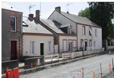
Maisons ouvrières probablement liées à l'usine Repussard-Chupin. Phot. Bruno Rousseau, Phot. Youenn Communeau IVR52_20114901120NUCA
