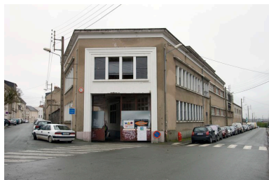
Conciergerie de l'usine, accolée à la maison d'Yves Repussard. Phot. Yves Guillotin IVR52_20114900150NUCA
