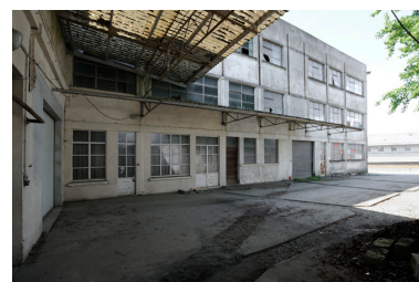
Vue générale de l'usine Repussard-Chupin, depuis le nord-est. Phot. Bruno Rousseau, Phot. Youenn Communeau IVR52_20114901145NUCA
