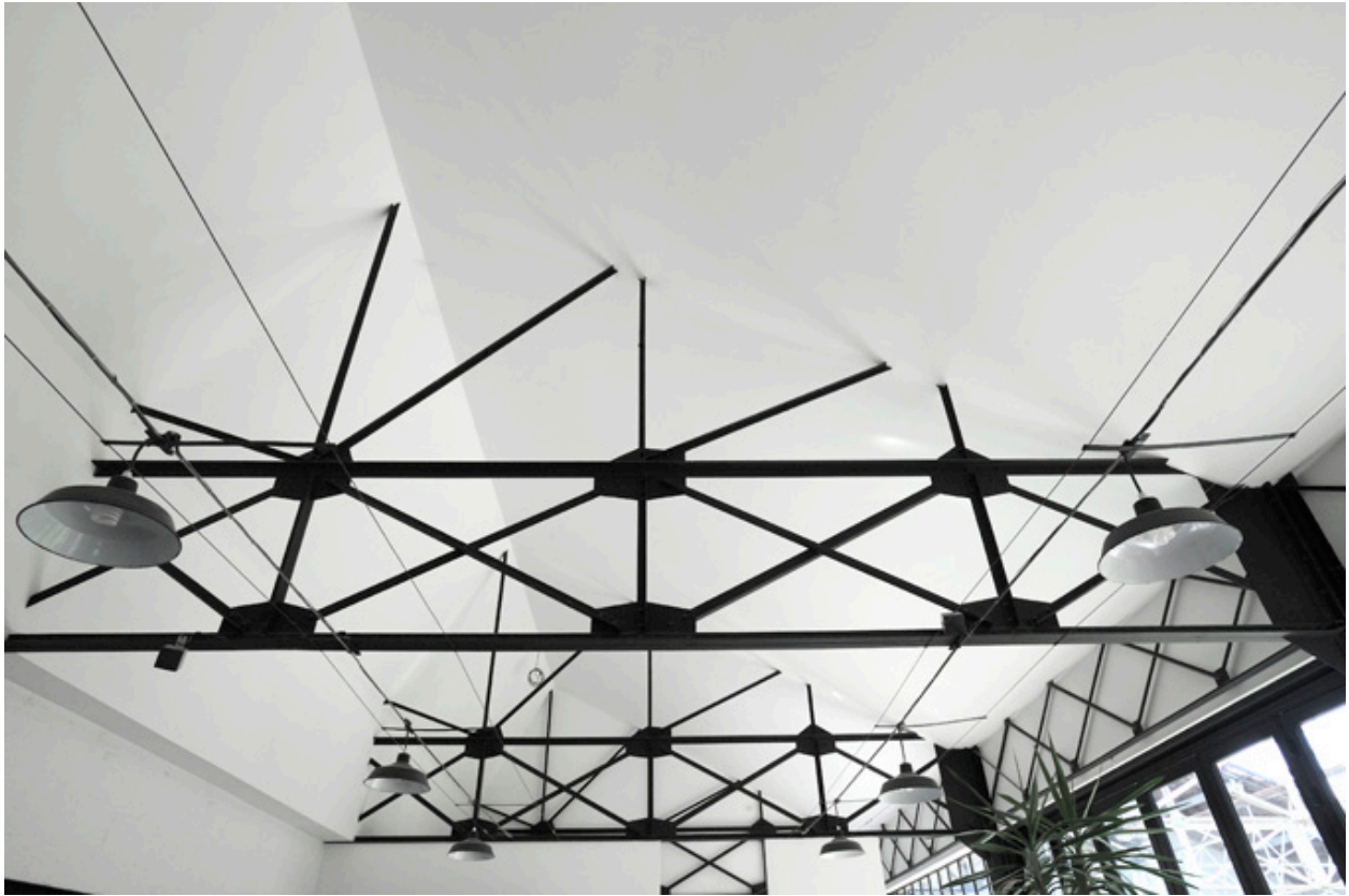
Détail de la charpente métallique.
