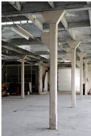
Détail des piliers en béton et de leurs corbeaux. Phot. Bruno Rousseau, Phot. Youenn Communeau IVR52_20114901134NUCA
