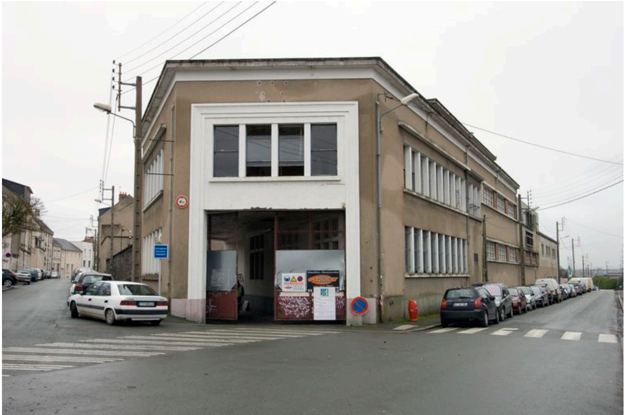
Conciergerie de l'usine, accolée à la maison d'Yves Repussard.
