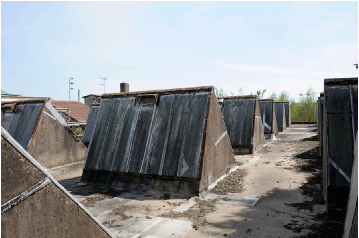
Le toit terrasse ouvert par des sheds de la première usine.
