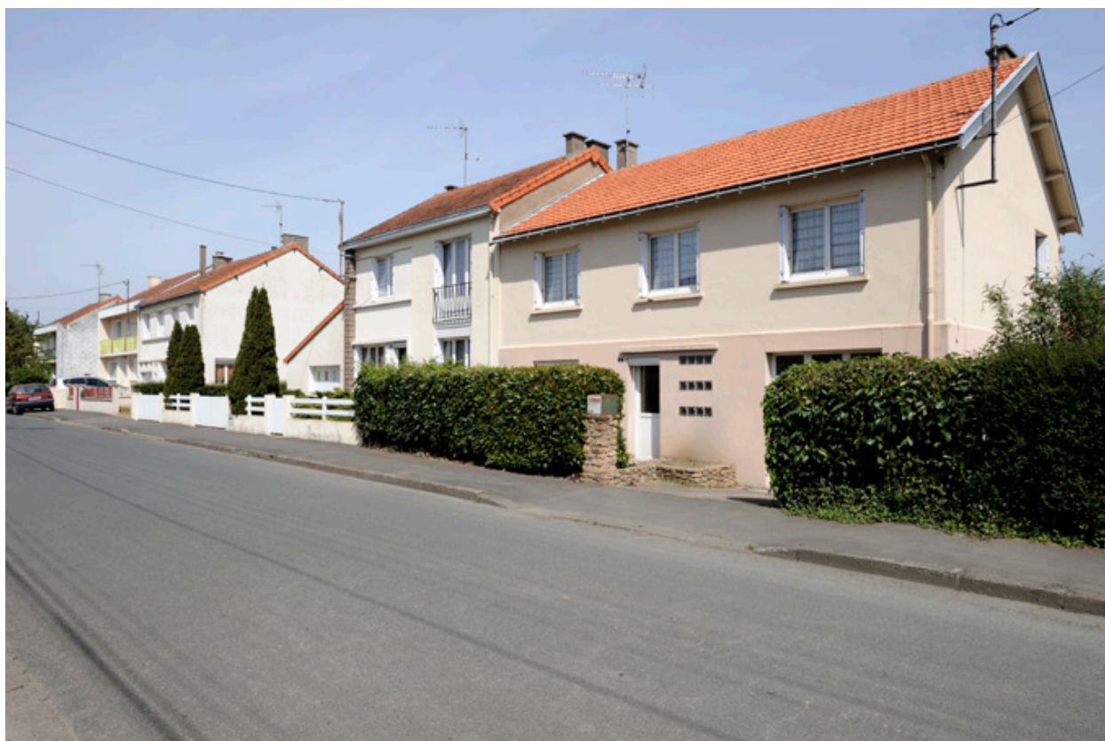
Lotissement Le champs du bois vert, rue Gambetta, construit entre 1958-1959.
