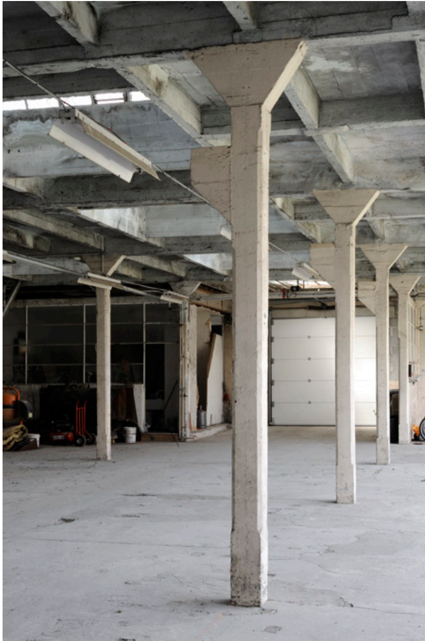
Détail des piliers en béton et de leurs corbeaux.
