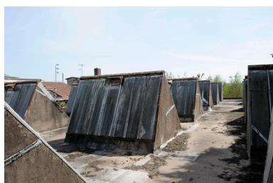
Le toit terrasse ouvert par des sheds de la première usine. Phot. Bruno Rousseau, Phot. Youenn Communeau IVR52_20114901125NUCA
