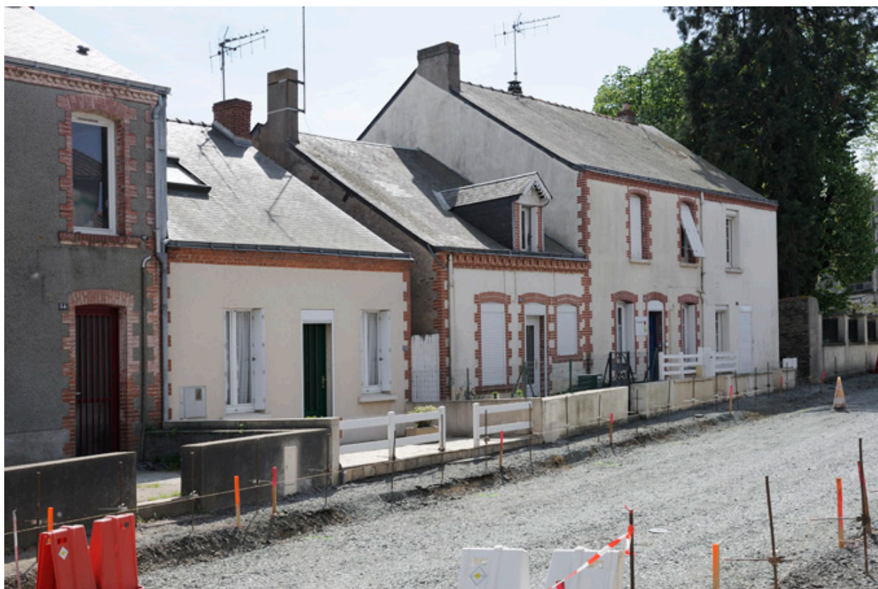
Maisons ouvrières probablement liées à l'usine Repussard-Chupin.
