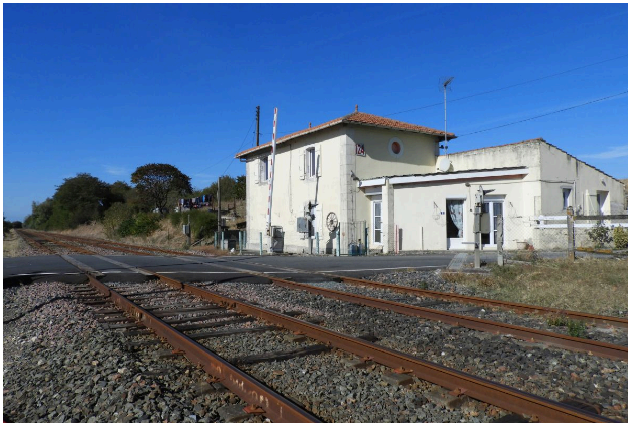
La maison de garde-barrière vue depuis l'est.
