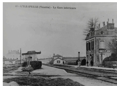
Carte postale vers 1900 montrant, au centre, la maison de garde-barrière qui se trouvait au croisement entre la voie ferrée et l'avenue de la Gare. Phot. Yannis (reproduction) Suire IVR52_20198501110NUCA
