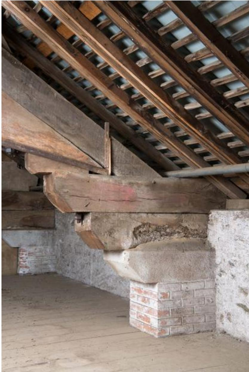
À l'étage de l'usine, la charpente s'appuie sur des piliers en briques.
