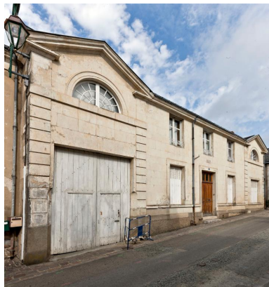
Maison, façade sur rue prise depuis le sud-est. Phot. Yves Guillotin IVR52_20127201089NUCA
