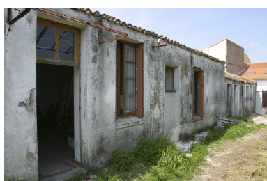
Les pièces en appentis contre le mur mitoyen à l'ouest. Phot. Denis Pillet IVR52_20034400311NUCA
