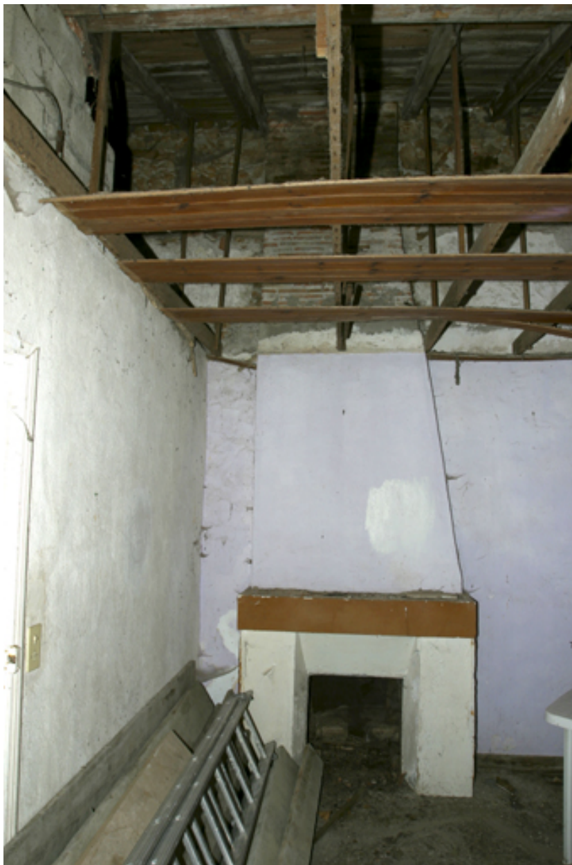
Les pièces en appentis situées à l'ouest, détail d'une cheminée.
