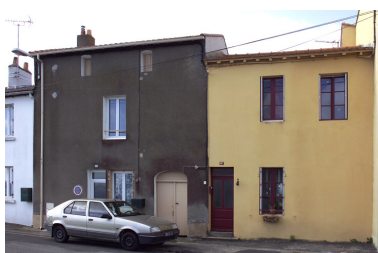
Vue d'ensemble depuis le quai. Phot. Denis Pillet IVR52_20044401903NUCA
